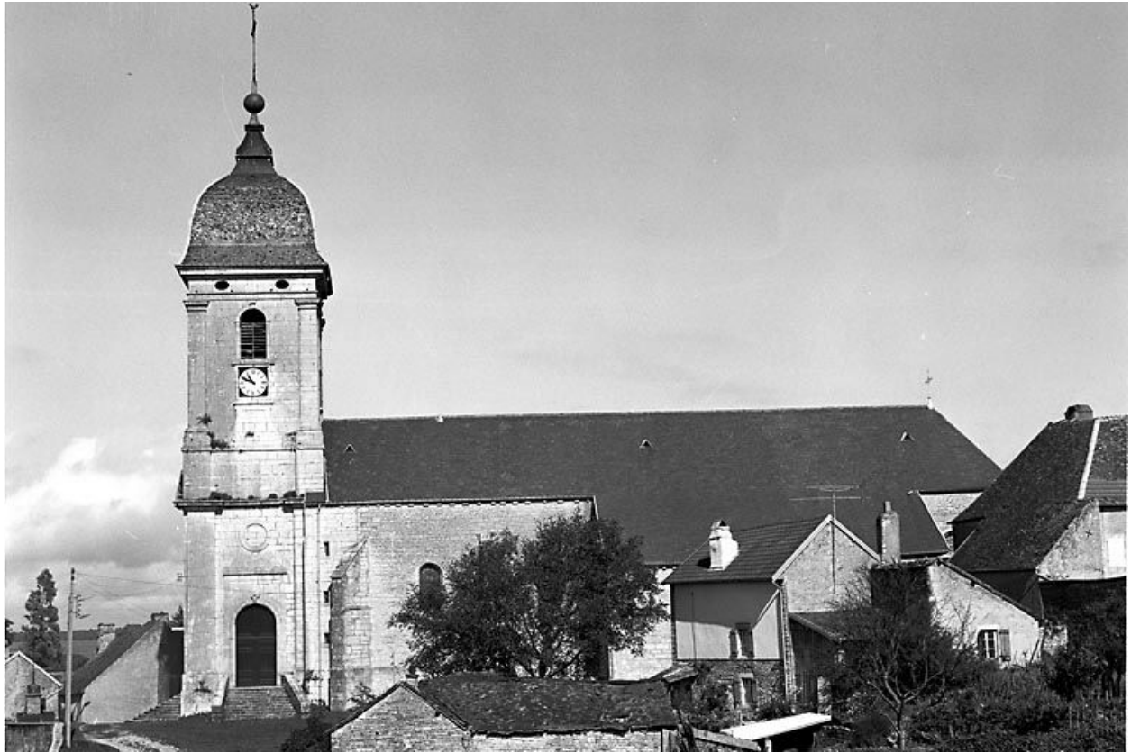
Façade latérale droite.
