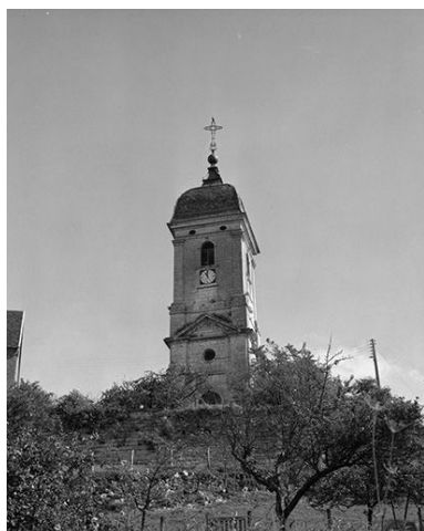
Vue du clocher. Phot. Yves Sancey IVR43_19757000073X
