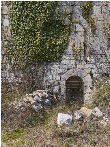
Porte d'accès à la fausse braie. Phot. Thierry Kuntz IVR43_20223900527NUC4A
