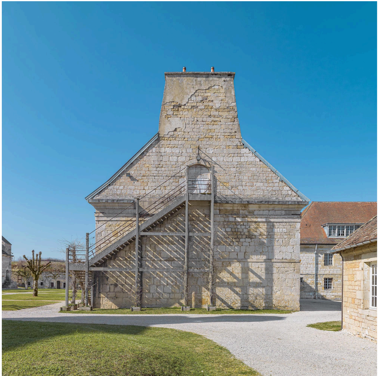
Caserne U : mur pignon est.
