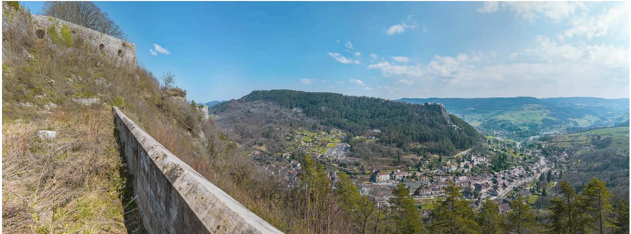
Parapet de la fausse braie (sud-est).
