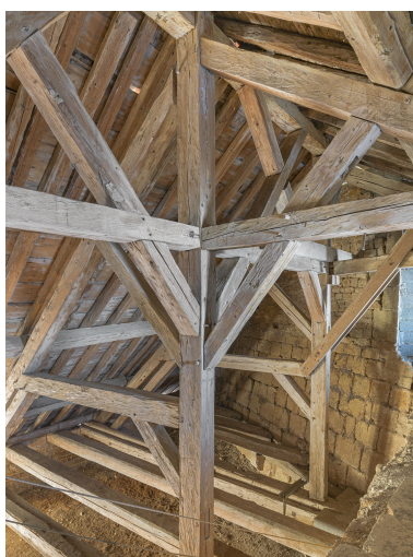
Pavillon d'entrée : détail de la charpente. Phot. Thierry Kuntz IVR43_20213900389NUC4A
