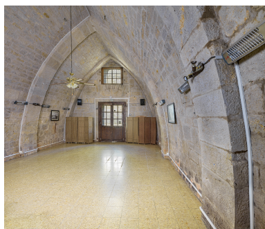
Poudrière : vue intérieure. Phot. Thierry Kuntz IVR43_20213900351NUC4A
