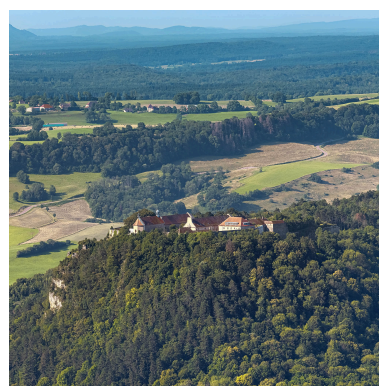
La citadelle, vue depuis le nord. Phot. Thierry Kuntz IVR43_20213900087NUC4A
