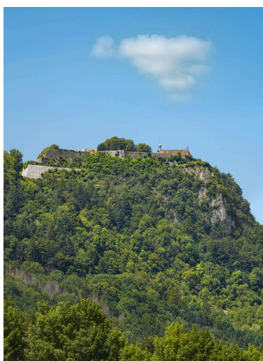
Le rempart du front est. Phot. Thierry Kuntz IVR43_20213900090NUC4A
