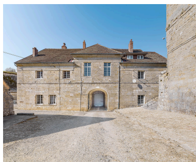
Pavillon d'entrée : façade postérieure.
