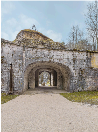
Passage de la demi-lune. Phot. Thierry Kuntz IVR43_20223900484NUC4A
