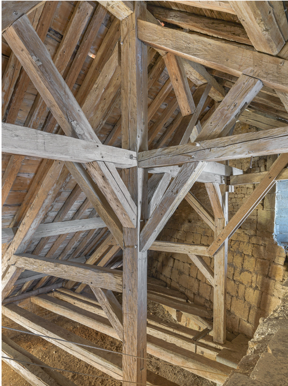
Pavillon d'entrée : détail de la charpente.
