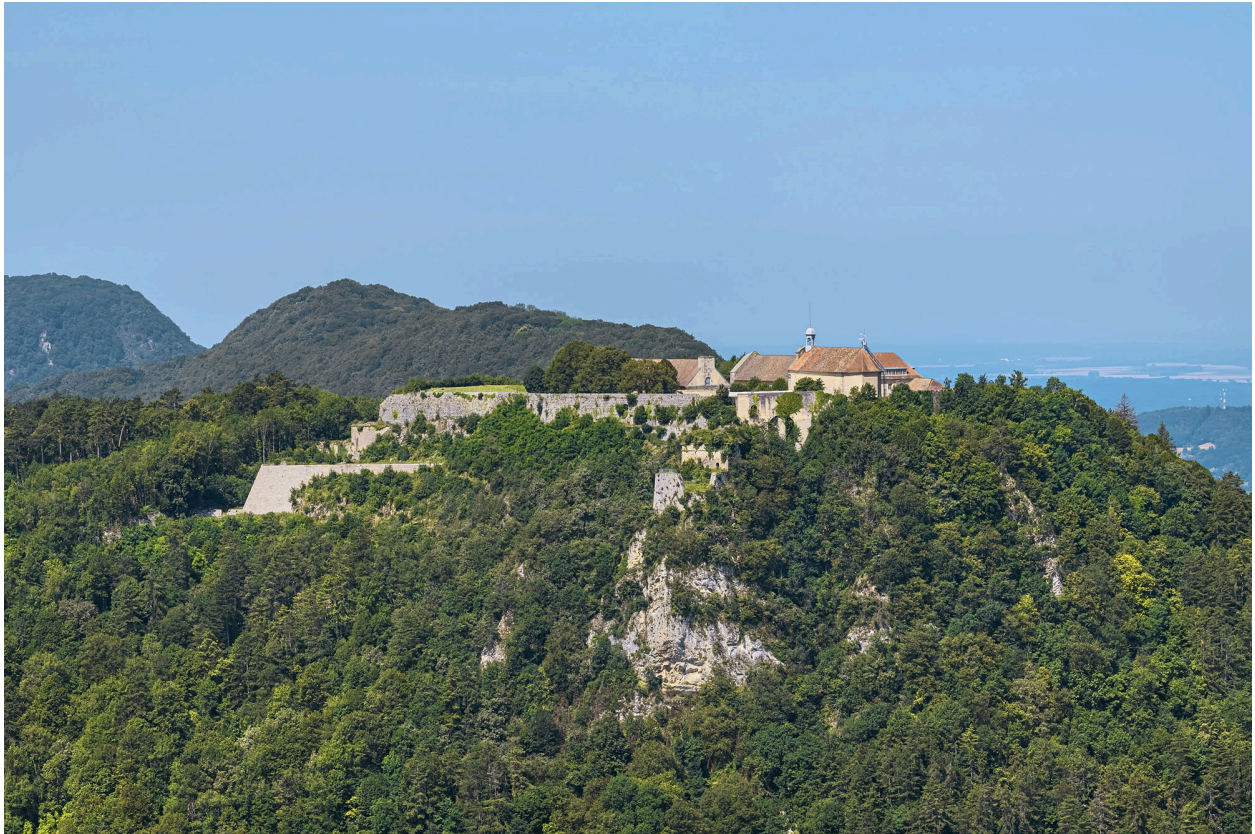
Vue générale depuis l'est.
