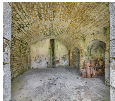
Salles casematées : détail et voûte. Phot. Thierry Kuntz IVR43_20213900342NUC4A
