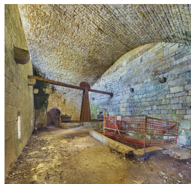
Casemate du demi-bastion est du front d'attaque. Phot. Thierry Kuntz IVR43_20223900584NUC4A
