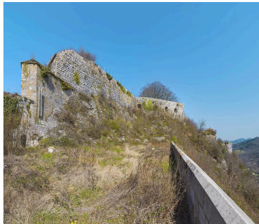
La fausse braie, face sud-est. Phot. Thierry Kuntz IVR43_20223900523NUC4A
