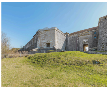
Les bastions encadrant l'entrée principale du fort.
