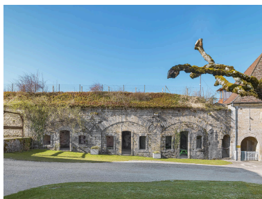
Salles casematées. Phot. Thierry Kuntz IVR43_20223900545NUC4A
