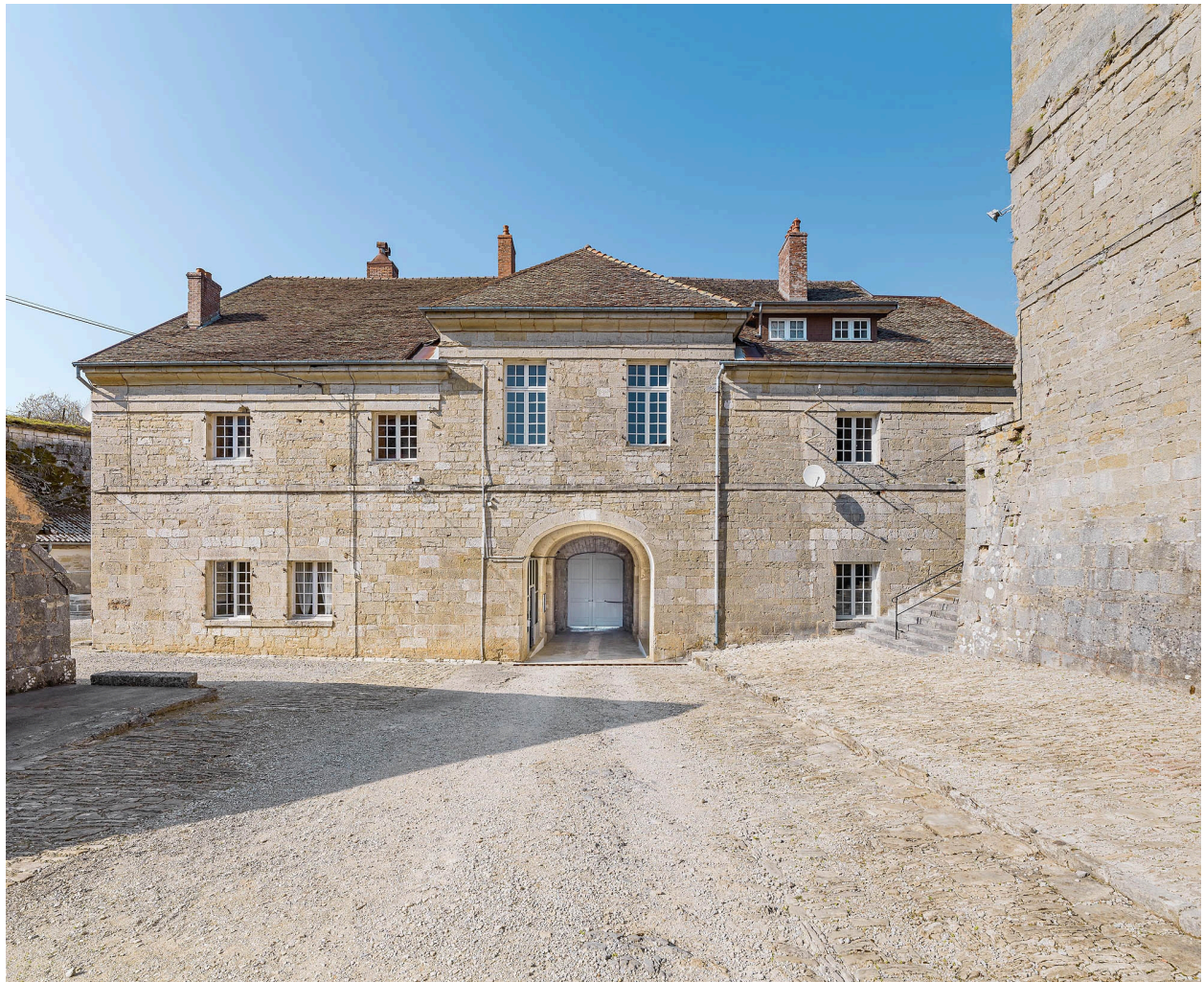
Pavillon d'entrée : façade postérieure.
