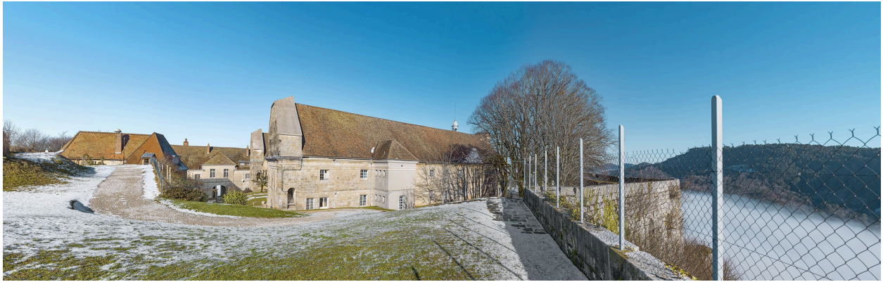
Vue intérieure depuis le sud.
