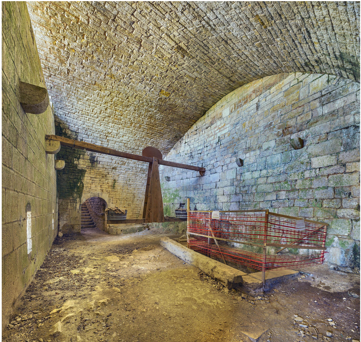
Casemate du demi-bastion est du front d'attaque.
