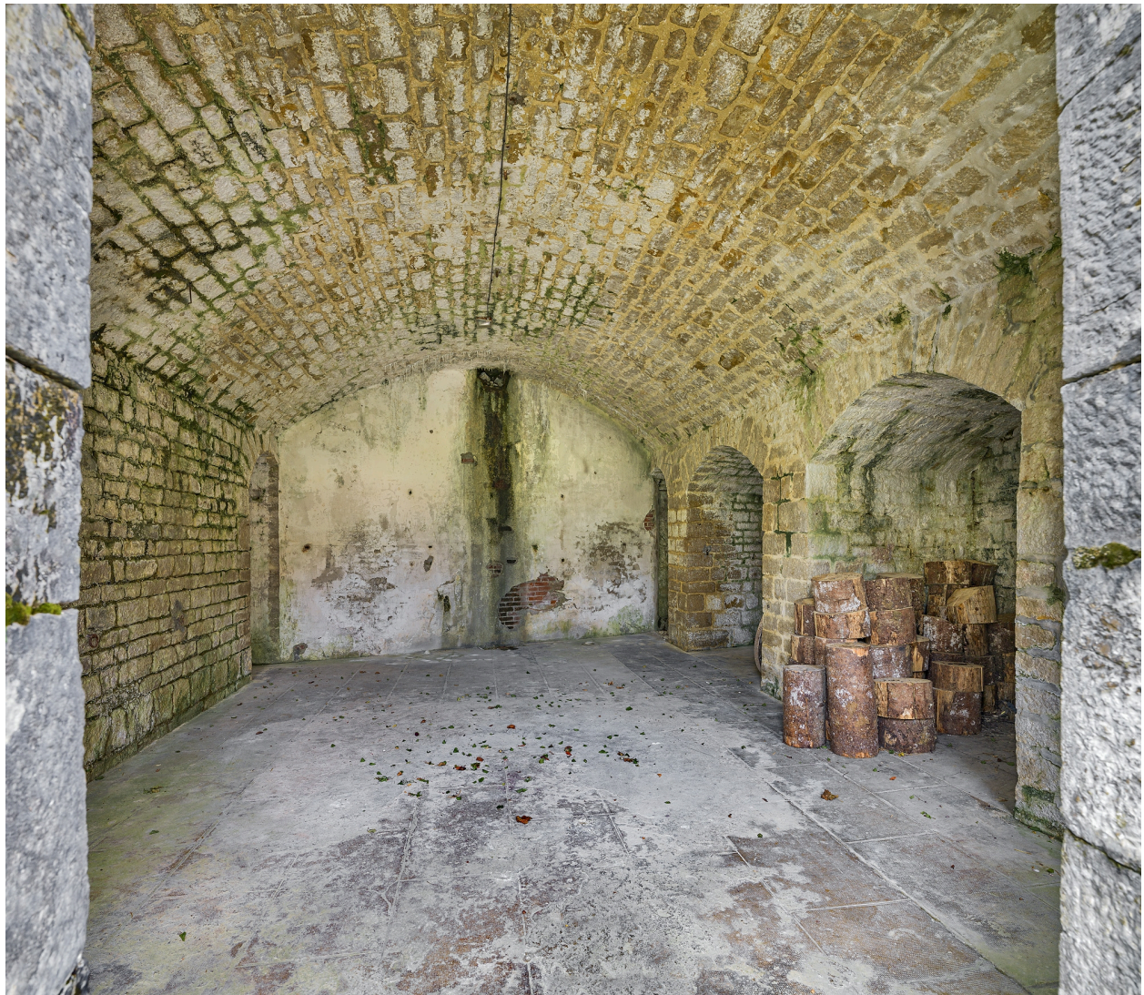
Salles casematées : détail et voûte.
