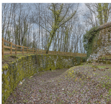
Le fossé et le mur de contrescarpe. Phot. Thierry Kuntz IVR43_20223900500NUC4A
