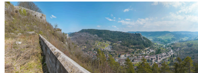
Parapet de la fausse braie (sud-est). Phot. Thierry Kuntz IVR43_20223900525NUC4A
