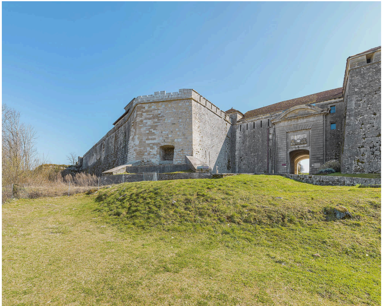
Les bastions encadrant l'entrée principale du fort.
