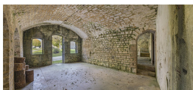
Salles casematées : vue traversante. Phot. Thierry Kuntz IVR43_20213900344NUC4A
