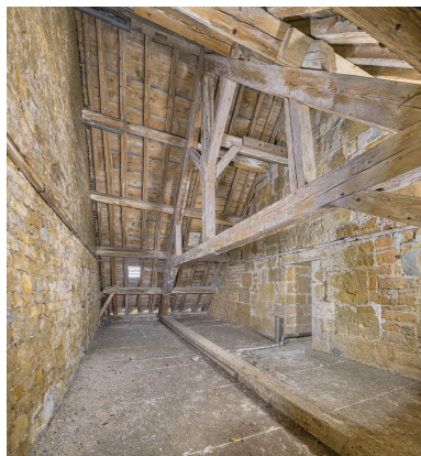
Caserne U : détail d'une ferme de la charpente. Phot. Thierry Kuntz IVR43_20213900397NUC4A
