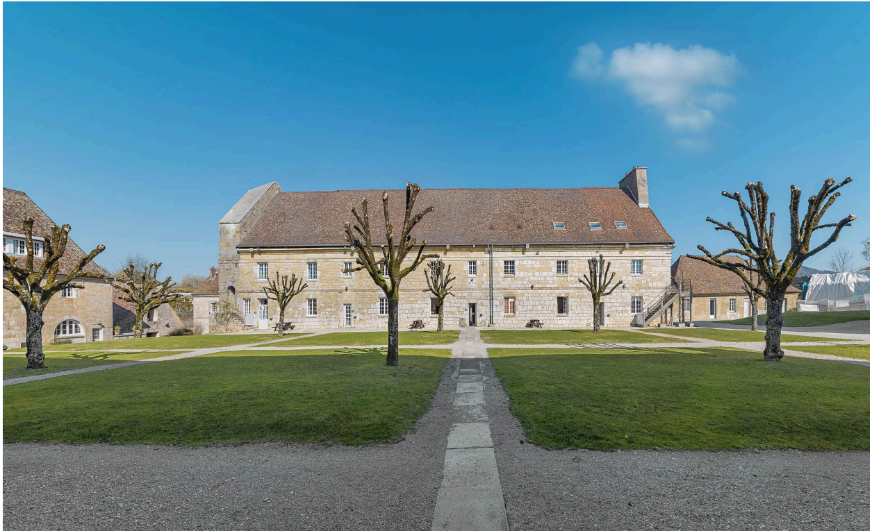
Caserne U : façade antérieure.
