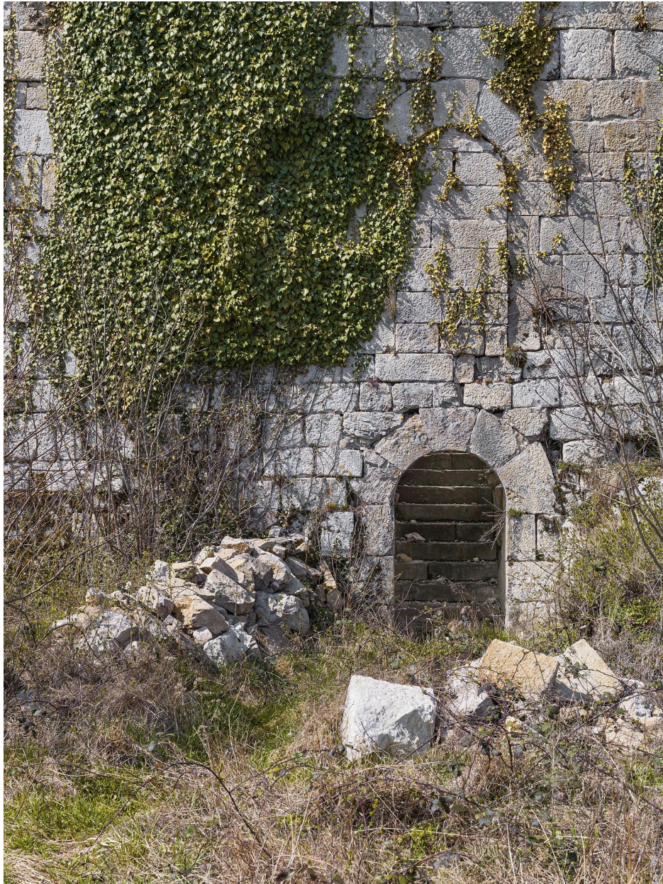
Porte d'accès à la fausse braie.
