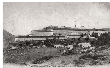
Salins-les-Bains. Les remparts du fort Saint-André (1623). S.d. Phot. Aline Thomas, Autr. auteur inconnu IVR43_20213900132NUC4A
