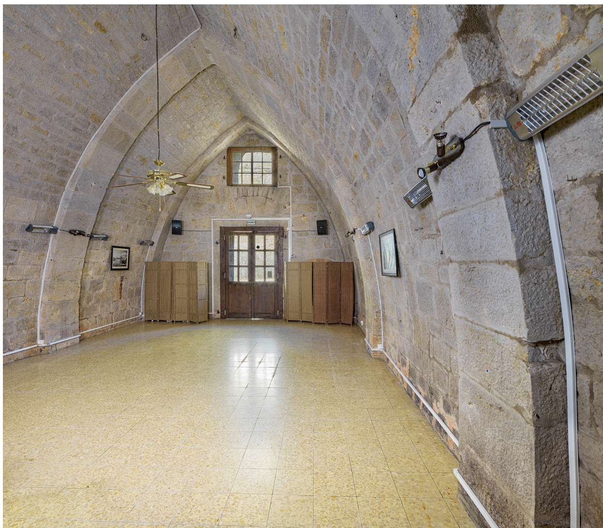
Poudrière : vue intérieure.
