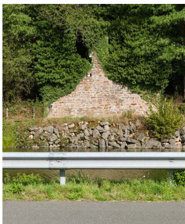
Vestiges de la carrière.
