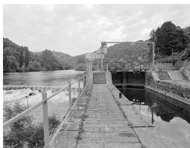
Porte amont de l'écluse et barrage. Phot. Jérôme Mongreville IVR43_20032500434X
