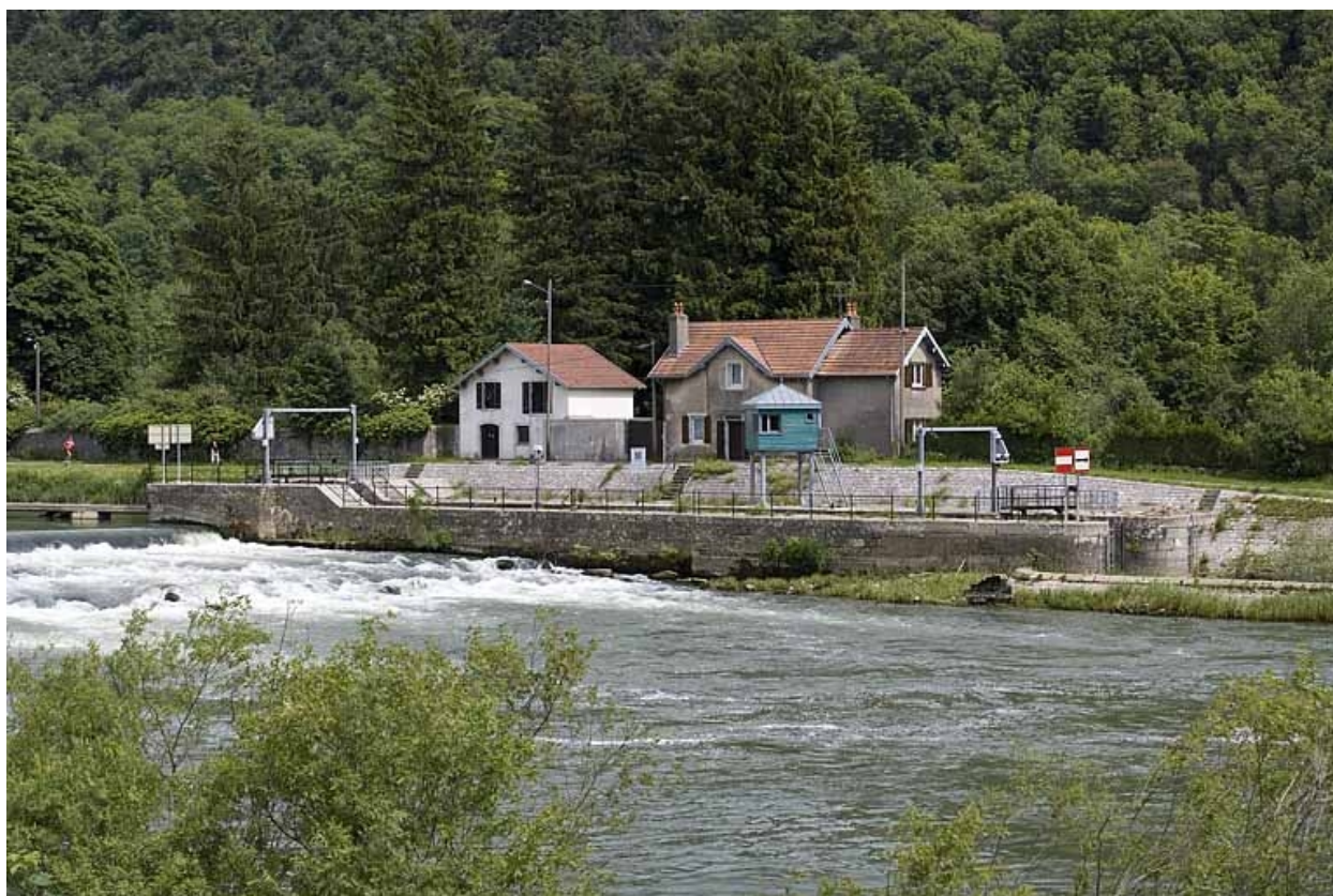
Vue d'ensemble rapprochée, depuis l'aval.
