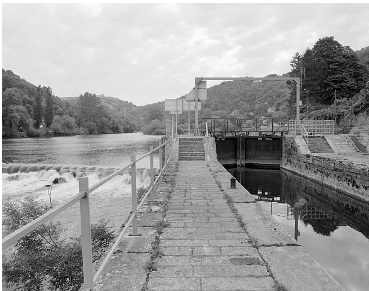
Porte amont de l'écluse et barrage.
