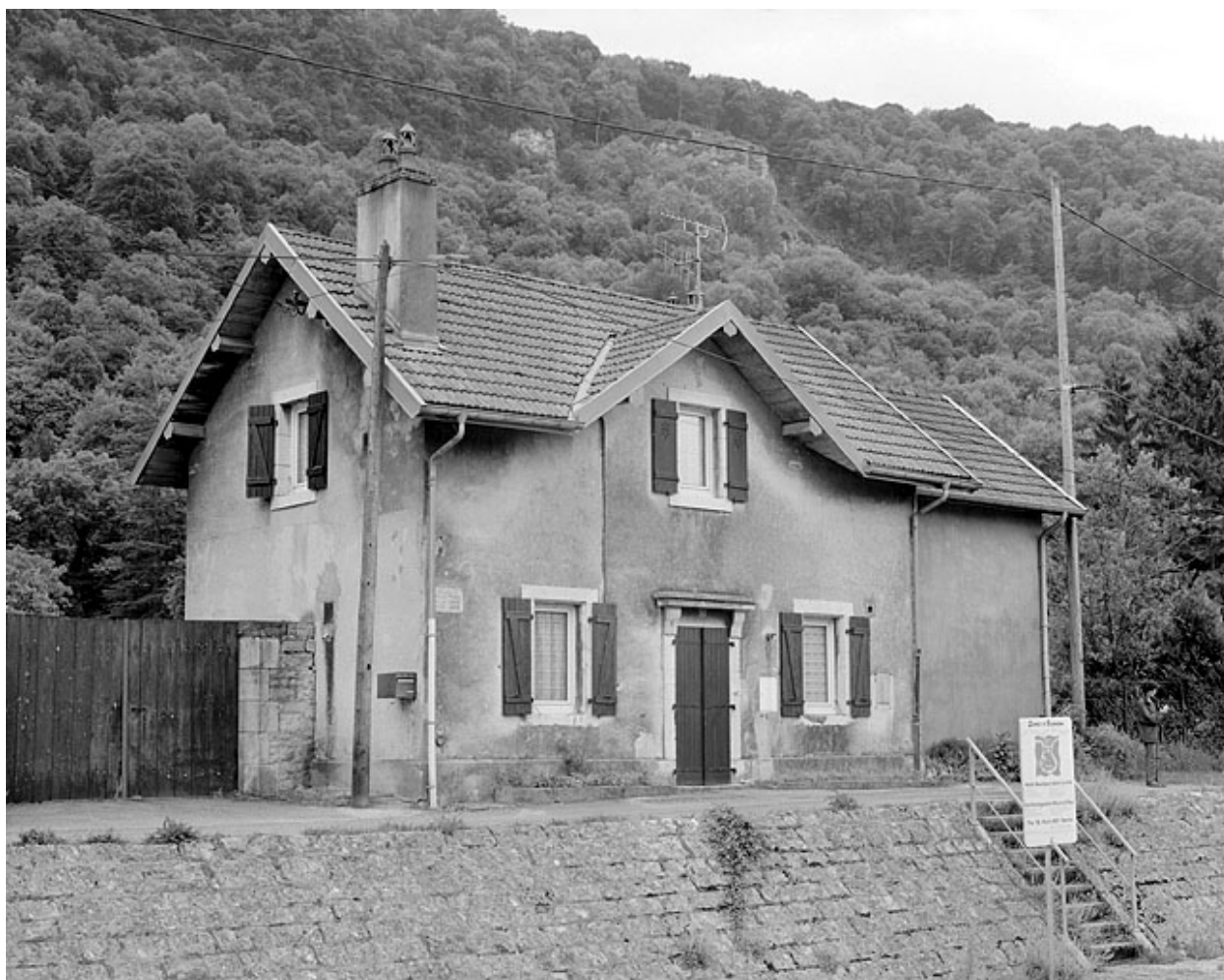
Maison d'éclusier, de trois quarts gauche.
