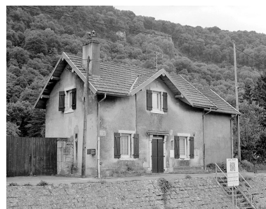
Maison d'éclusier, de trois quarts gauche. Phot. Jérôme Mongreville IVR43_20032500435X
