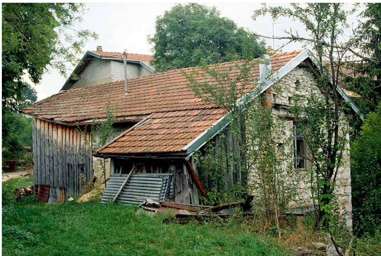
Façades postérieure et latérale droite.
