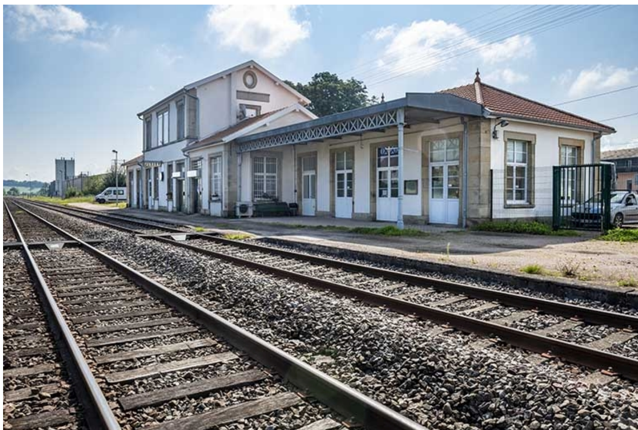
La gare, vue éloignée depuis les voies.
