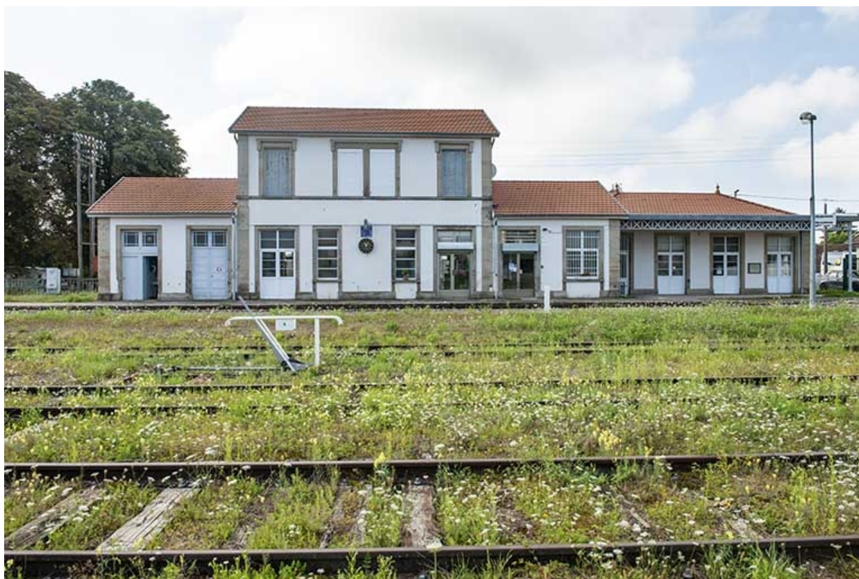
La gare, vue éloignée depuis les voies.
