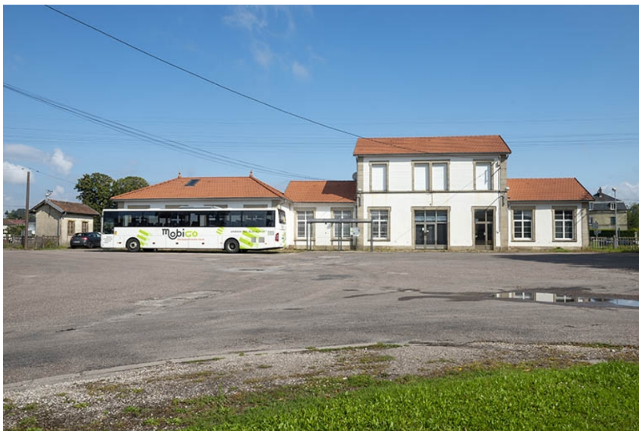
La gare, vue d'ensemble.
