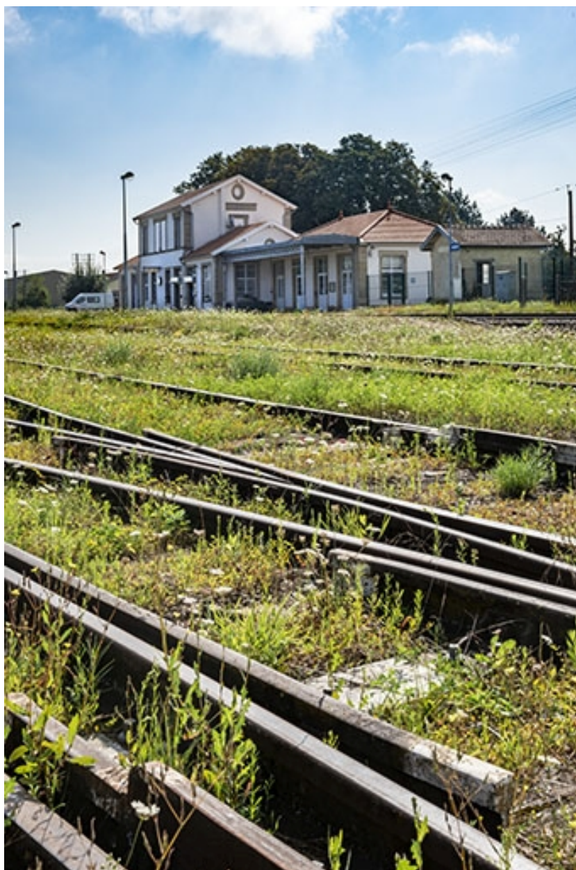
La gare, vue éloignée depuis les voies.
