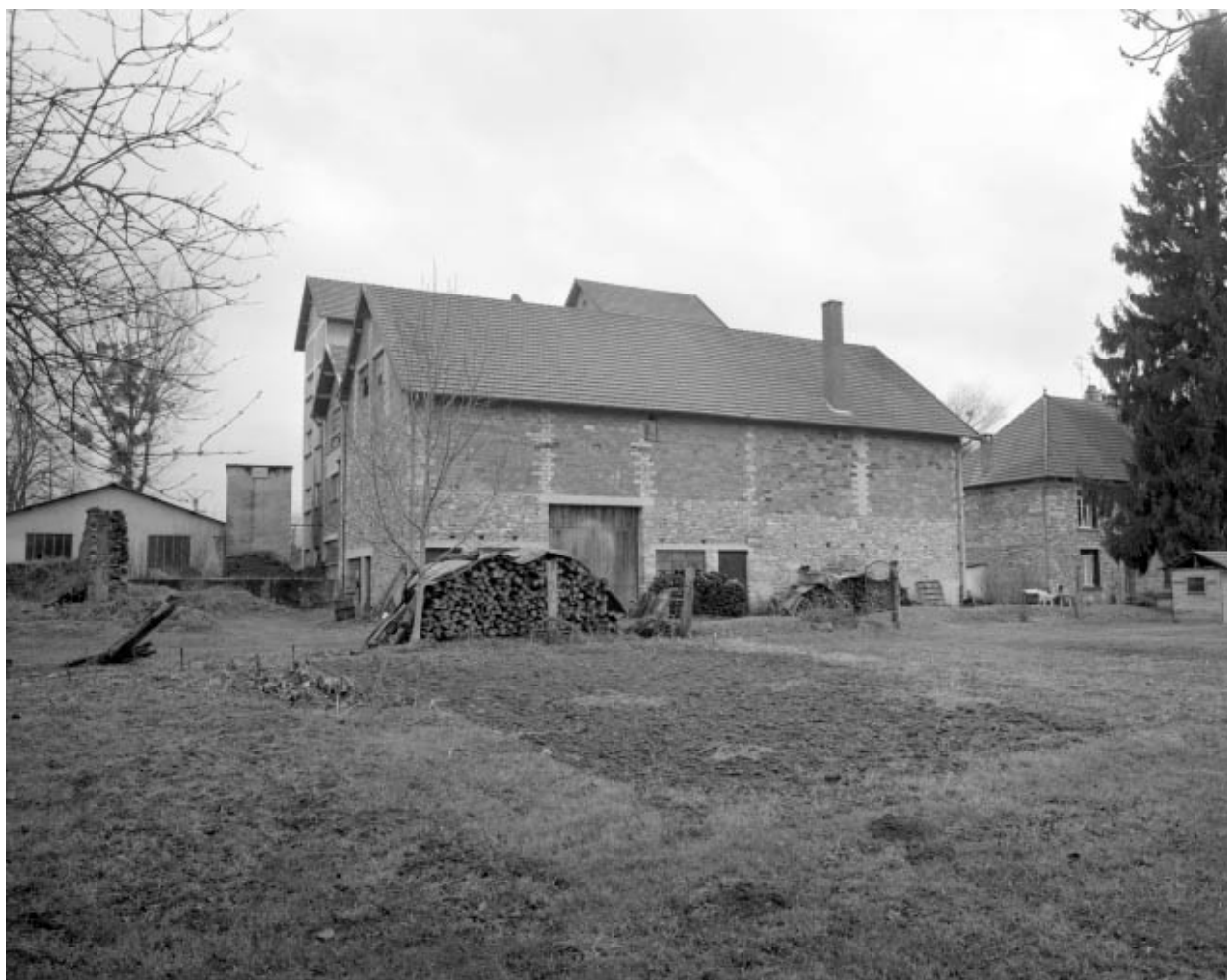
Façades postérieures de la minoterie.
