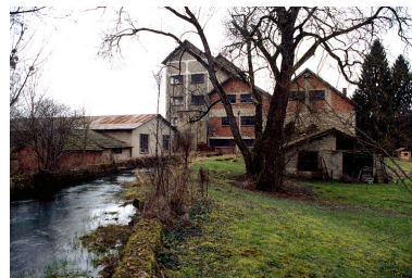
Façades postérieures depuis le canal d'amenée.
