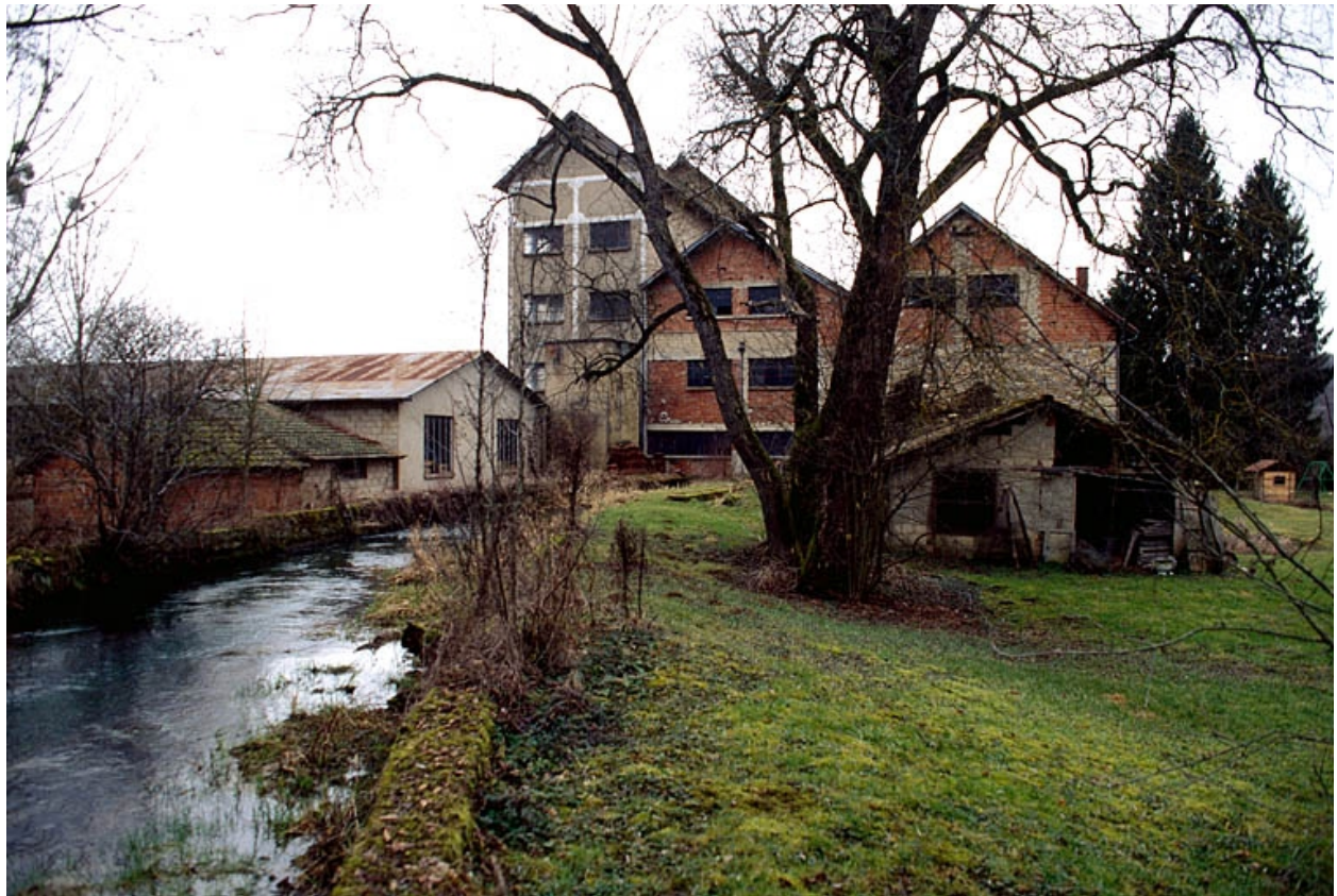
Façades postérieures depuis le canal d'aménée.
