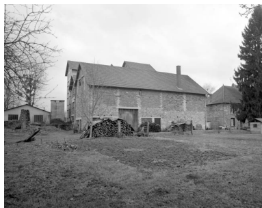
Façades postérieures de la minoterie.
