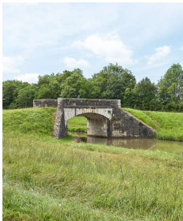
Vue du pont. Phot. Pierre-Marie Barbe-Richaud IVR26_20175800128NUC2A
