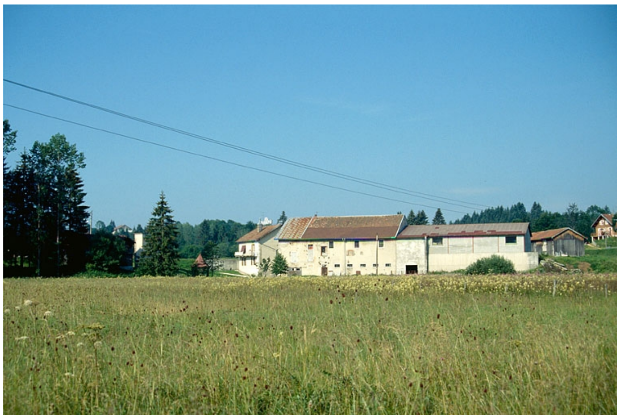
Ateliers de fabrication vus de l'est.
