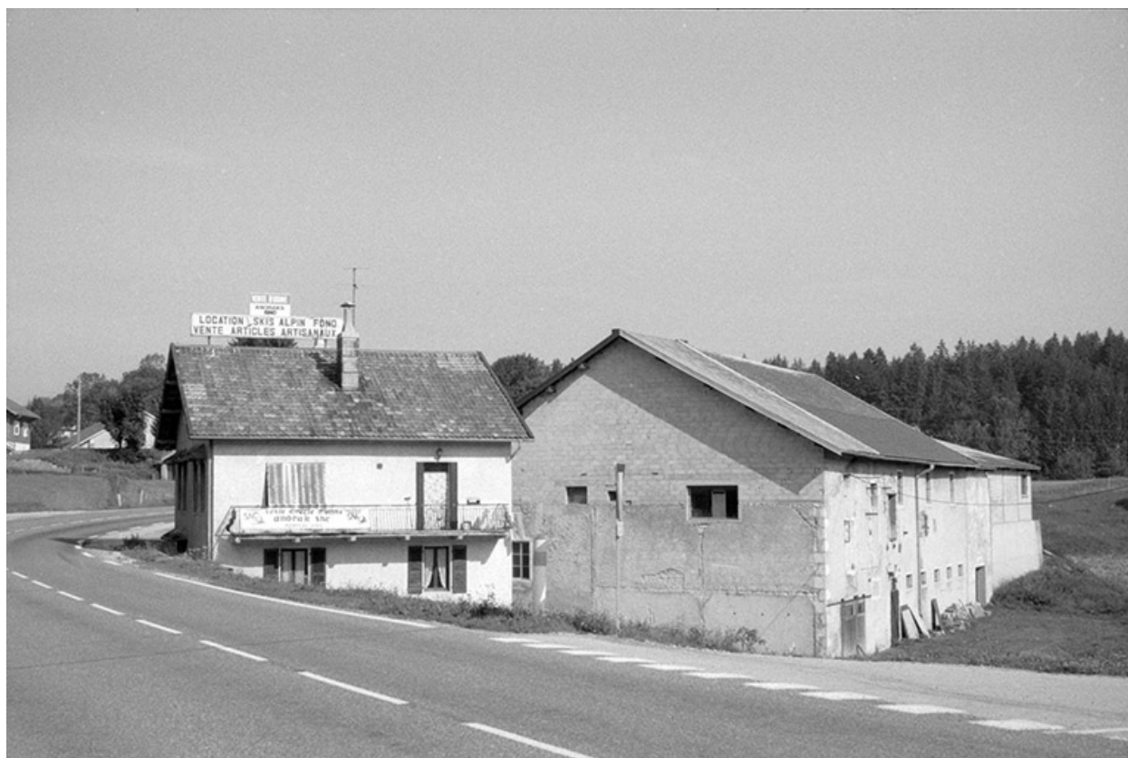
Logement patronal et ateliers de fabrication.
