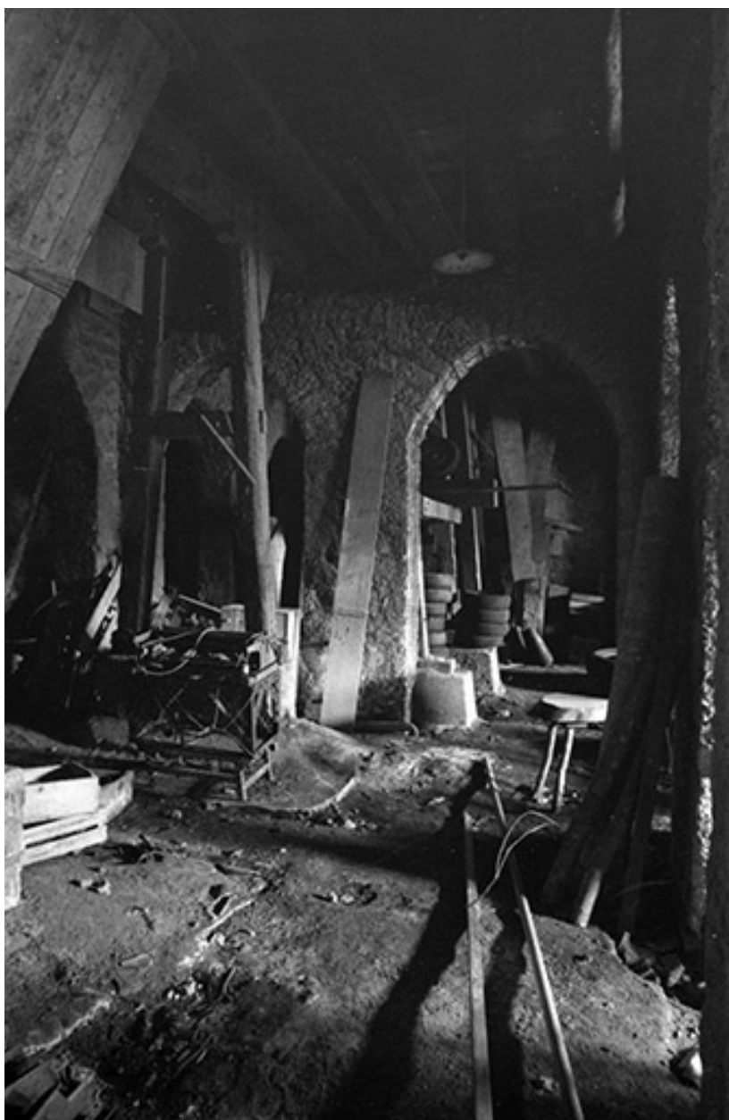
Etage de soubassement des ateliers de fabrication.
