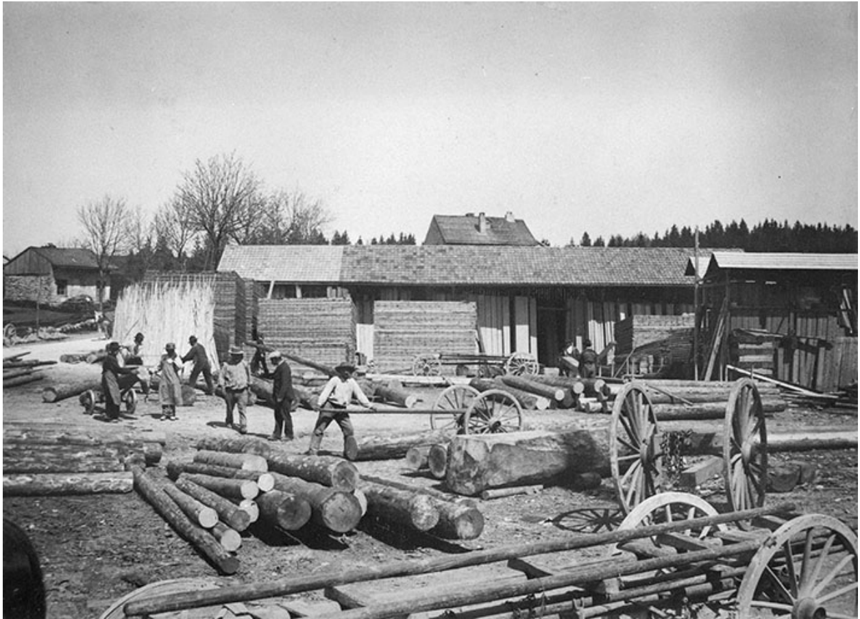
St Laurent. La scierie (chantier devant l'usine), 1898.
