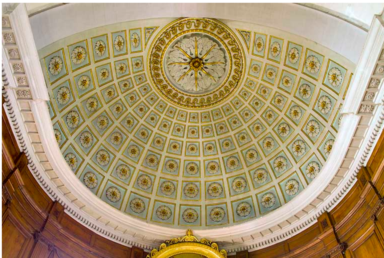
Voûte à caissons, chœur de l'église.
