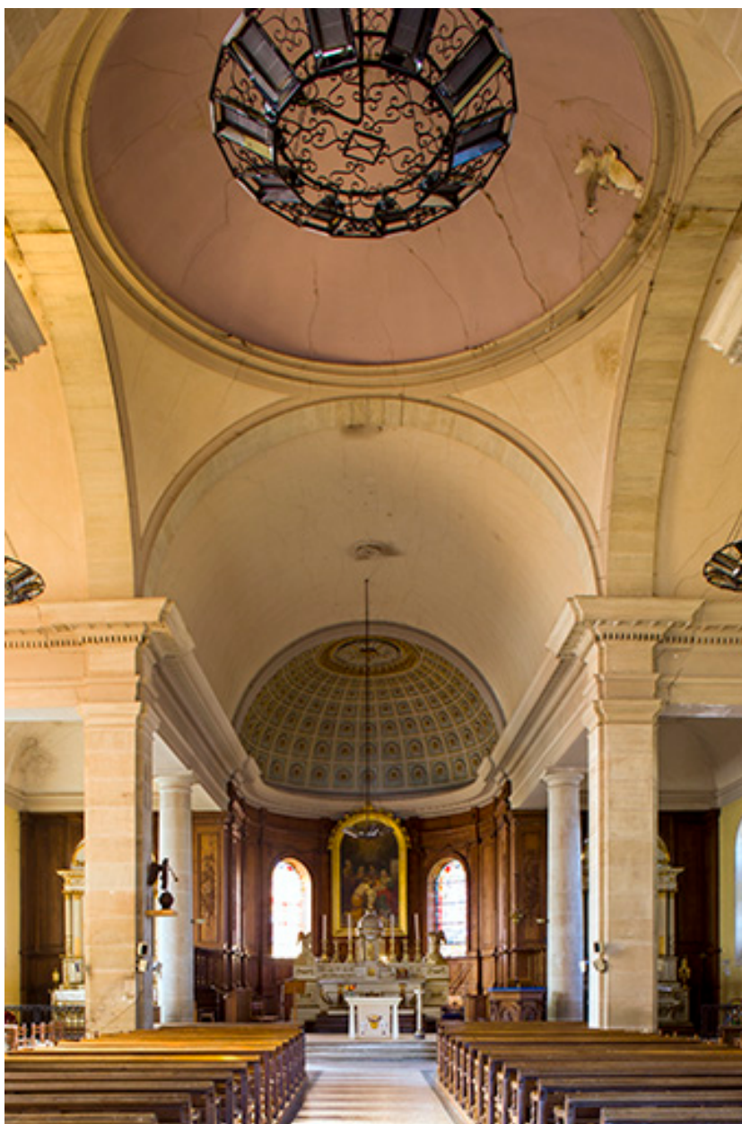
Vue générale de l'intérieur de l'édifice.
