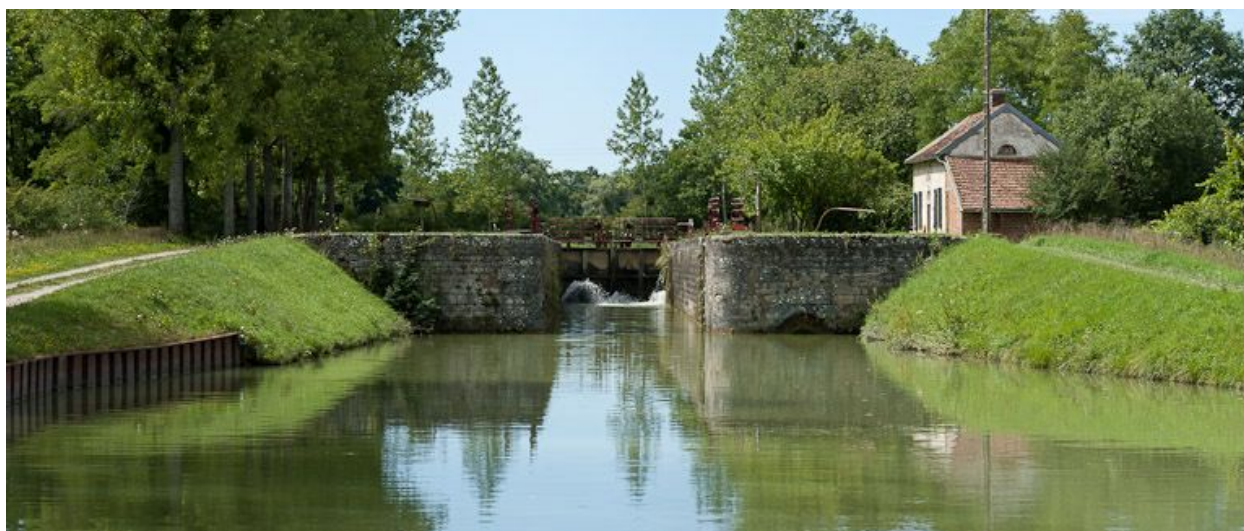
Vue du site d'écluse depuis l'aval.
