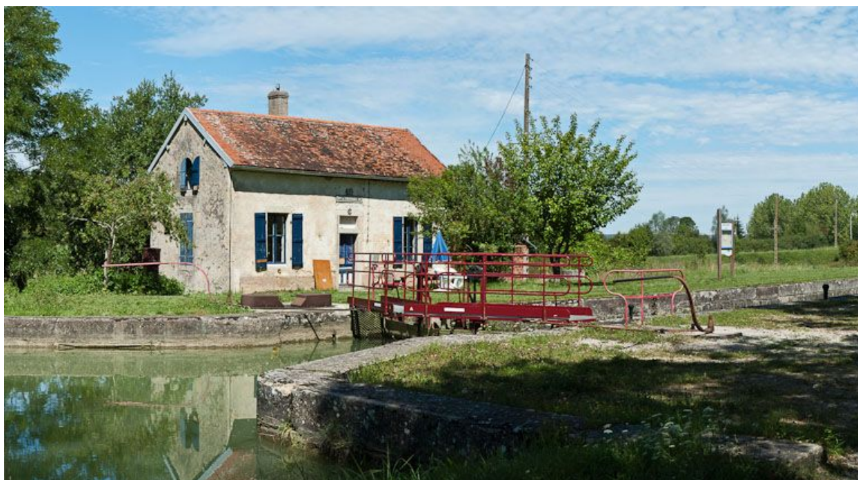
Vue d'ensemble du site d'écluse.
