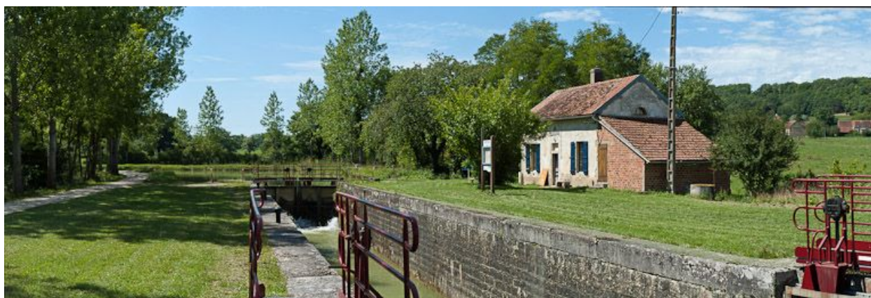
Vue d'ensemble du site d'écluse.
