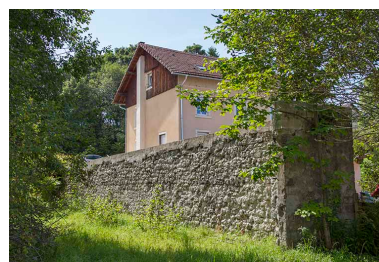
Vestige du mur de la scierie. Phot. Sonia Dourlot IVR43_20152500921NUC2A
