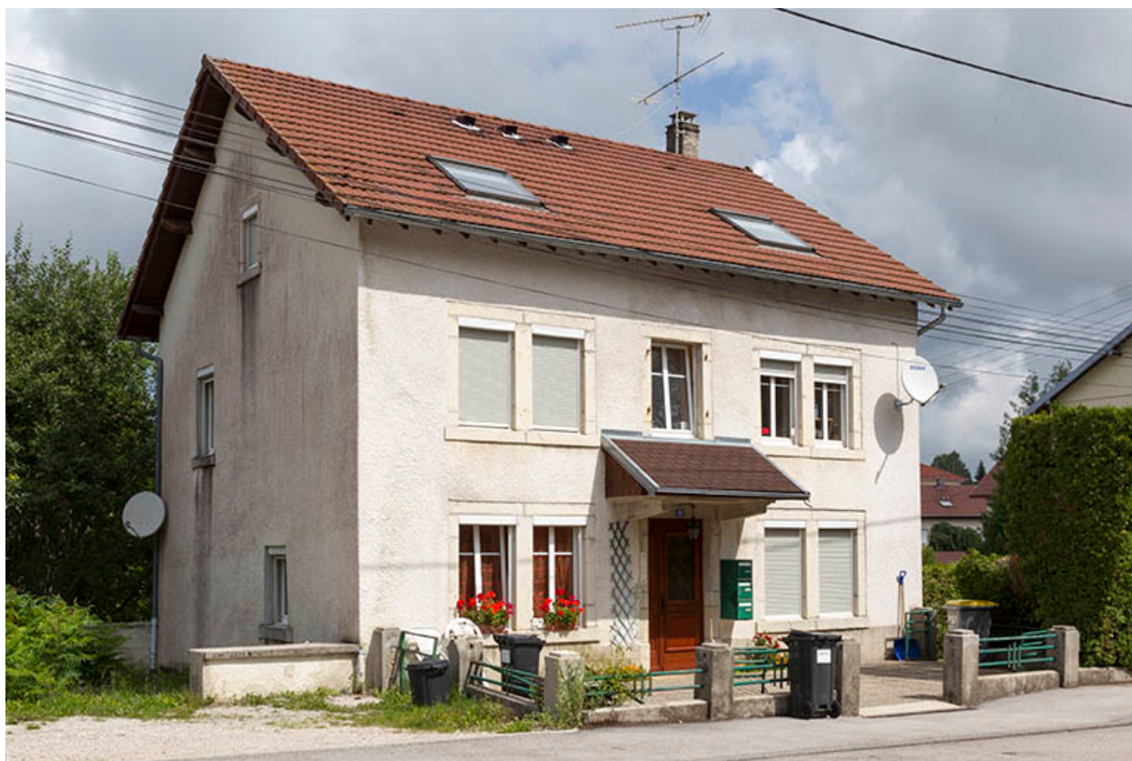
Logement patronal : façades antérieure et latérale gauche.
