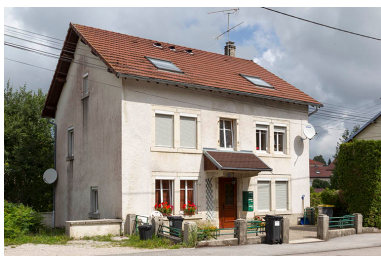
Logement patronal : façades antérieure et latérale gauche.
