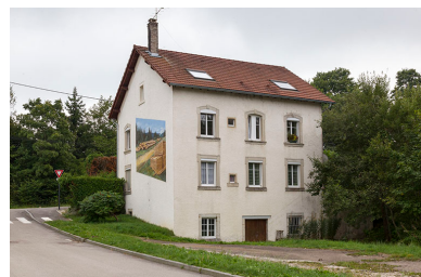
Logement patronal : façades postérieure et latérale droite.
