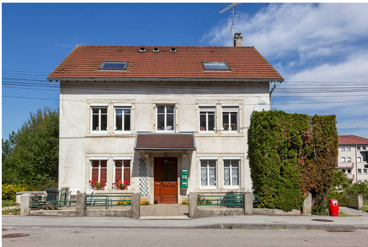
Logement patronal : façade antérieure.
