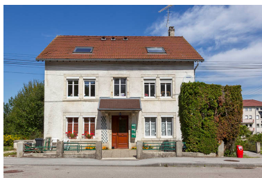
Logement patronal : façade antérieure.
