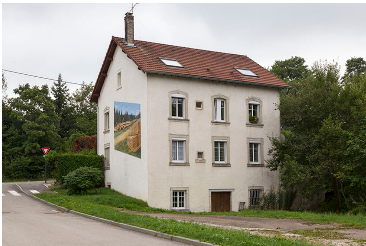
Logement patronal : façades postérieure et latérale droite.
