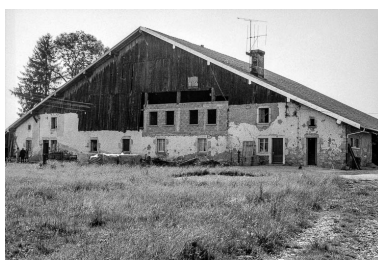
Ferme cadastrée 1938 E 266-267 : façade antérieure. Phot. Gilbert Poinot IVR43_19752500779Z
