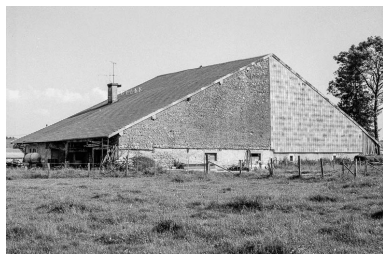
Ferme cadastrée 1938 E 266-267 : façade postérieure. Phot. Gilbert Poinot IVR43_19752500780Z
