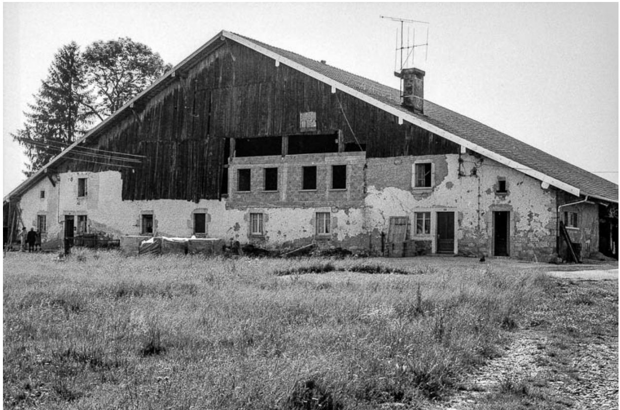
Ferme cadastrée 1938 E 266-267 : façade antérieure.
