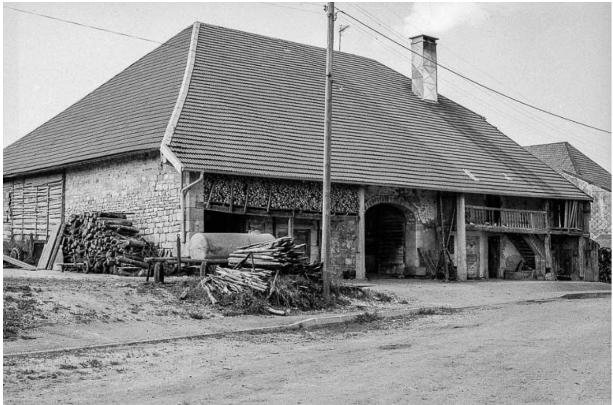
Ferme, cadastrée 1938 F 62 : façade antérieure.
