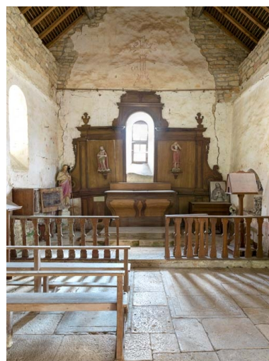
Le chœur. Phot. Pierre-Marie Barbe-Richaud IVR26_20182100071NUC4A
