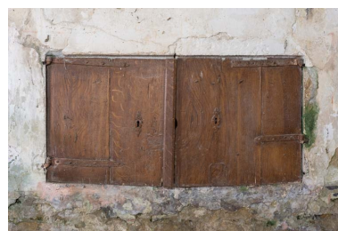
Double niche dans le chœur. Phot. Pierre-Marie Barbe-Richaud IVR26_20182100081NUC4A
