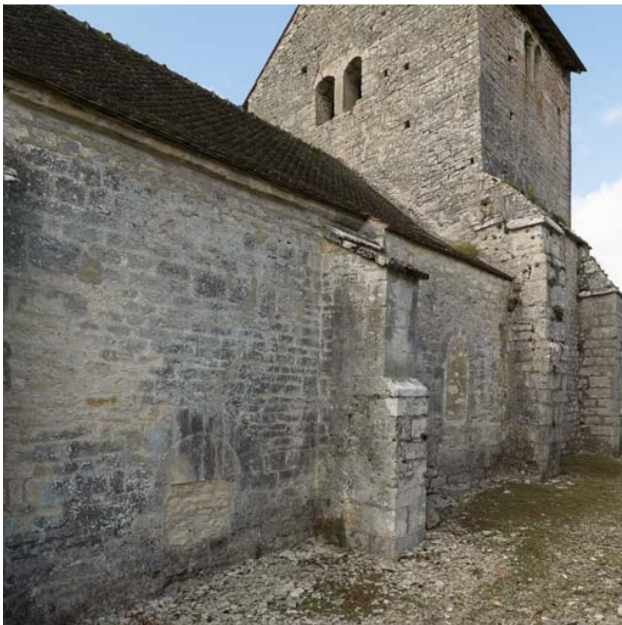
Détail des baies bouchées de l'élévation nord.
