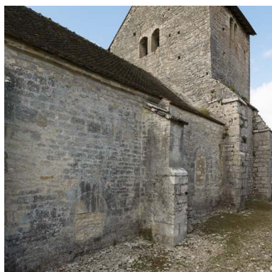
Détail des baies bouchées de l'élévation nord. Phot. Pierre-Marie Barbe-Richaud IVR26_20182100115NUC2A
