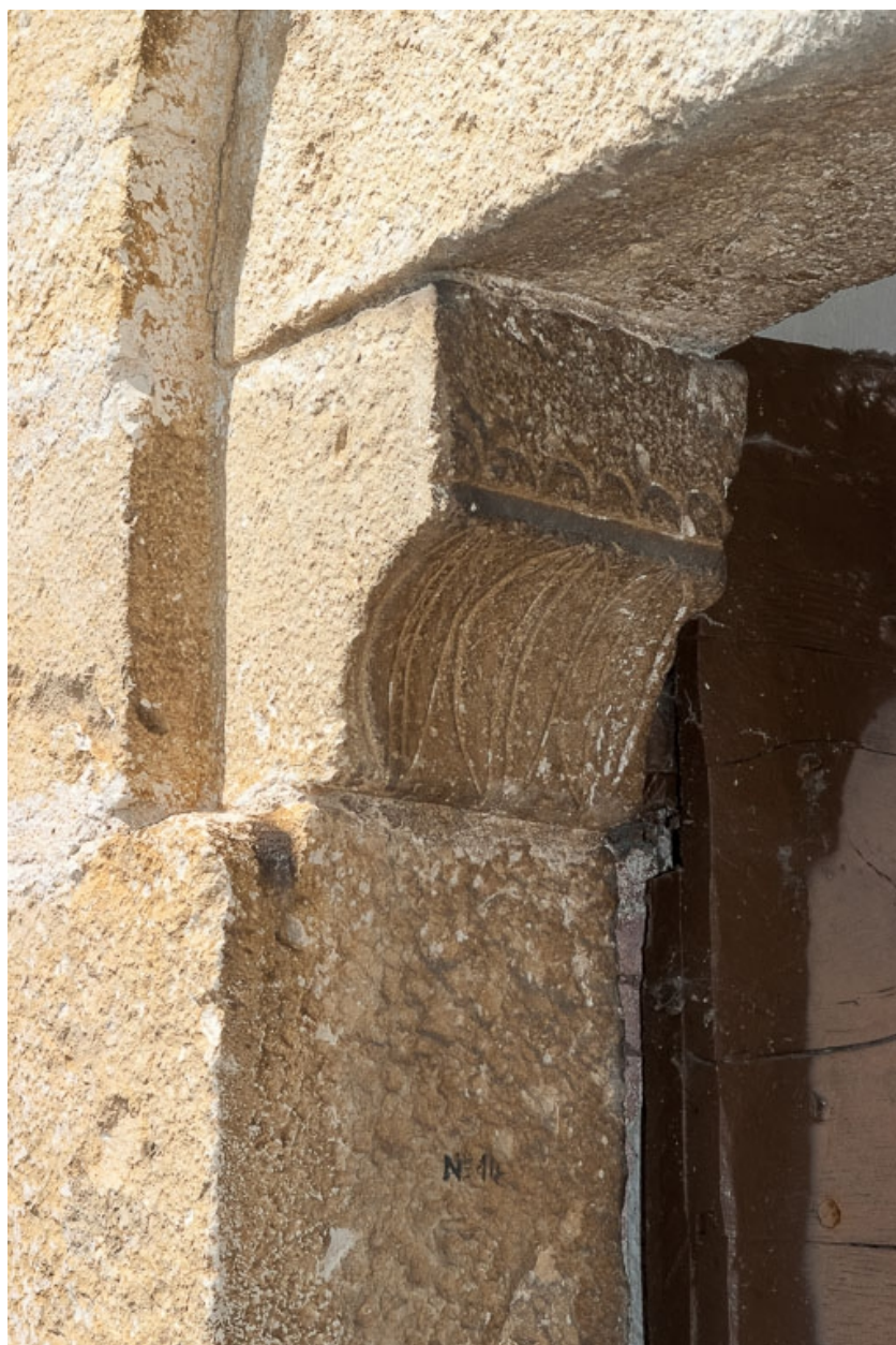
Porte latérale, détail d'un coussinet.
