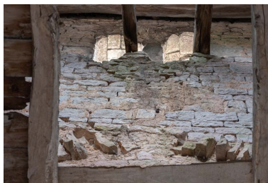
Baies géminées du clocher-porche. Phot. Pierre-Marie Barbe-Richaud IVR26_20182100097NUC4A
