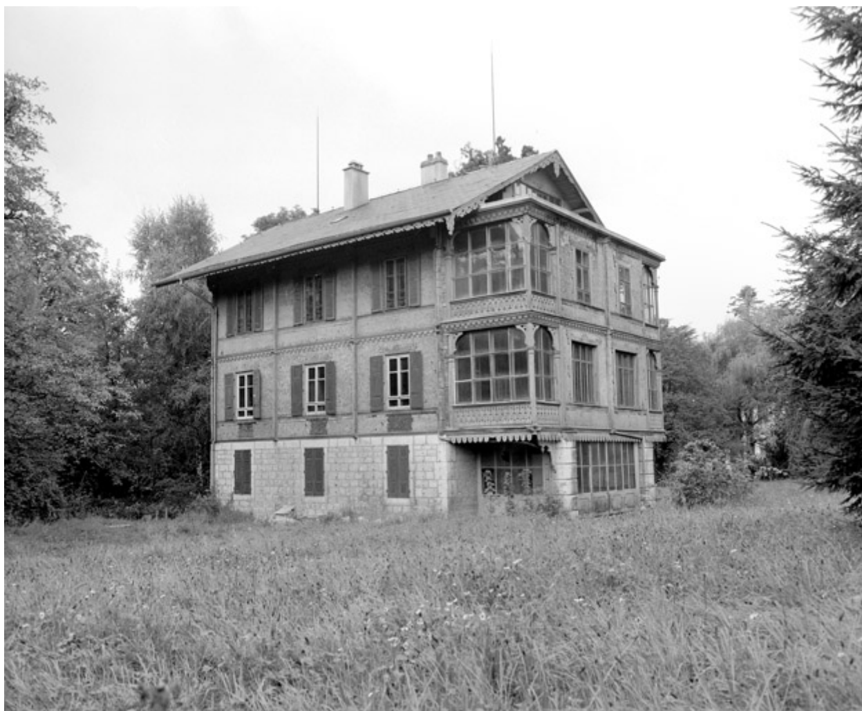
Chalet. Vue de trois quarts en 1981.SRI. Enquête régionale sur les bâtiments industriels (1979-1981).
