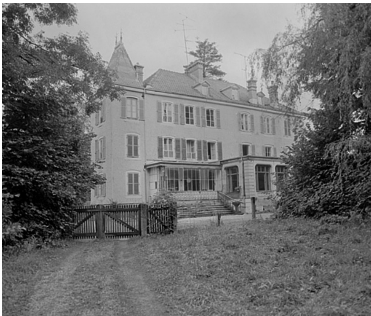
Façade sud en 1981.SRI. Enquête régionale sur les bâtiments industriels (1979-1981).
