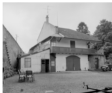
Logement et écurie en 1981.SRI. Enquête régionale sur les bâtiments industriels (1979-1981). Phot. Yves Sancey IVR43_19819000013X
