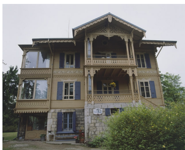
Chalet. Façade nord. Phot. Yves Sancey IVR43_20029000298XA
