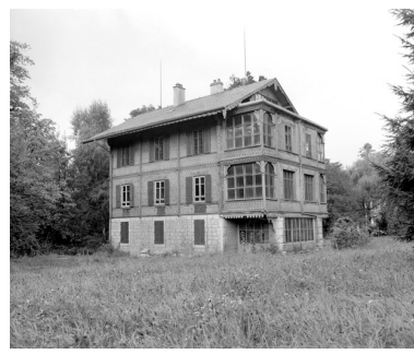
Chalet. Vue de trois quarts en 1981.SRI. Enquête régionale sur les bâtiments industriels (1979-1981). Phot. Yves Sancey IVR43_19819000015X
