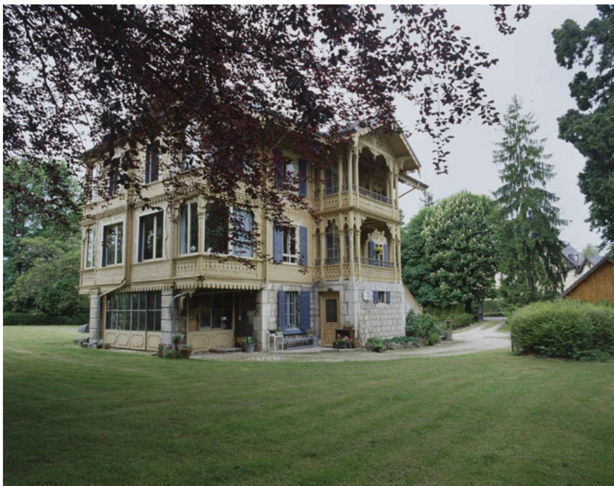
Chalet. Vue d'ensemble depuis le nord-est.
