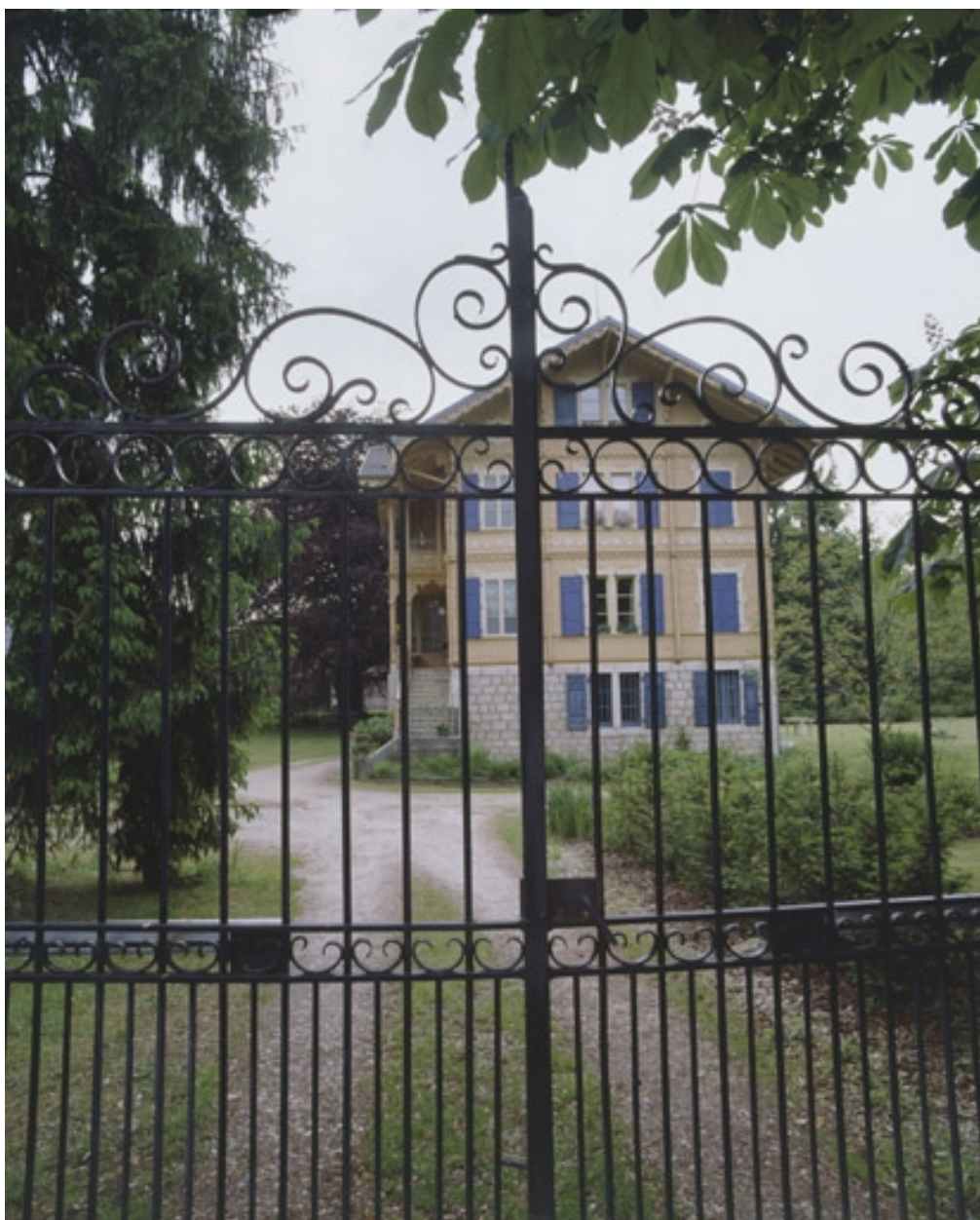
Chalet. Vue depuis la grille d'entrée.
