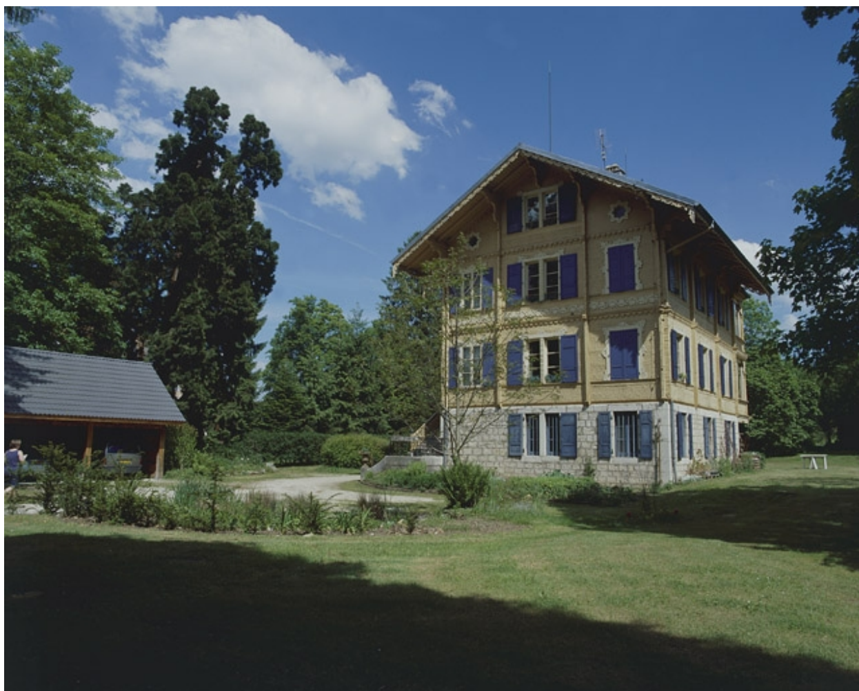
Chalet. Vue d'ensemble depuis le sud-ouest.
