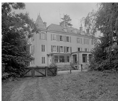
Façade sud en 1981.SRI. Enquête régionale sur les bâtiments industriels (1979-1981). Phot. Yves Sancey IVR43_19819000012X
