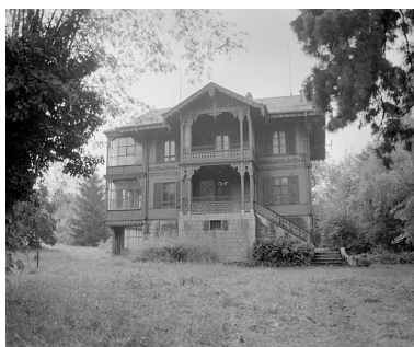
Chalet. Façade nord en 1981.SRI. Enquête régionale sur les bâtiments industriels (1979-1981). Phot. Yves Sancey IVR43_19819000017X
