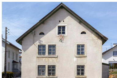
Façade latérale droite. Phot. Sonia Dourlot IVR43_20152500885NUC2A
