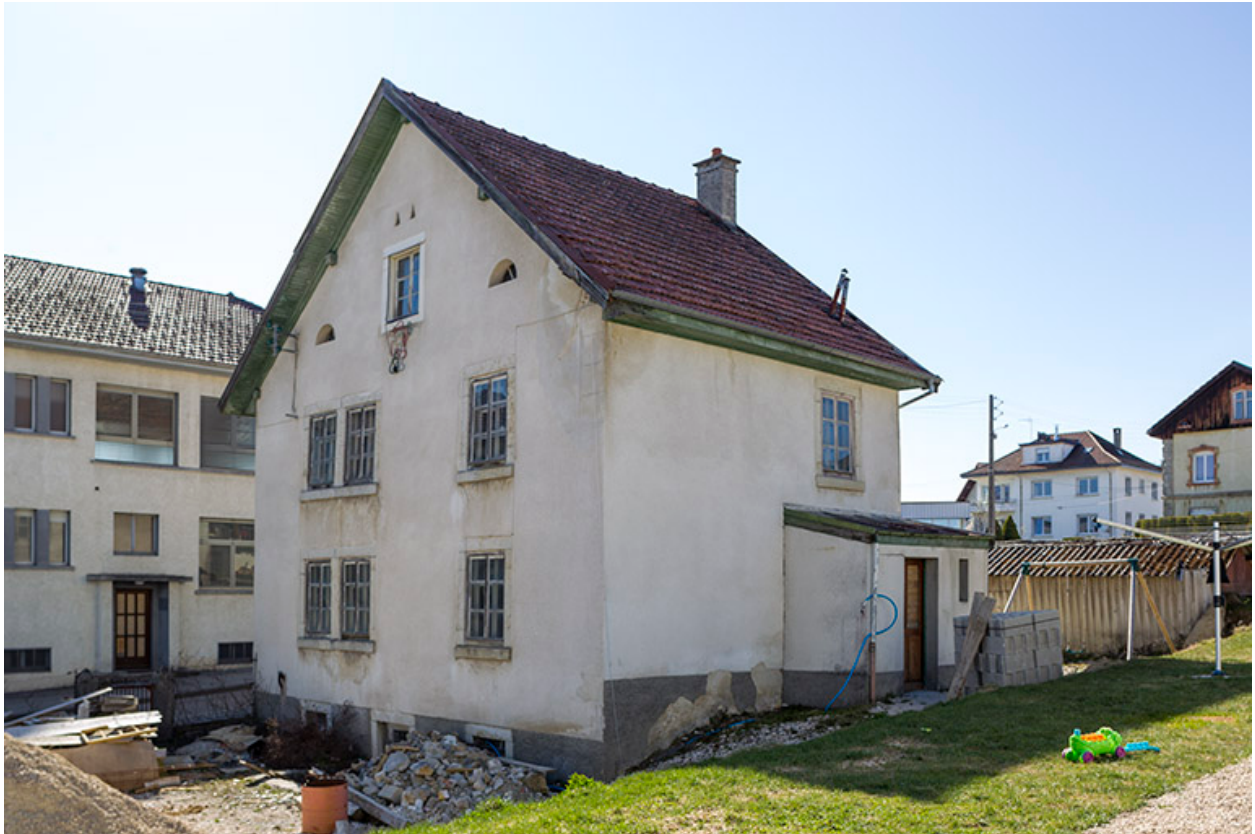
Façades postérieure et latérale droite.
