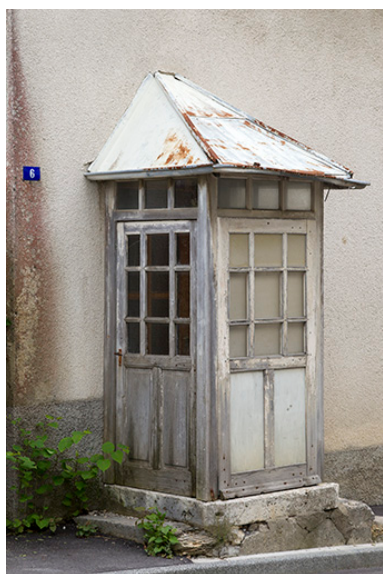
Façade antérieure : véranda. Phot. Yves Sancey IVR43_20132503026NUC2A
