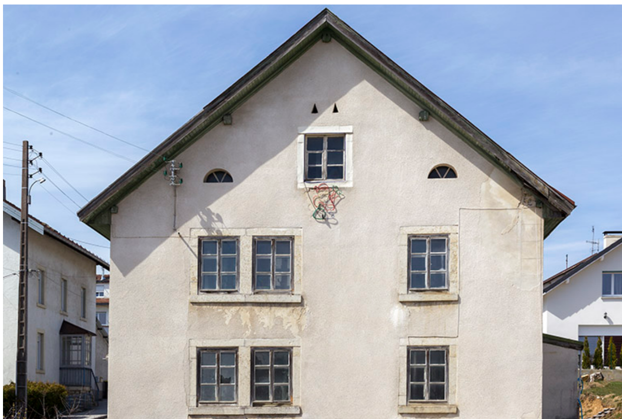
Façade latérale droite.
