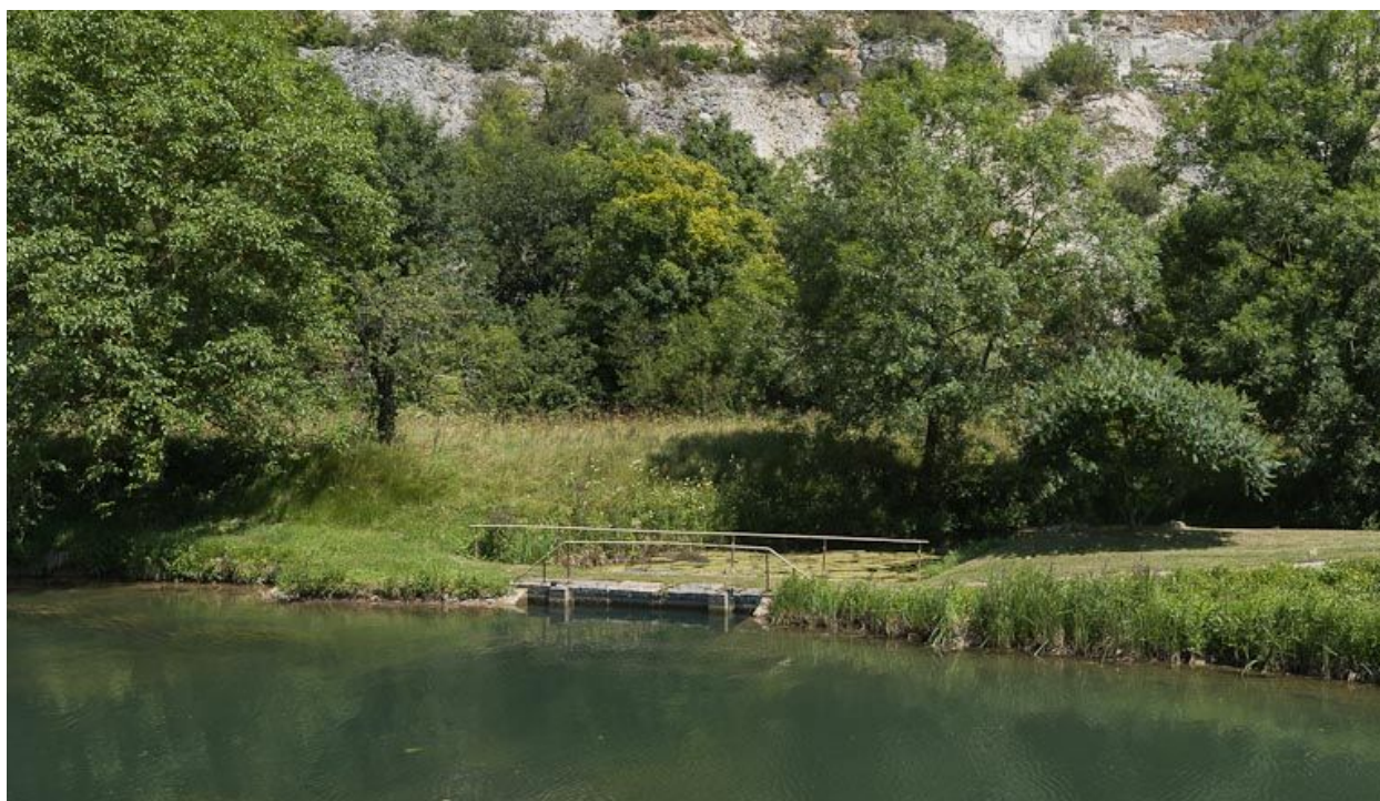
Arrivée de la rigole dans le canal.
