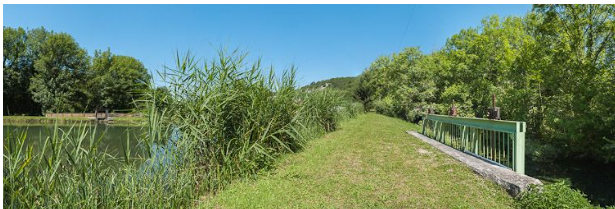
Vannes de l'aqueduc.
