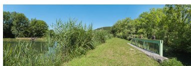
Vannes de l'aqueduc.
