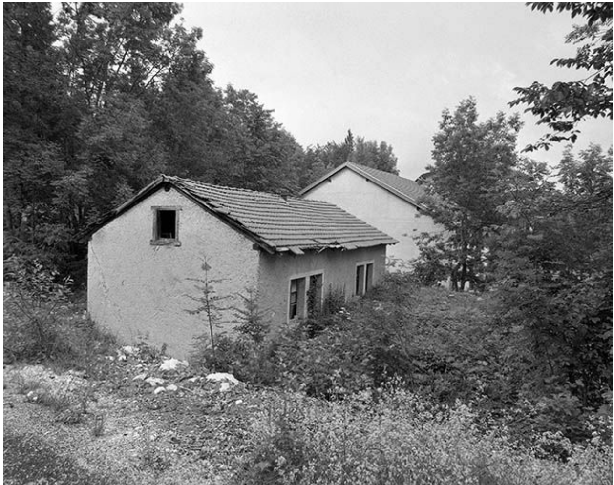
Remise abritant une forge.
