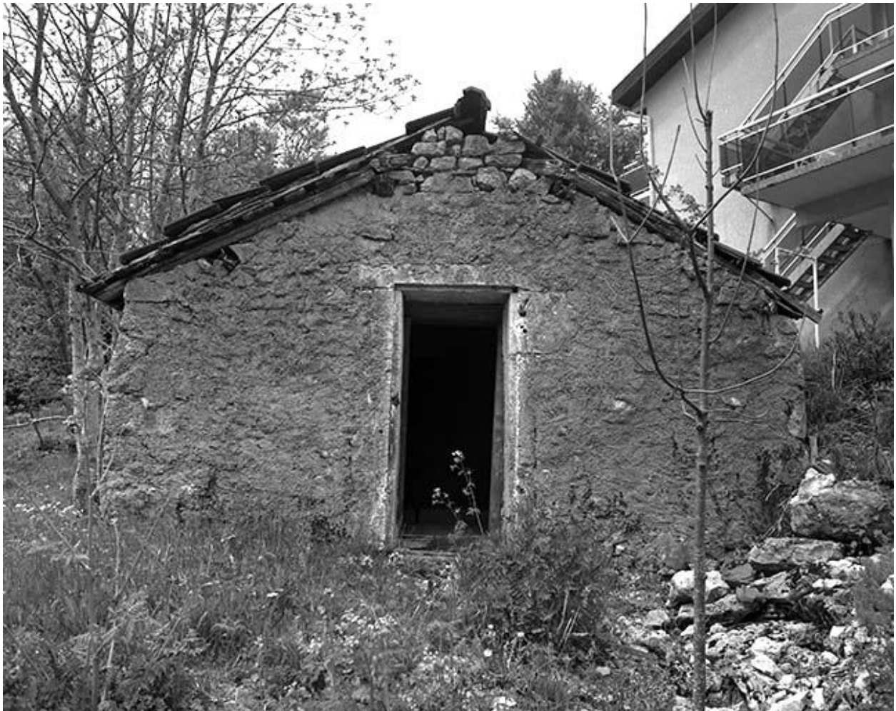
Façade antérieure de la resserre, " grenier fort ".
