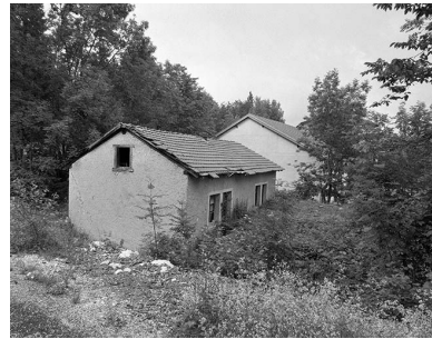
Remise abritant une forge.
