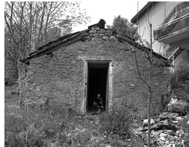
Façade antérieure de la resserre, " grenier fort ".
