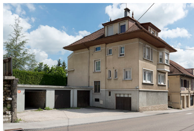
Façades antérieure et latérale gauche.
