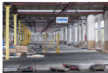
Travée d'un atelier de fabrication.
