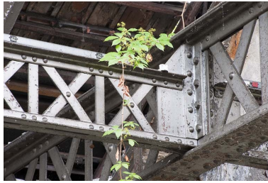
Détail de poutrelles à treillis. Phot. Jérôme Mongreville IVR43_20112501532NUC4A
