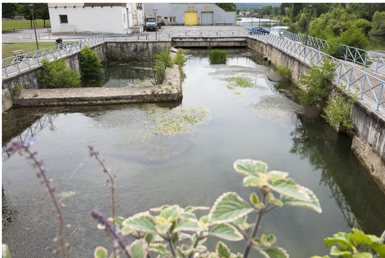
Bassin aménagé à l'emplacement du canal d'amenée.
