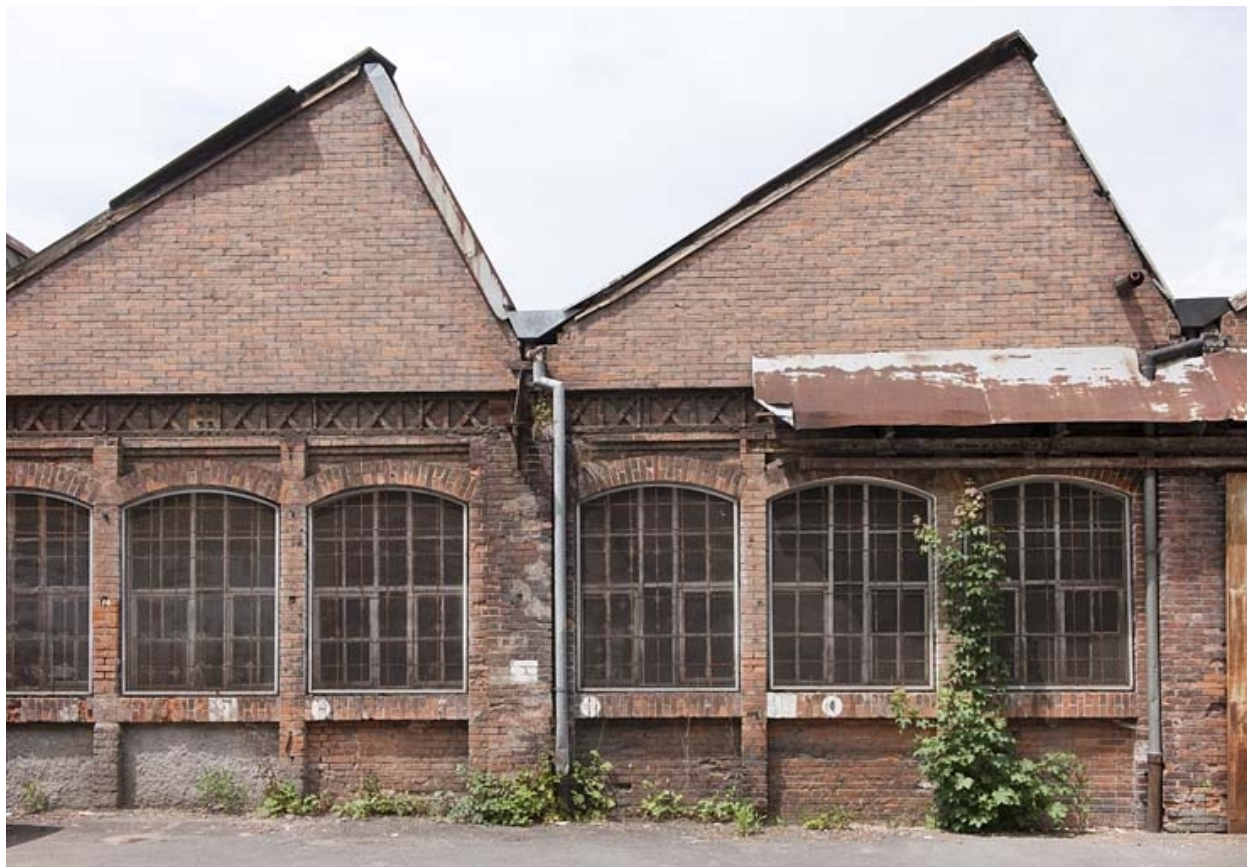
Atelier de fabrication. Pignons de sheds.
