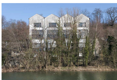
Façade ouest de l'atelier des presses. Phot. Jérôme Mongreville IVR43_20122500115NUC4A
