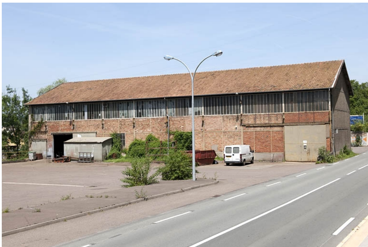
Magasin industriel. Vue depuis l'ouest.
