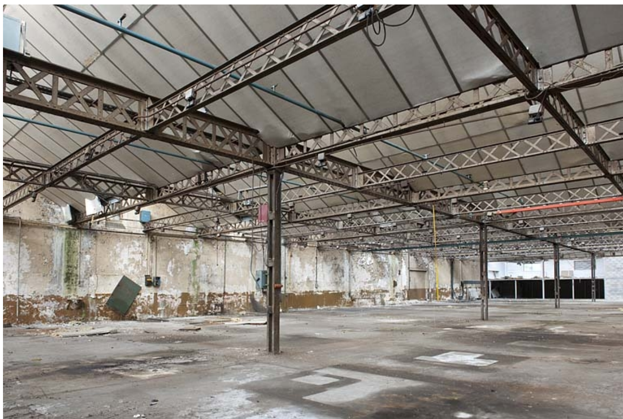
Atelier de fabrication. Vue depuis le nord-ouest.
