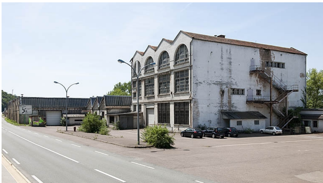
Ateliers de fabrication depuis la route nationale.
