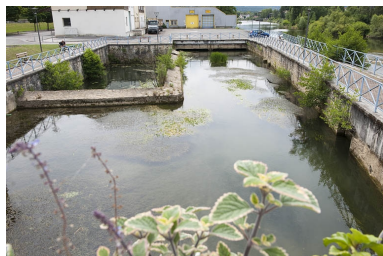
Bassin aménagé à l'emplacement du canal d'amenée.
