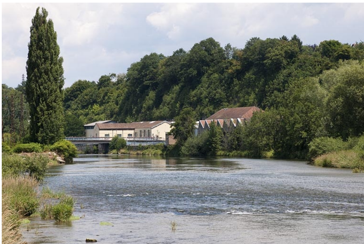
Vue depuis l'amont de la rive gauche.
