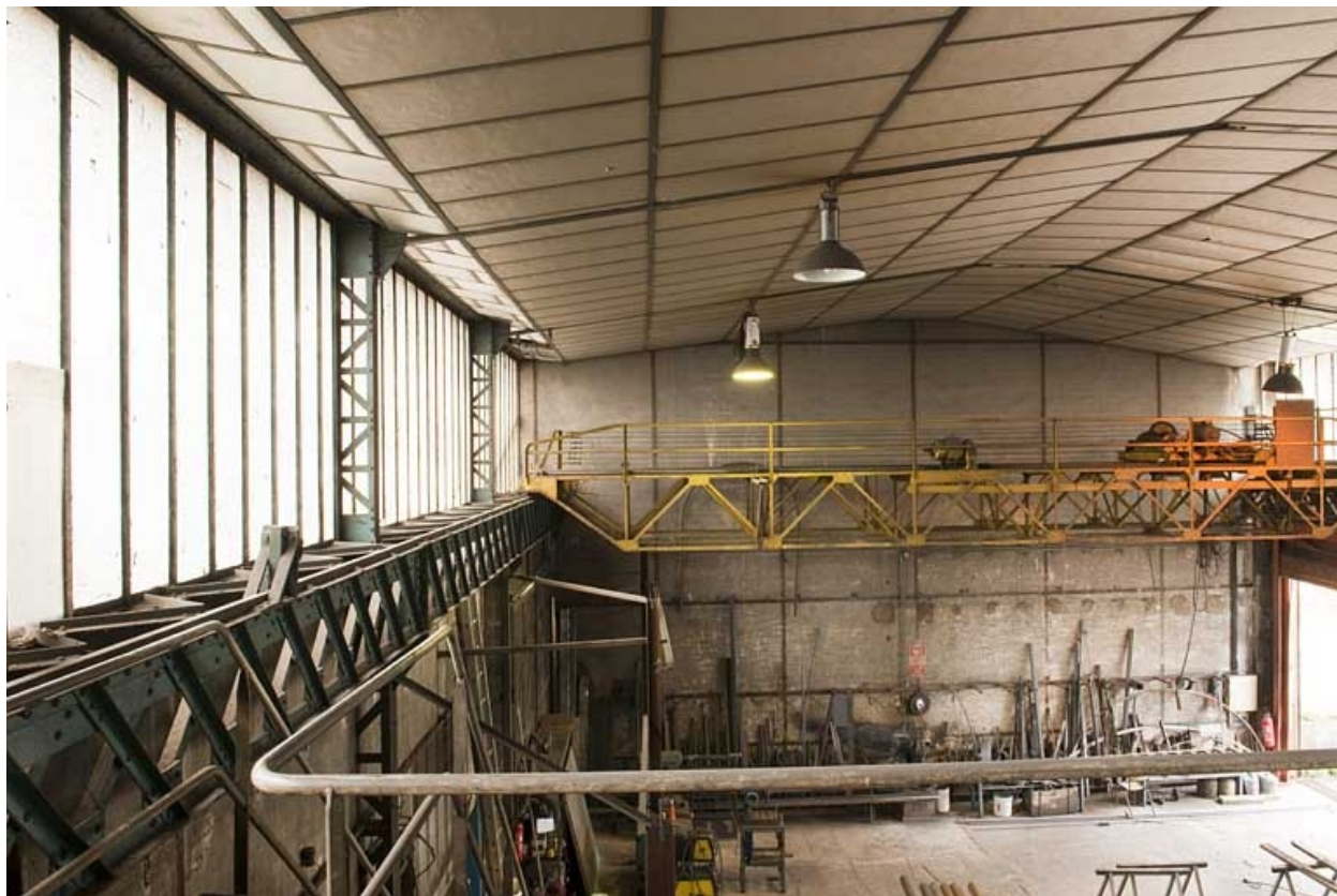
Magasin industriel. Vue plongeante depuis l'ouest.
