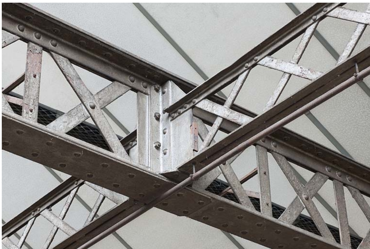
Intersection de poutrelles à treillis.
