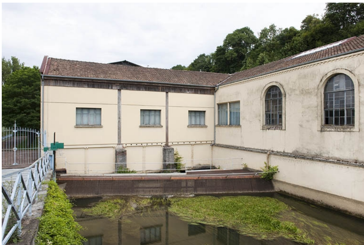
Bâtiment d'eau vu depuis l'amont.
