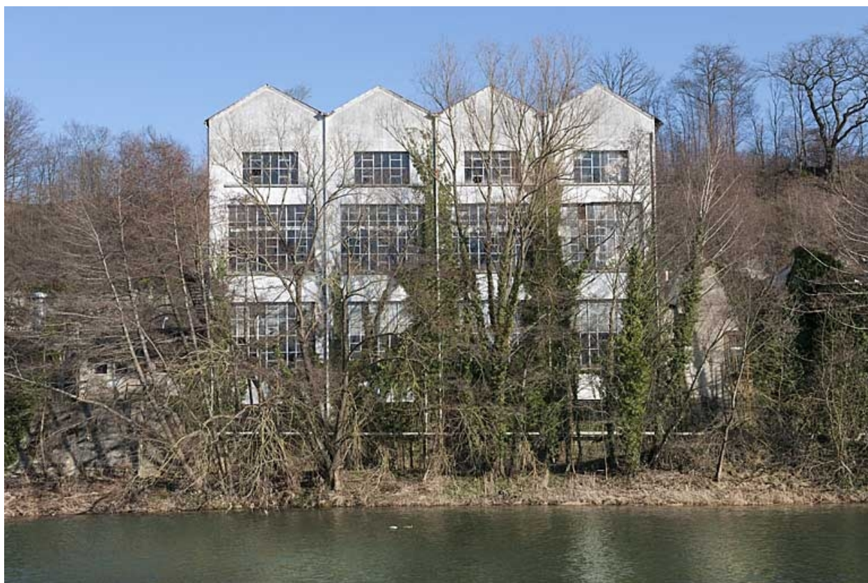
Façade ouest de l'atelier des presses.
