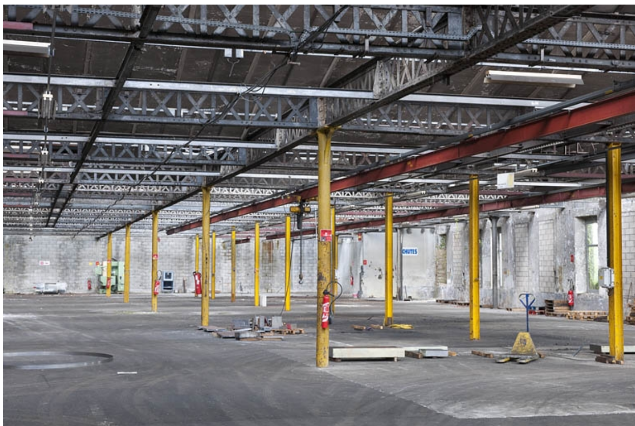
Atelier de fabrication. Vue de trois quarts.
