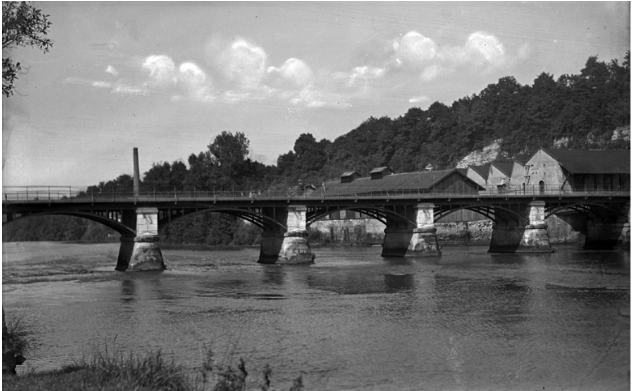
Vue en aval du pont. Phot., s.d. [début du 20e siècle].
