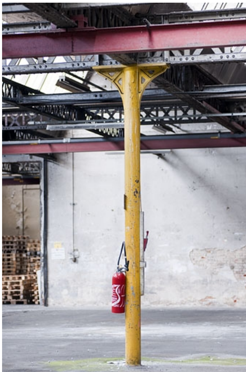
Colonne en fonte et charpente métallique.
