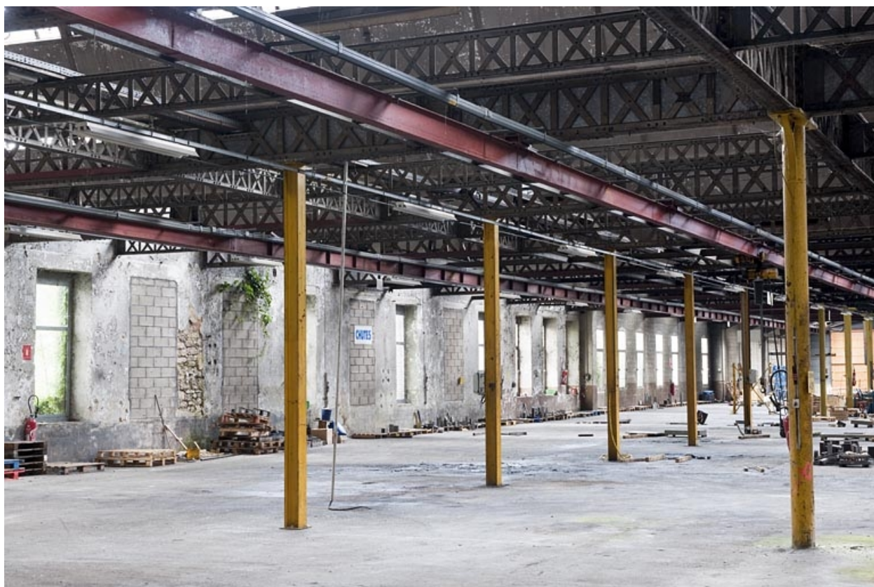
Atelier de fabrication. Vue de trois quarts.
