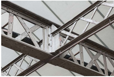
Intersection de poutrelles à treillis. Phot. Jérôme Mongreville IVR43_20112501525NUC4A
