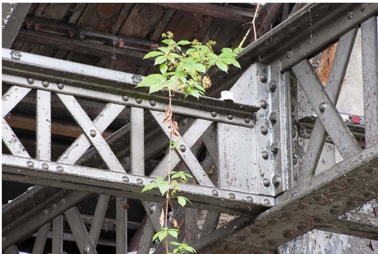
Détail de poutrelles à treillis.
