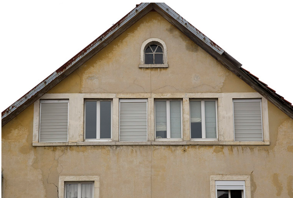
Façade postérieure en 2012 (avant rénovation) : fenêtres multiples.
