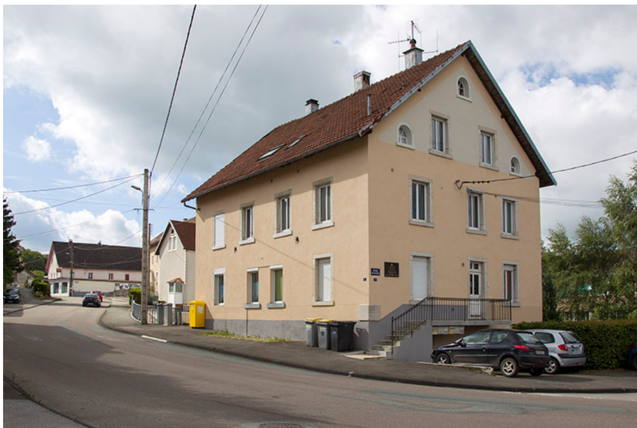
Façades antérieure et latérale gauche.
