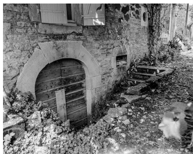
Bâtiment d'habitation : l'entrée de cave sur la façade postérieure. Phot. Dominique Dominguez IVR43_19773900065X
