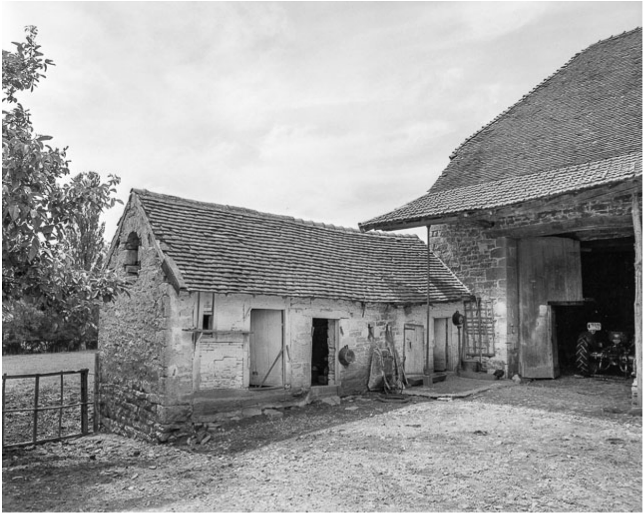
Petit bâtiment au fond de la cour.
