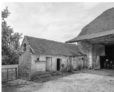
Petit bâtiment au fond de la cour. Phot. Dominique Dominguez IVR43_19773900068X
