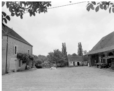
Vue de la cour et des bâtiments. Phot. Dominique Dominguez IVR43_19773900062X
