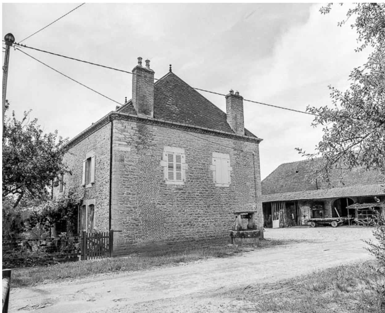
Le bâtiment d'habitation : façade postérieure de trois quarts et pignon droit.
