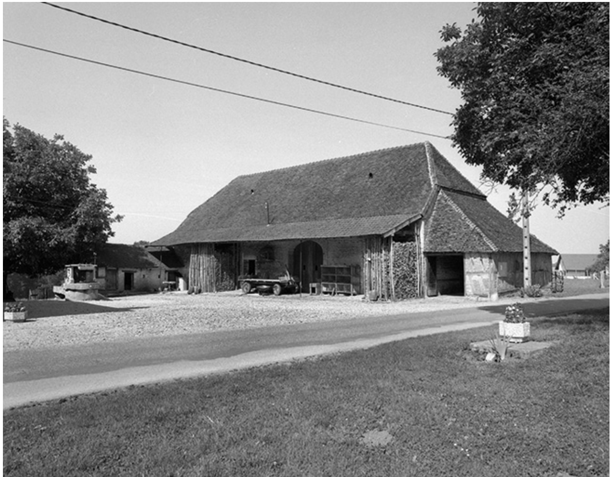
Le bâtiment d'exploitation en 1990.
