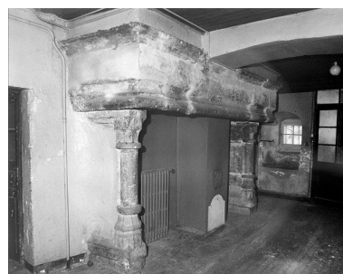
Vue intérieure, cheminée. Phot. Yves Sancey IVR43_20003900403X
