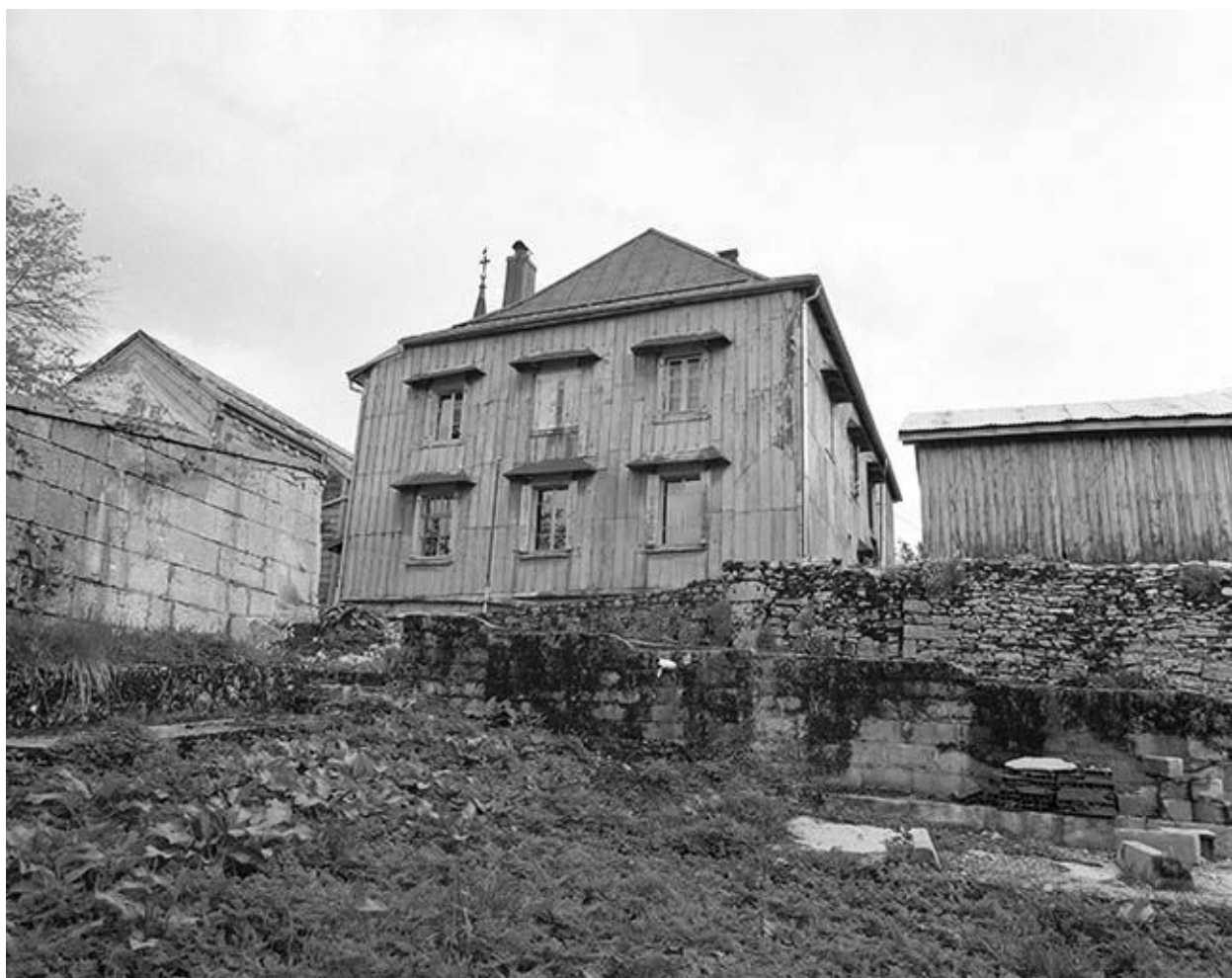
Vue éloignée de la façade ouest.
