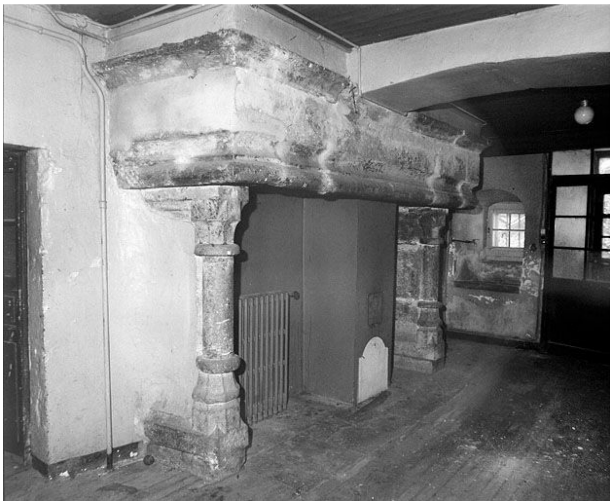
Vue intérieure, cheminée.
