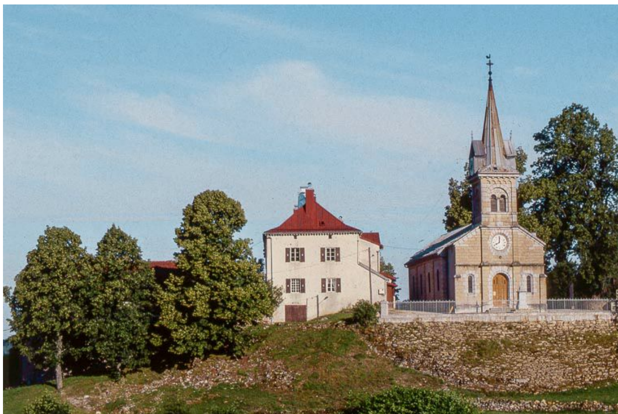
Vue éloignée du presbytère et de l'église.
