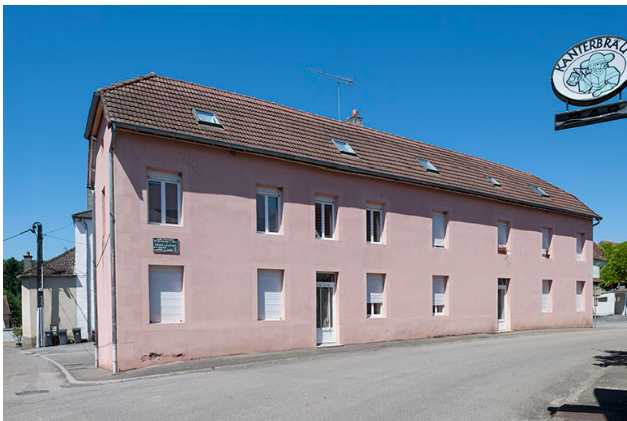
Vue générale de l'édifice.
