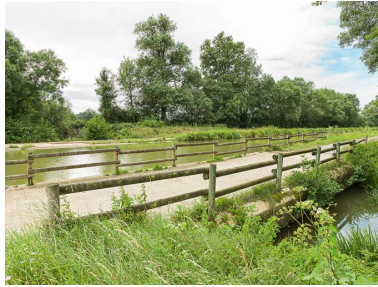
Vue du déversoir.
