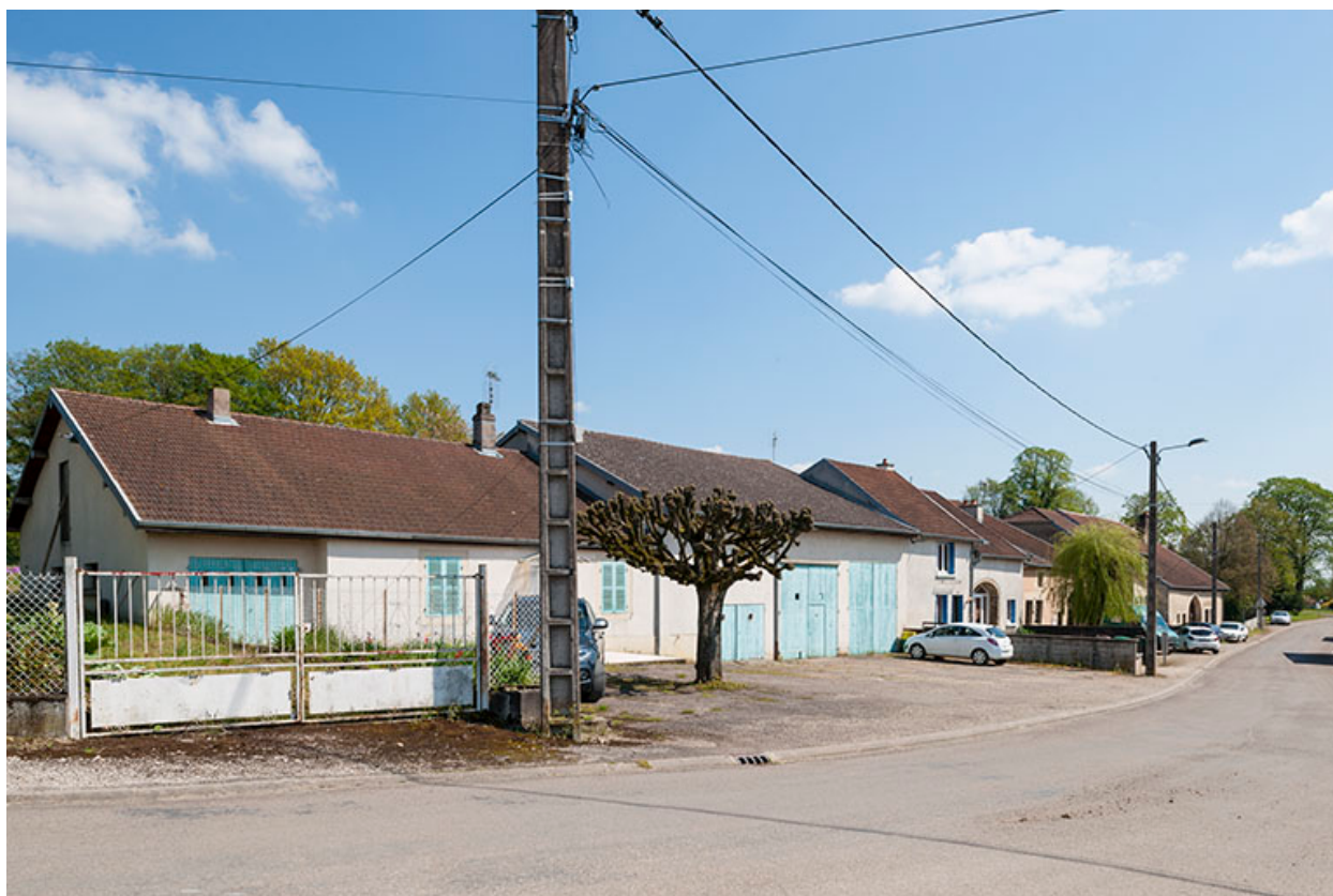
Maisons construites, rue du Patis.
