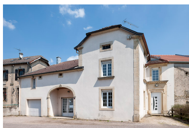
Ferme, Grande rue. Phot. Jérôme Mongreville IVR43_20167000375NUC4A
