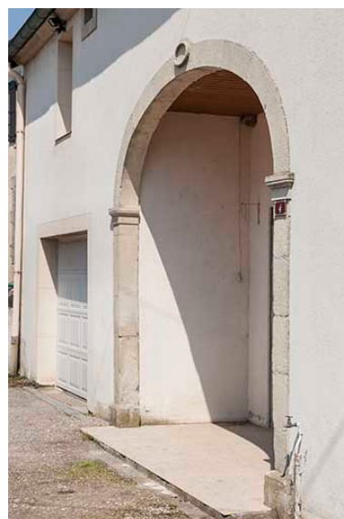
La porte charretière. Phot. Jérôme Mongreville IVR43_20167000381NUC4A
