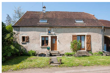
Ferme située Grande rue. Phot. Jérôme Mongreville IVR43_20167000353NUC4A
