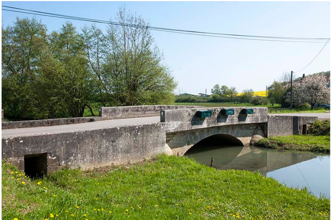
Le pont permettant de franchir le ruisseau.
