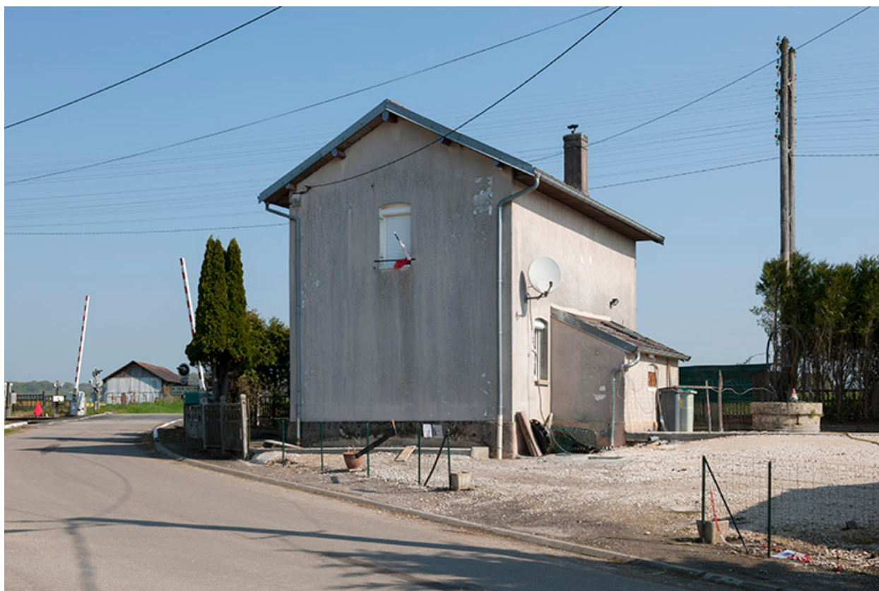
Maison garde-barrière de la commune.
