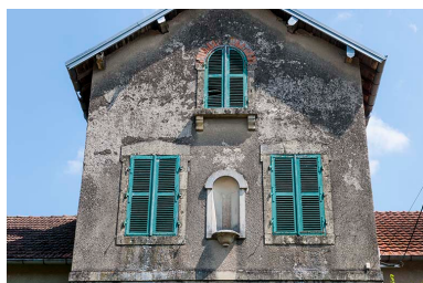
Détail sur la niche, façade principale. Phot. Jérôme Mongreville IVR43_20167000363NUC4A
