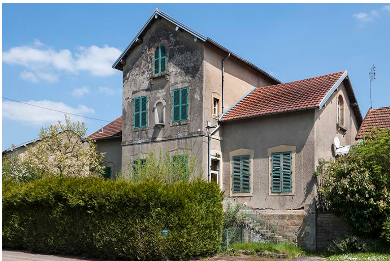
Ancienne maison des soeurs.
