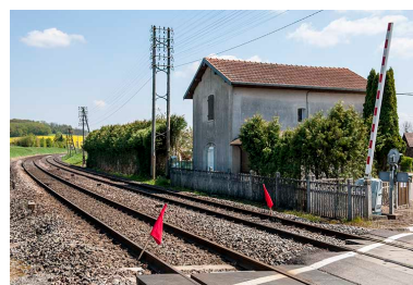
La voie ferrée longeant le village. Phot. Jérôme Mongreville IVR43_20167000387NUC4A
