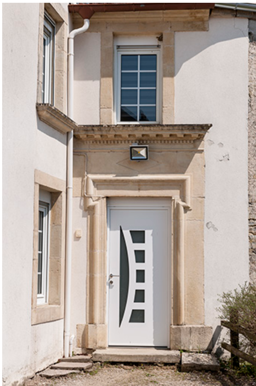
Détail du décor de l'entrée, partie habitation.
