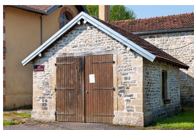
Local de la rémise à pompe de la commune. Phot. Jérôme Mongreville IVR43_20167000341NUC4A
