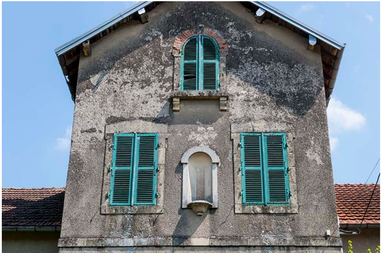
Détail sur la niche, façade principale.
