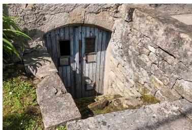
Entrée de cave. Phot. Jérôme Mongreville IVR43_20167000354NUC4A
