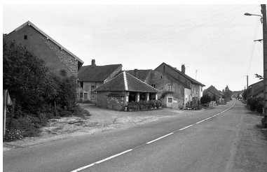
Vue d'ensemble depuis la route. Phot. Jean- Marie NEPASUTILISERBaverel
