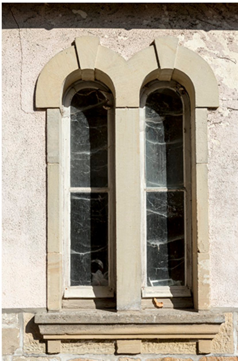
Détail des baies jumelées de l'ancienne dépendance.
