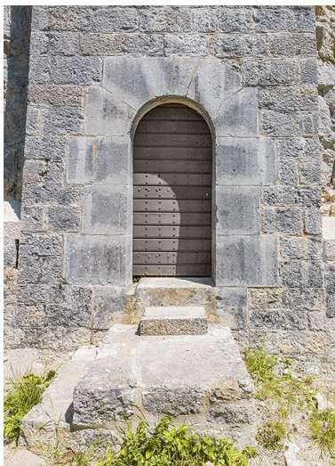
Front ouest : poterne. Phot. Thierry Kuntz IVR43_20253900406NUC4A
