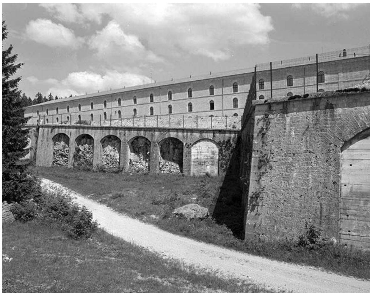
Enceinte du fort, système bastionné (en 2000).
