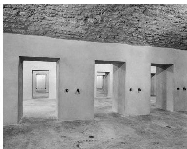
Bâtiment Cavalier, salles successives couvertes de voûtes en berceau segmentaire (en 2000). Phot. Jérôme Mongreville IVR43_20003900196X
