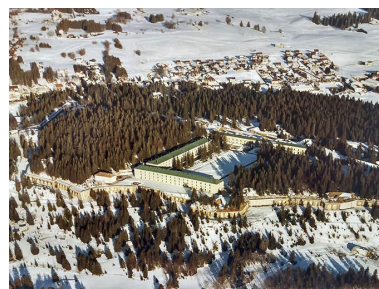
Vue aérienne de l'enceinte du fort. Autr. auteur inconnu IVR43_20243900963NUC2A
