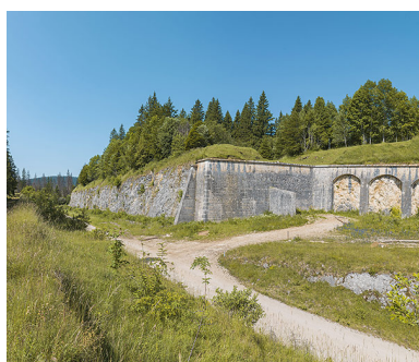
Front est : portion de l'enceinte où le rempart est en roc puis une autre maintenue par des arcs de décharge. Phot. Thierry Kuntz IVR43_20253900415NUC4A
