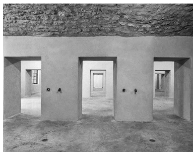
Bâtiment Quitry, pièces successives couvertes de voûtes en berceau segmentaire (en 2000). Phot. Jérôme Mongreville IVR43_20003900195X
