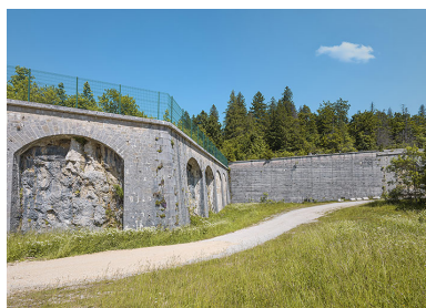
Front ouest : détail d'un arc de décharge avec roc apparent. Phot. Thierry Kuntz IVR43_20253900411NUC4A
