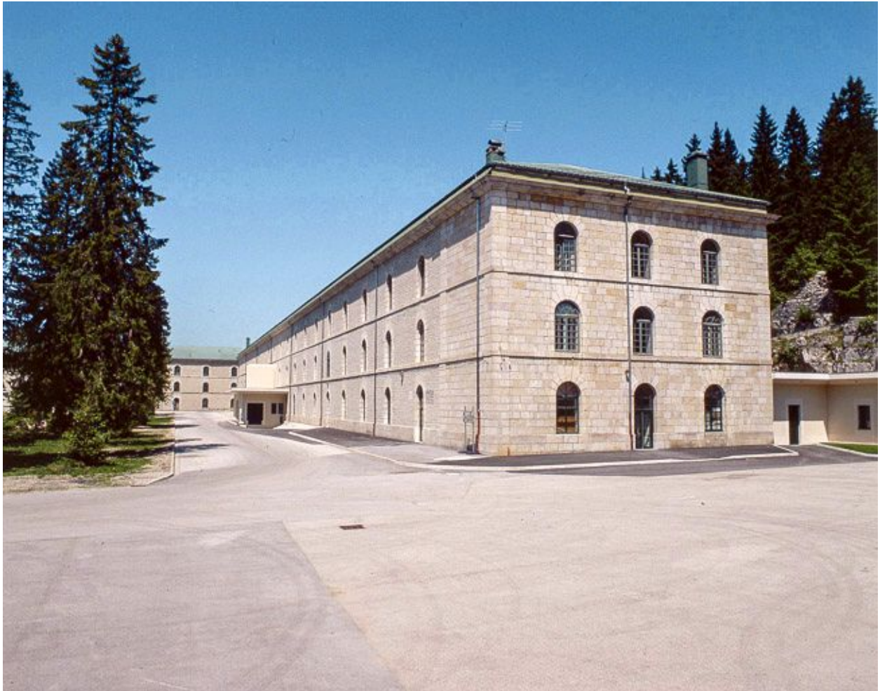
Bâtiment Quitry, façade antérieure et face droite (en 2000).
