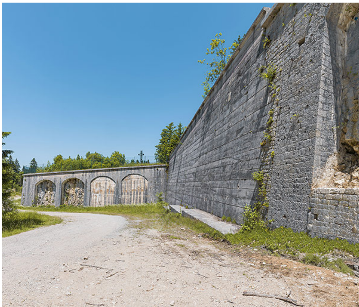
Le mur d'enceinte au front ouest. Des arcs sont hourdis de béton.
