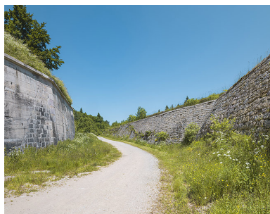
Front est. De gauche à droite : le mur d'escarpe, le fossé et le mur de contrescarpe. Phot. Thierry Kuntz IVR43_20253900395NUC4A
