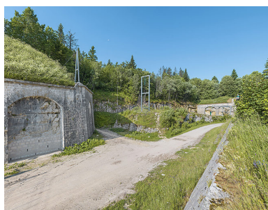
Front nord : la courtine (au centre) flanquée par deux bastions. Phot. Thierry Kuntz IVR43_20253900399NUC4A
