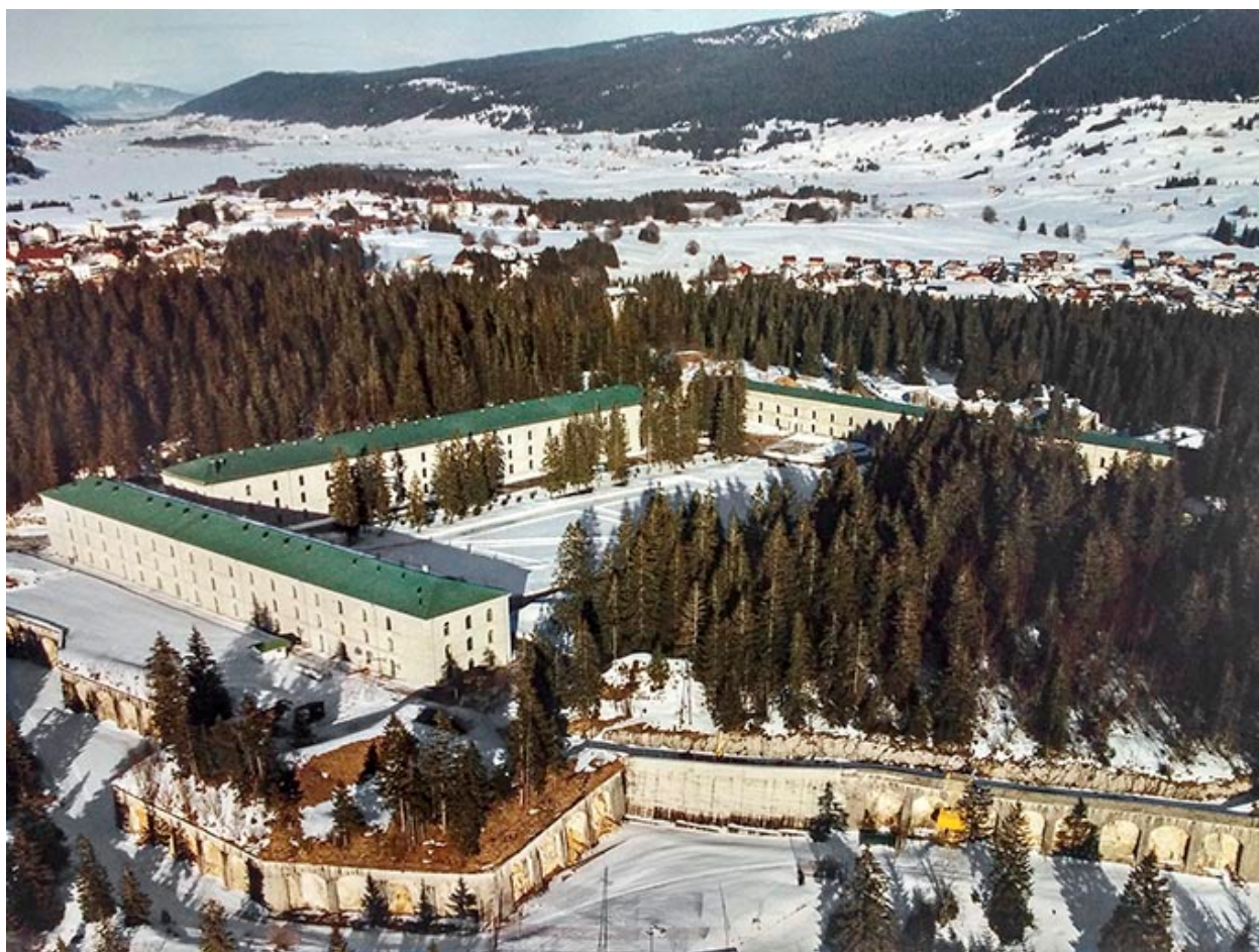
Vue aérienne des casernes et d'un bastion du front ouest.
