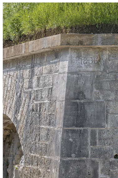
Date portée sur le rempart au front ouest. IVR43_20253900412NUC4A
