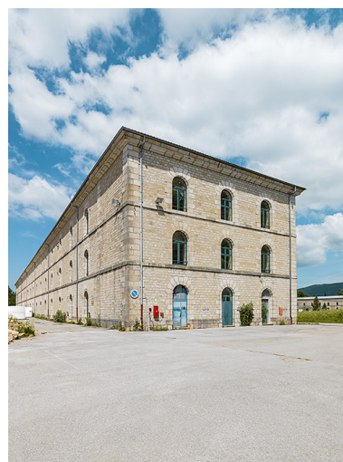
Intérieur de la place : façades latérale et postérieure de la caserne Saint-Germain. Phot. Thierry Kuntz IVR43_20253900385NUC4A
