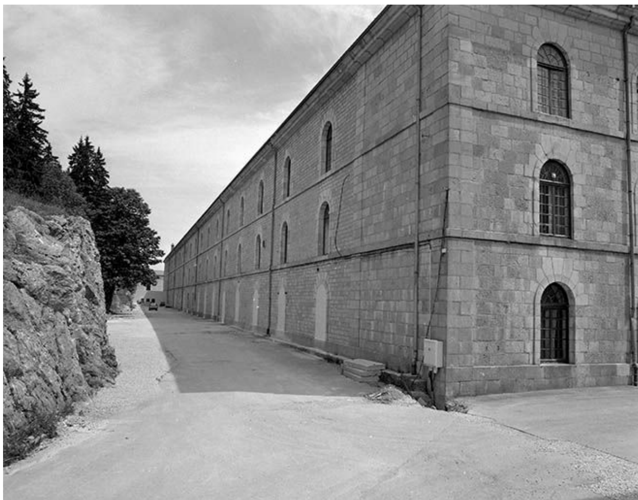
Bâtiment Quitry, façade postérieure (en 2000).
