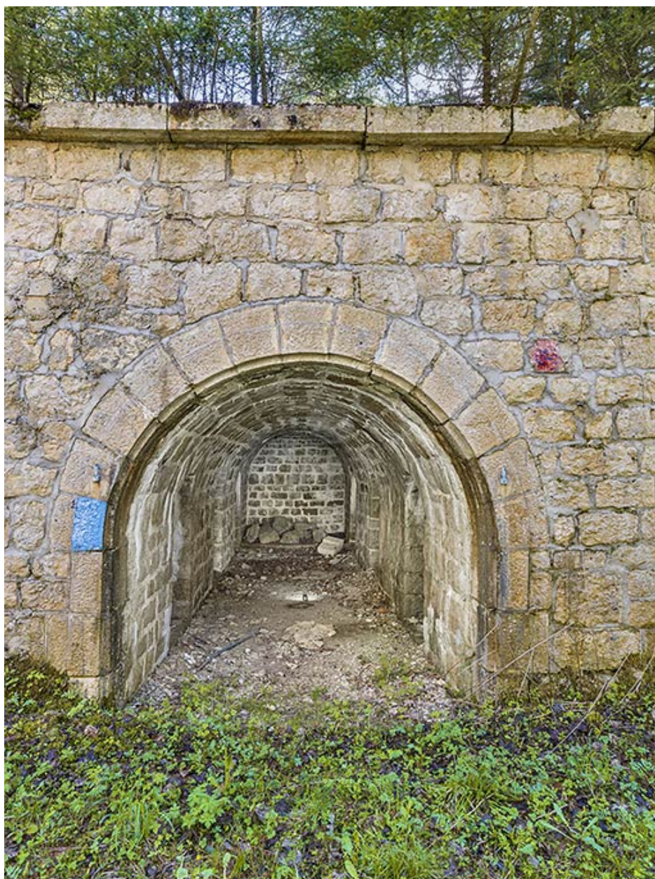
La casemate de la traverse-abri.
