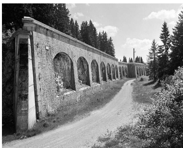
Enceinte du fort (en 2000). Phot. Jérôme Mongreville IVR43_20003900191X
