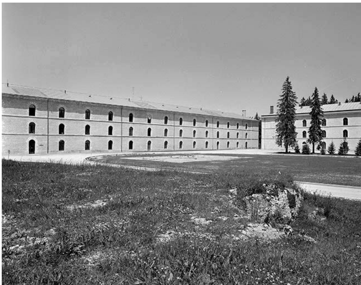
Bâtiment Saint-Germain, façade antérieure (en 2000).
