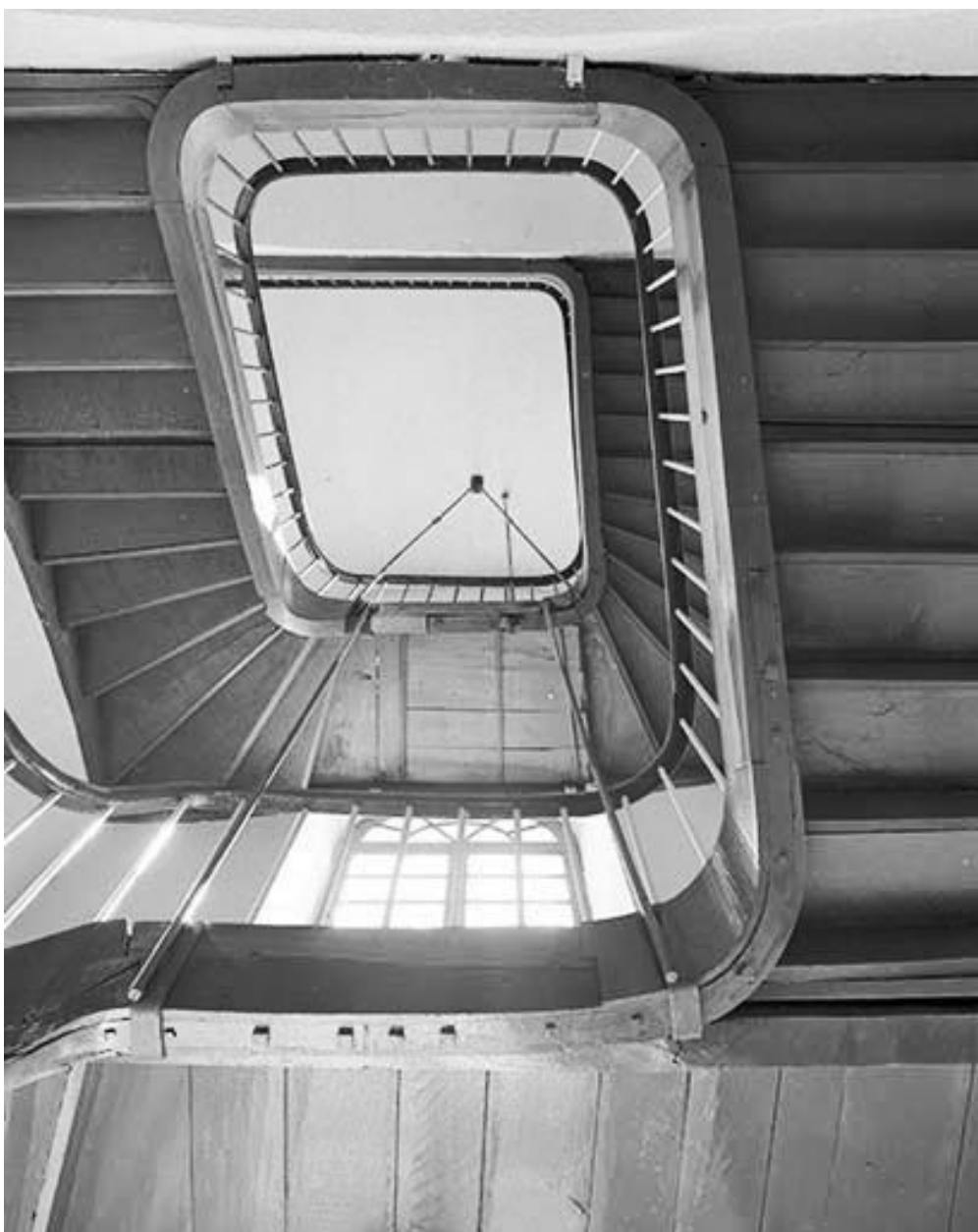
Bâtiment Quitry, escalier intérieur (en 2000).
