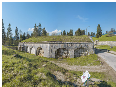
La demi-lune, vue de profil. Phot. Thierry Kuntz IVR43_20253900134NUC4A
