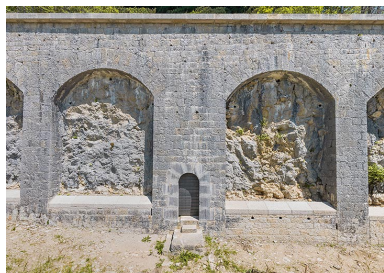
Front ouest : le rempart soutenu par ses arcs de décharge. Phot. Thierry Kuntz IVR43_20253900404NUC4A
