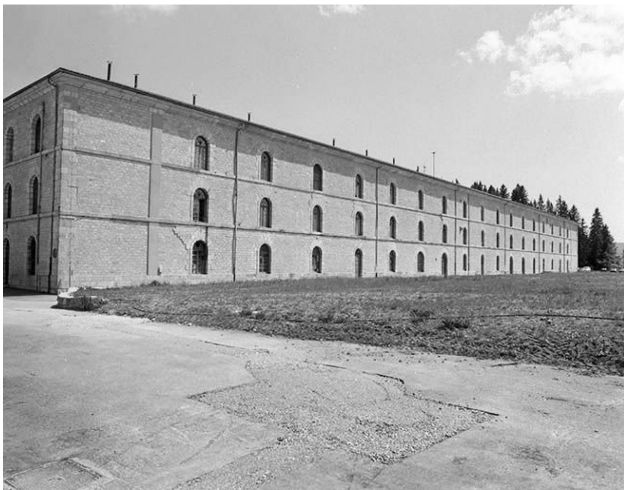
Bâtiment Saint-Germain, façade postérieure (en 2000).
