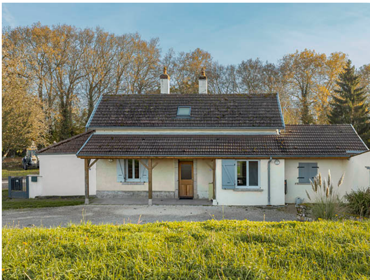
Vue de face de la maison.
