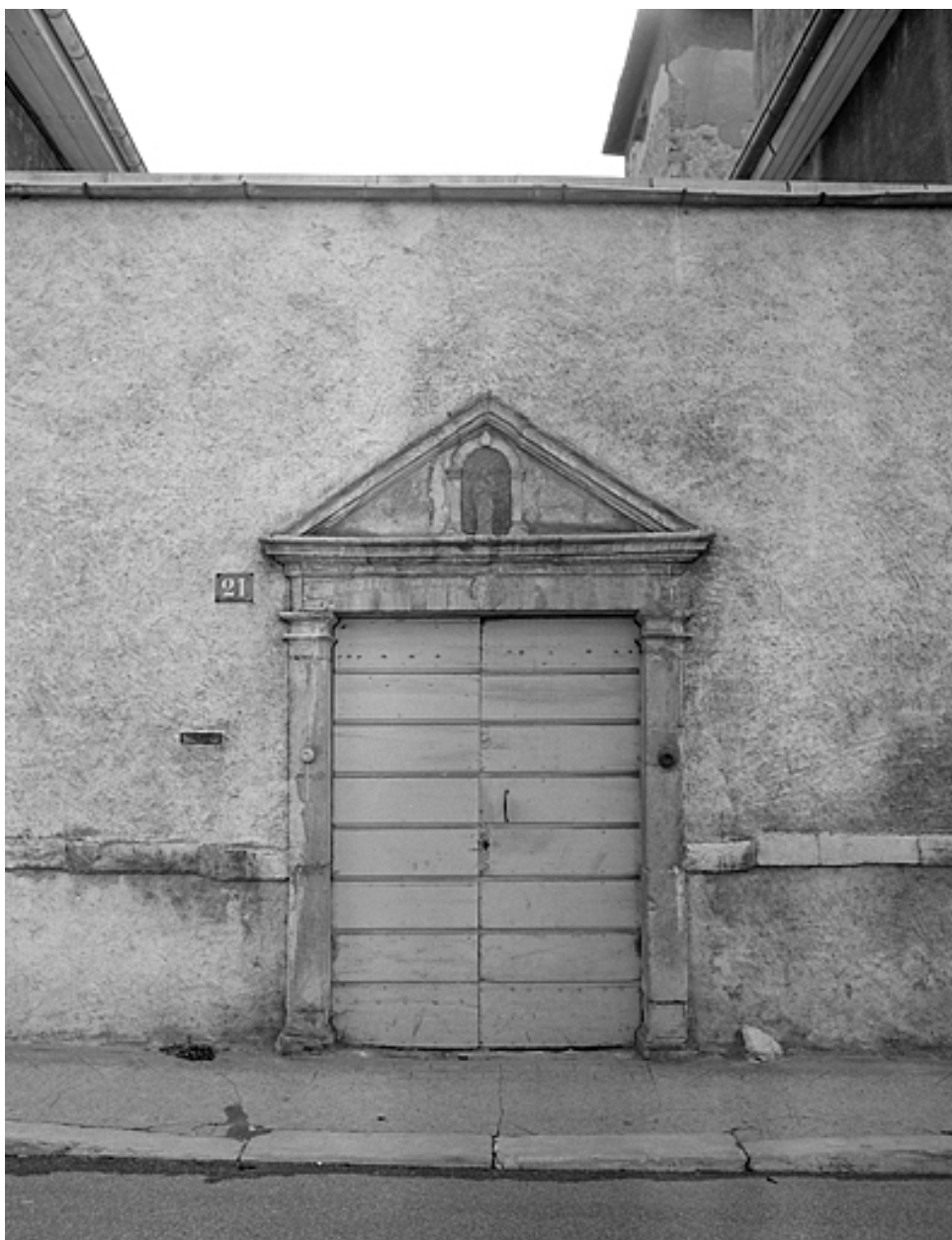
Façade antérieure, porte d'entrée.
