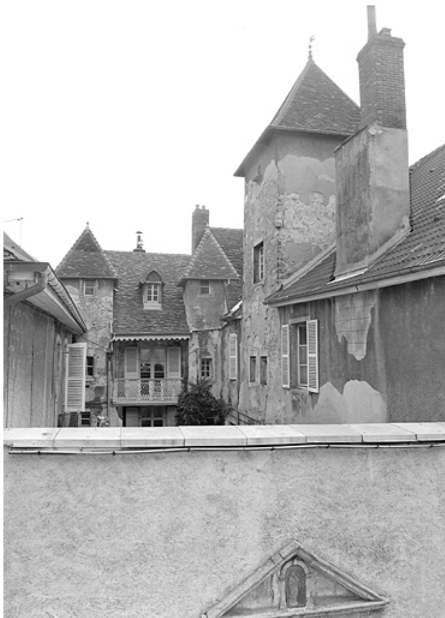
Vue partielle des façades sur la cour.
