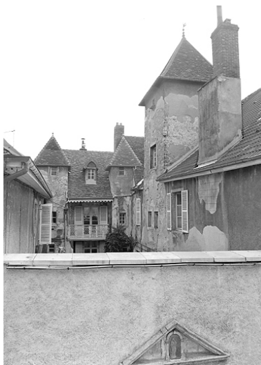
Vue partielle des façades sur la cour. Phot. Yves Sancey IVR43_19833900520X
