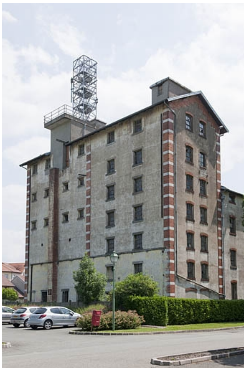
La malterie vue depuis le nord-ouest.
