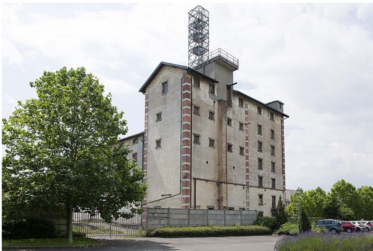
La malterie vue depuis le nord-est.
