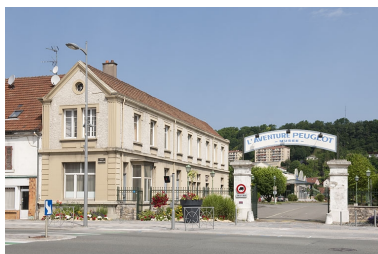
Entrée de l'établissement. Phot. Jérôme Mongreville IVR43_20122501817NUC4A
