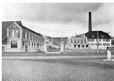
Vue d'ensemble de l'entrée. Phot. Raphaël Favereaux, Autr. IVR43_20122501317NUC2A
