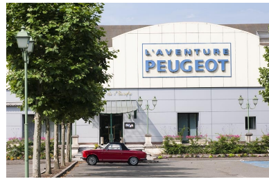
Détail de la façade est du musée. Phot. Jérôme Mongreville IVR43_20122501814NUC4A
