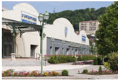
Façade est du musée. Phot. Jérôme Mongreville IVR43_20122501812NUC4A
