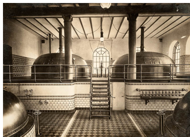
Chaudières à houblonner. Phot. Jérôme Mongreville IVR43_20132500476NUC4A
