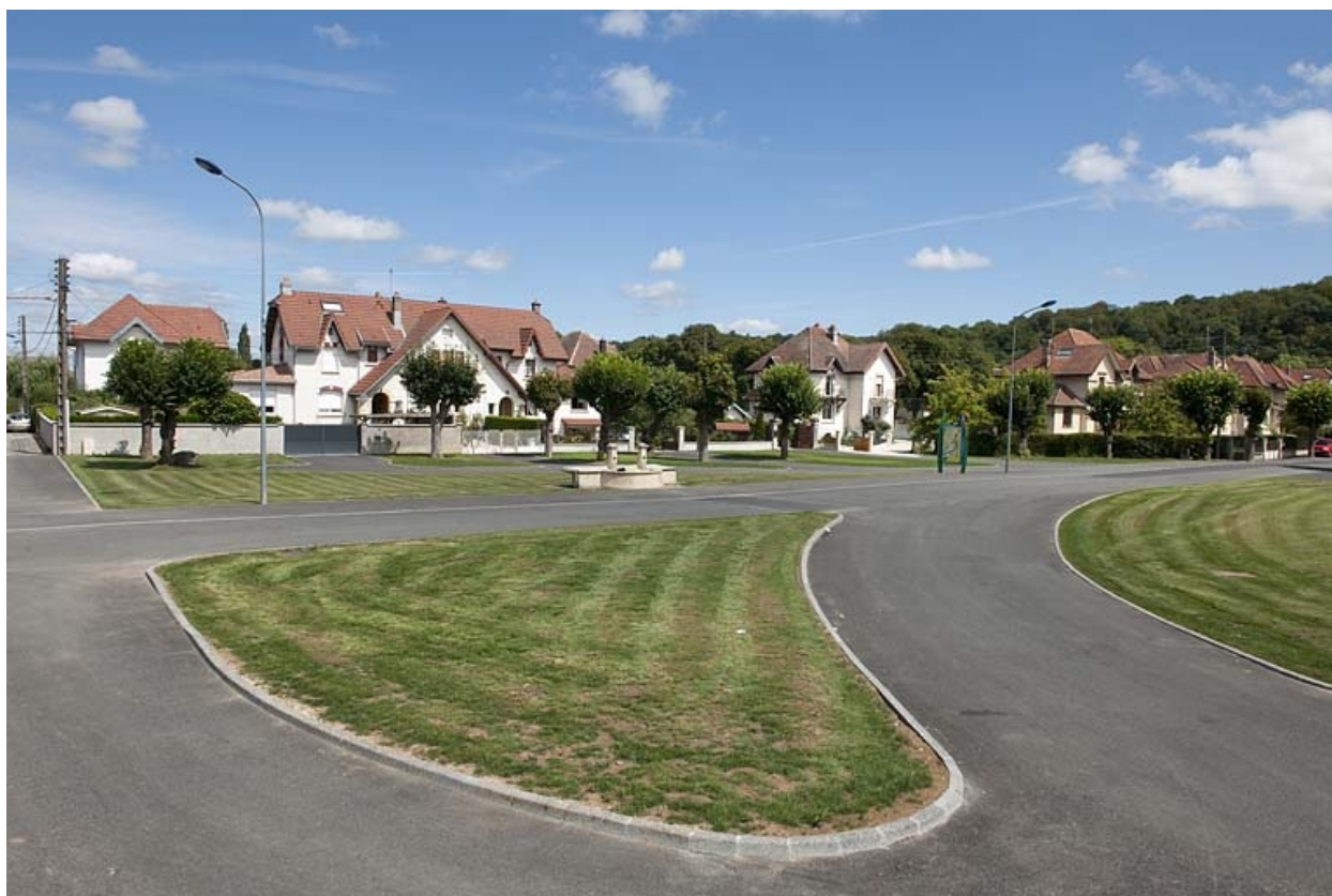
Vue d'ensemble depuis l'avenue Frédéric Bataille.
