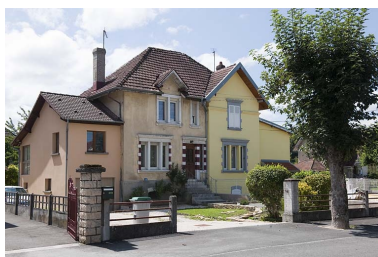
Maison mitoyenne. Phot. Jérôme Mongreville IVR43_20112502257NUC4A
