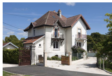
Maison individuelle. Phot. Jérôme Mongreville IVR43_20112502258NUC4A
