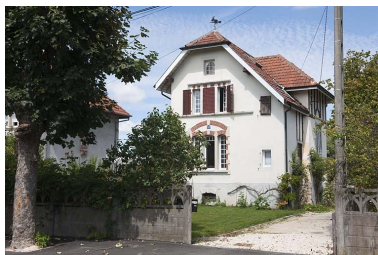
Maison individuelle. Phot. Jérôme Mongreville IVR43_20112502254NUC4A
