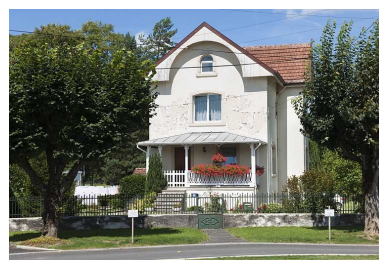
Maison individuelle. Phot. Jérôme Mongreville IVR43_20112502265NUC4A
