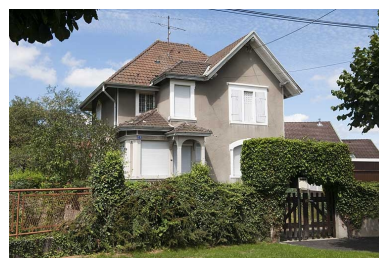
Maison individuelle. Phot. Jérôme Mongreville IVR43_20112502262NUC4A
