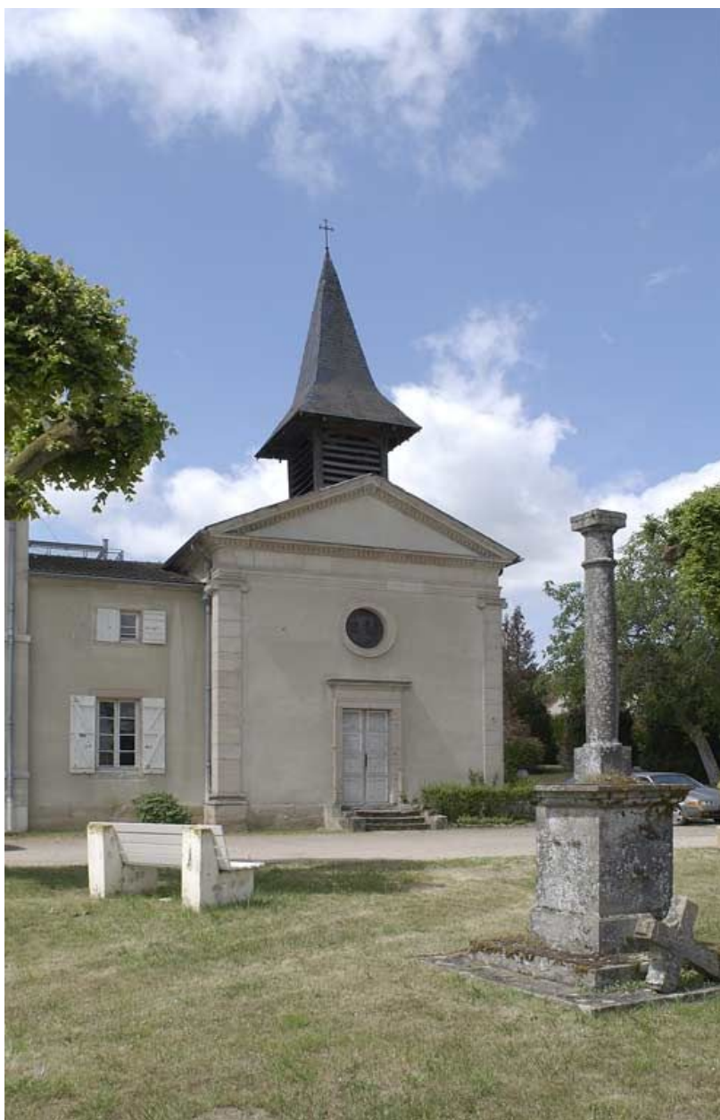
Façade antérieure de la chapelle et croix.
