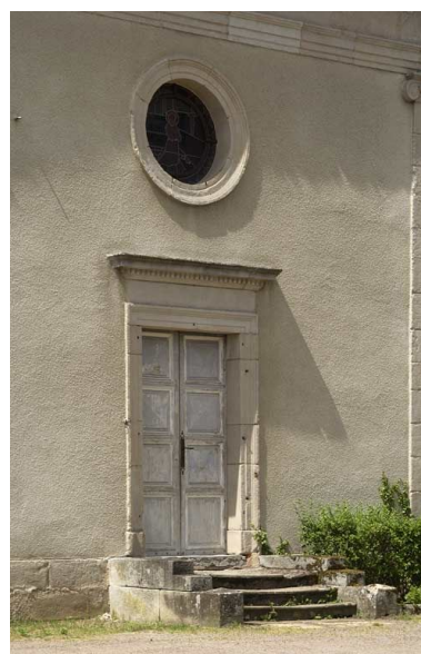
Porte de la chapelle surmontée d'un oculus.
