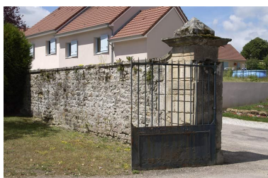
Revers du portail d'entrée. Phot. Michel Thierry IVR26_20047100372NUC2A
