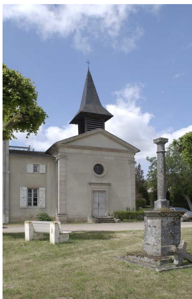
Façade antérieure de la chapelle et croix.
