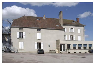
Façade postérieure. Phot. Michel Thierry IVR26_20047100366NUC2A
