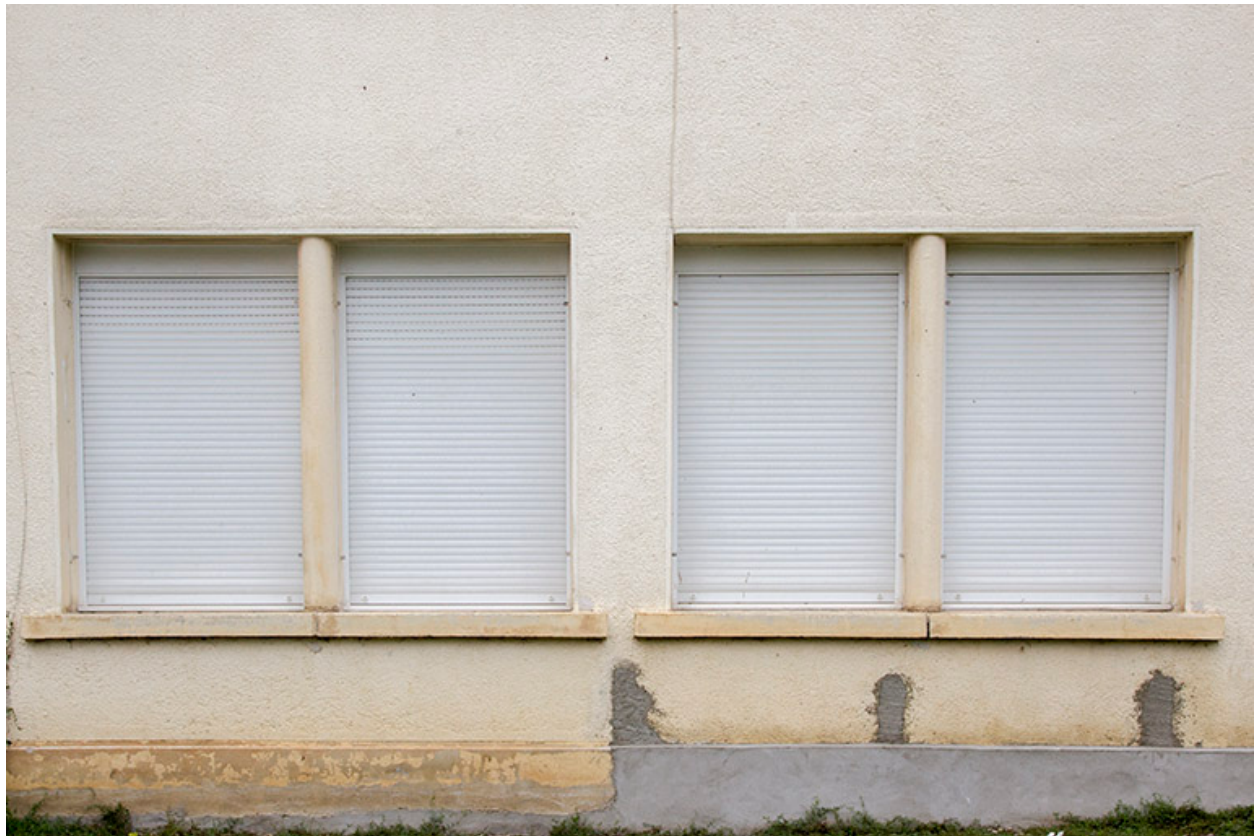
Usine : fenêtres horlogères de la façade antérieure.
