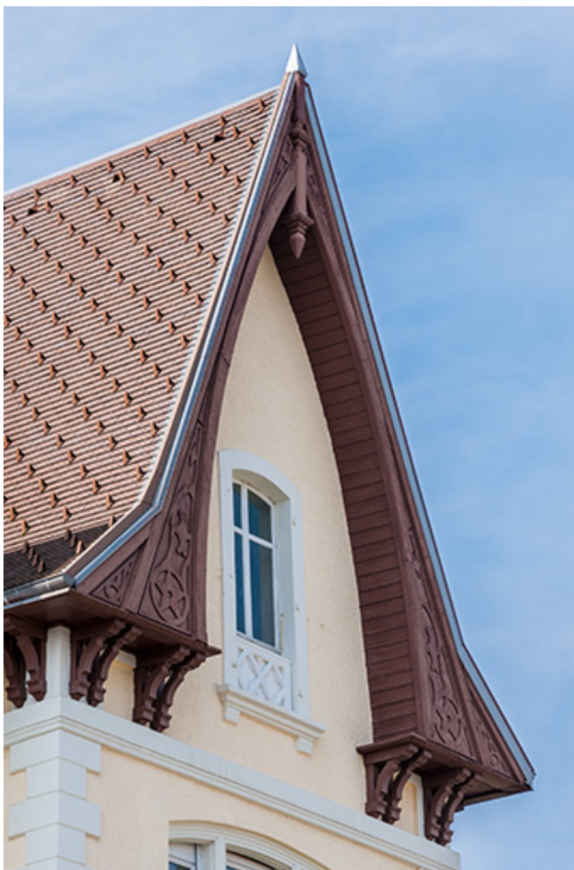
Logement patronal : pignon de la façade antérieure.
