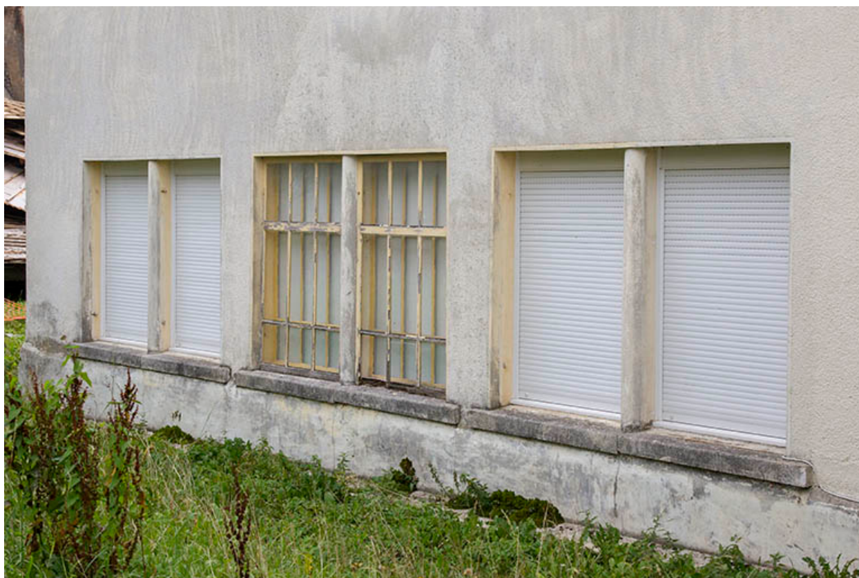
Usine : fenêtres horlogères de la façade postérieure.
