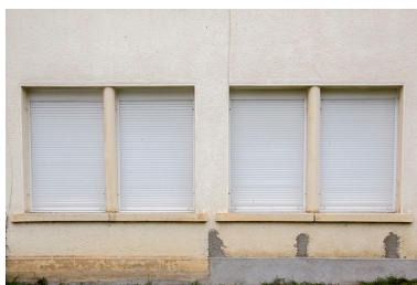
Usine : fenêtres horlogères de la façade antérieure.
