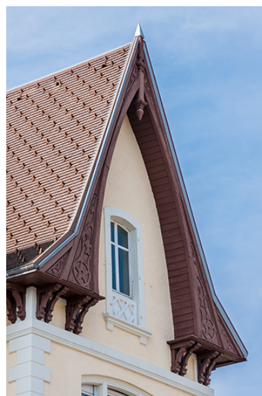
Logement patronal : pignon de la façade antérieure.
