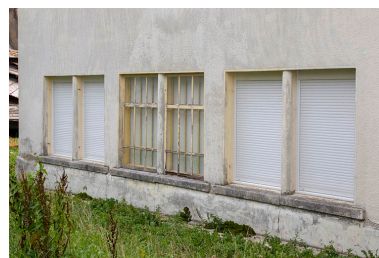
Usine : fenêtres horlogères de la façade postérieure.
