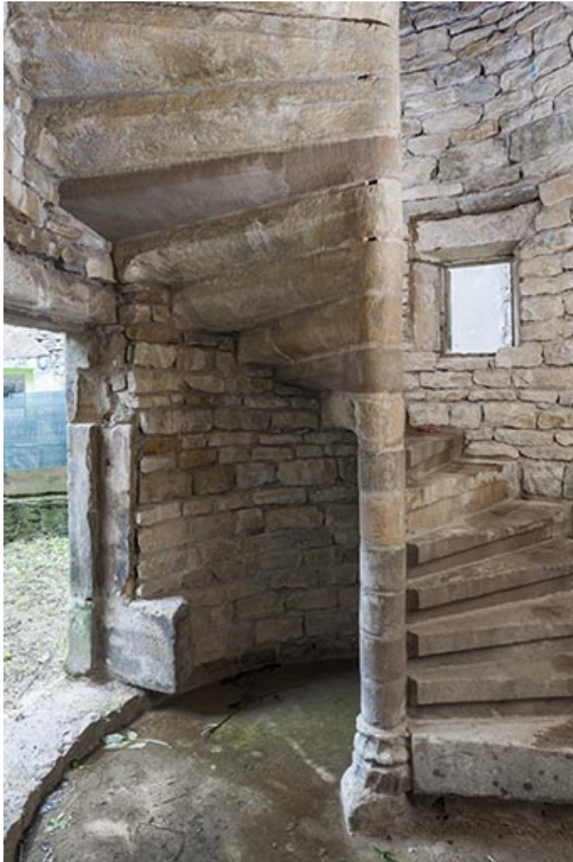
Intérieur de la tour : escalier en vis.
