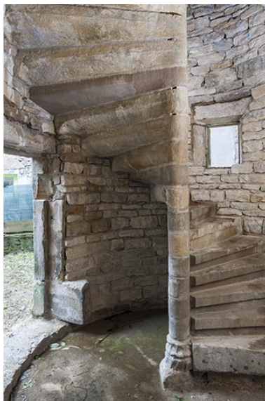
Intérieur de la tour : escalier en vis. Phot. Jérôme Mongreville IVR43_20137000015NUC4A
