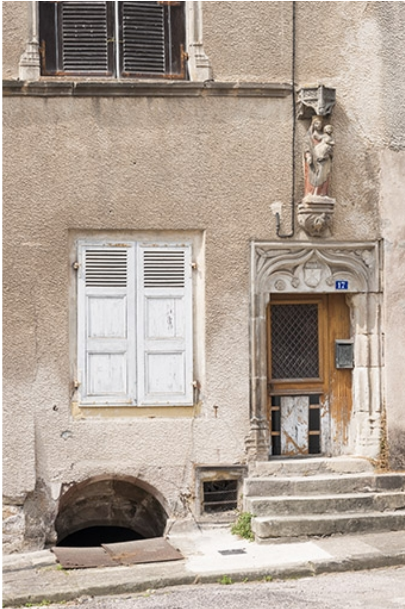
Façade antérieure : détail du rez-de-chaussée.
