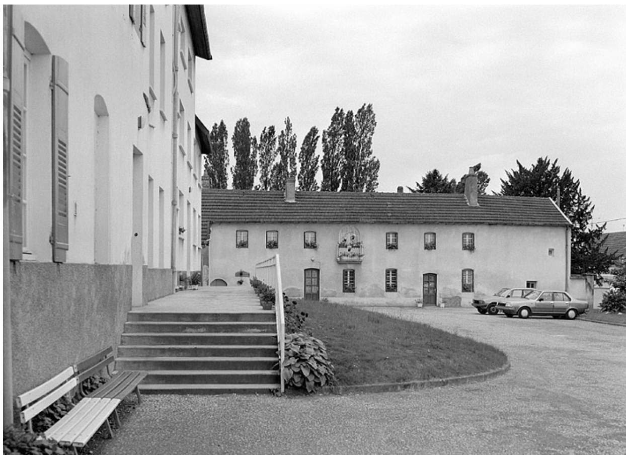
Vue d'ensemble du bâtiment droit.
