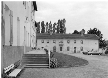
Vue d'ensemble du bâtiment droit. Phot. Yves Sancey IVR43_19927000216X
