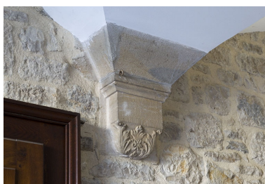
Logis principal, passage cocher : détail d'un support de la voûte. Phot. Yves Sancey IVR43_20112502760NUC2A
