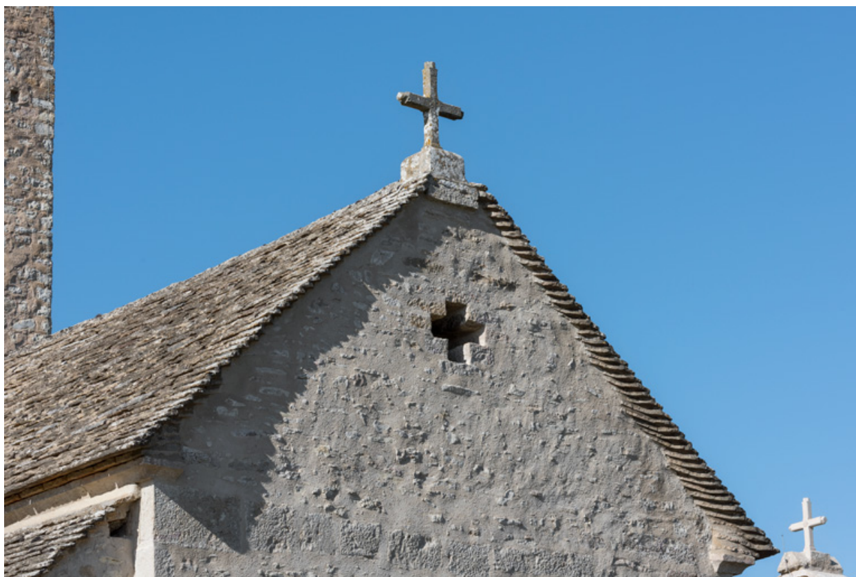
Pignon couvert de la façade.
