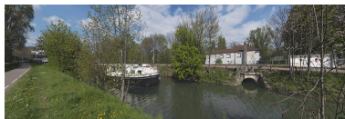
Entrée de la rigole dans l'Ouche. Phot. Thierry Kuntz IVR26_20112102810NUC4AQ
