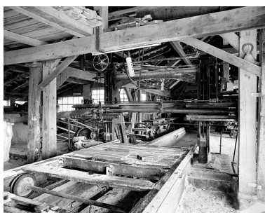
Châssis de scie horizontale monolame. Phot. Yves Sancey IVR43_19999000182X
