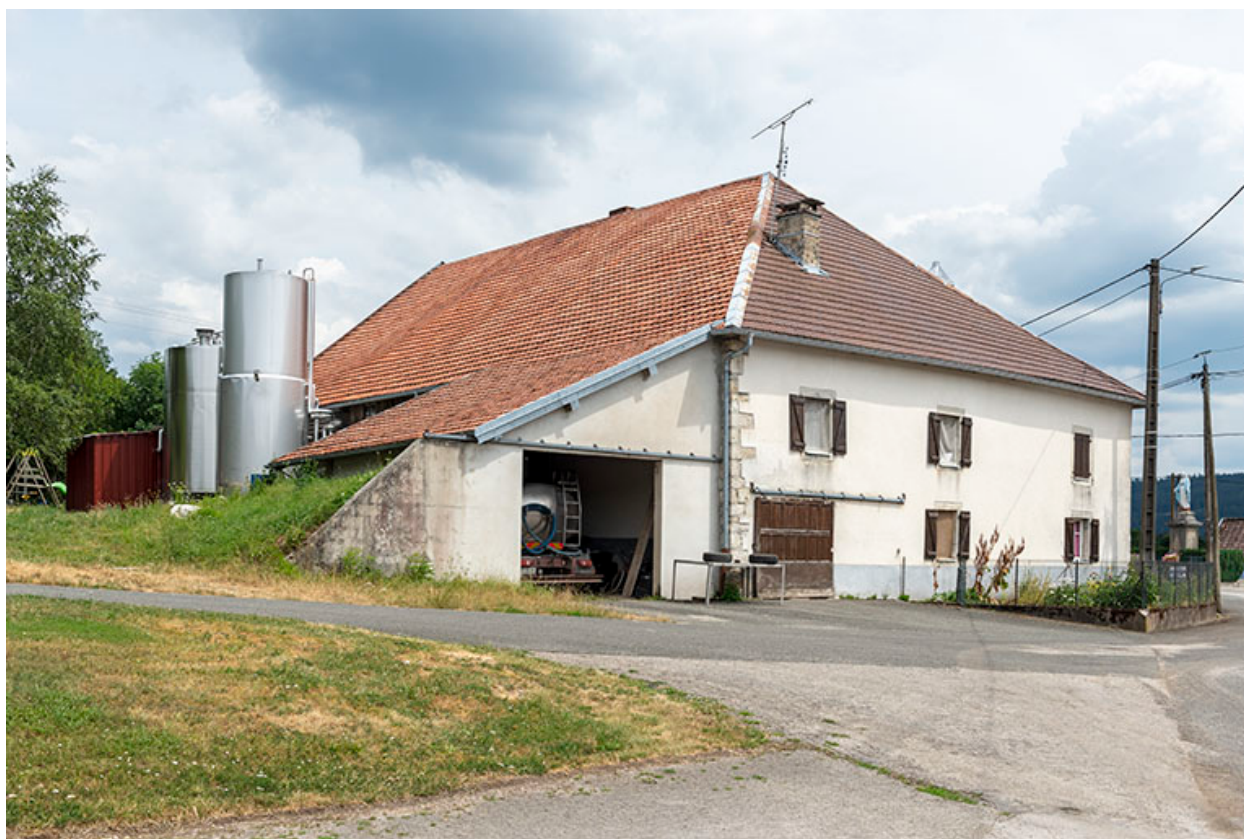
Façade latérale gauche, de trois quarts.
