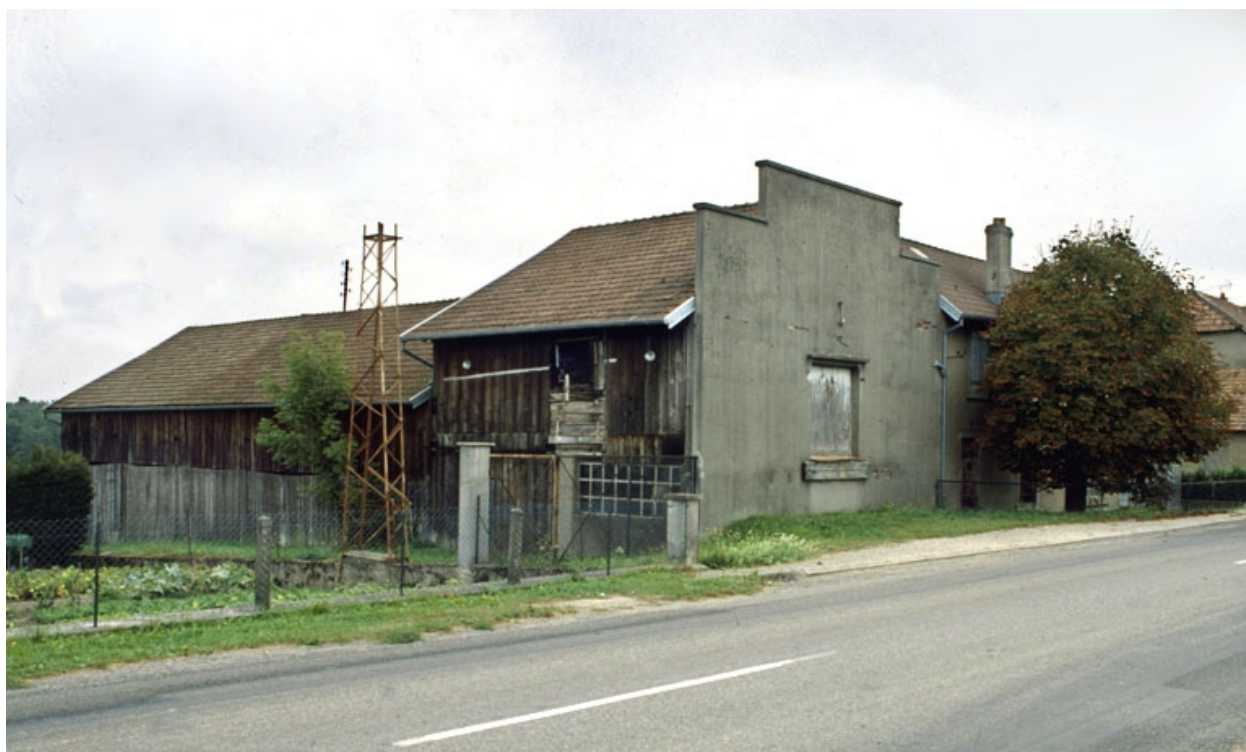
Magasin et entrepôt industriel.
