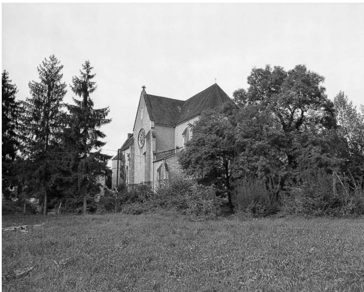
Façade latérale droite.
