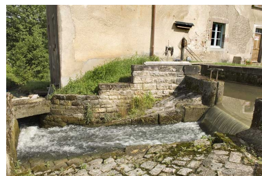
Le vannage et la chaussée du bief de dérivation. Phot. Jérôme Mongreville IVR43_20097000508NUC2A
