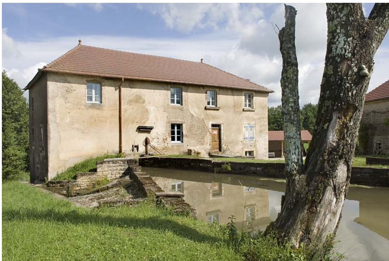
Façade sud du moulin.
