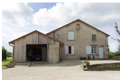
Façade antérieure du logement du moulin. Phot. Jérôme Mongreville IVR43_20097000501NUC2A
