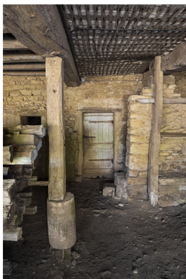
Un fenil a été aménagé au-dessus du hangar. Son plancher est constitué de solives en bois, entre lesquelles s'intercalent des bottes de paille. Le tout est couvert de lattes. Phot. Pierre-Marie Barbe-Richaud IVR26_20197100204NUC4A
