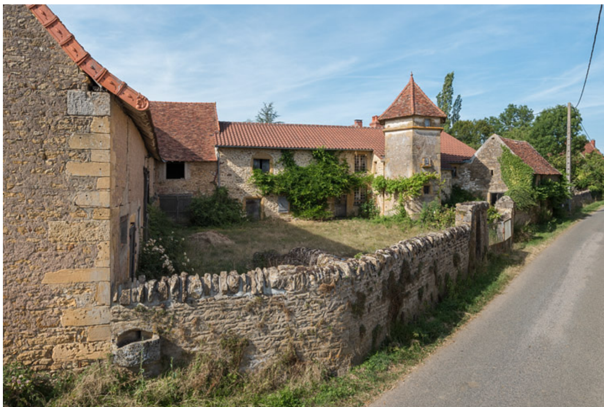
Vue d'ensemble des bâtiments du domaine
