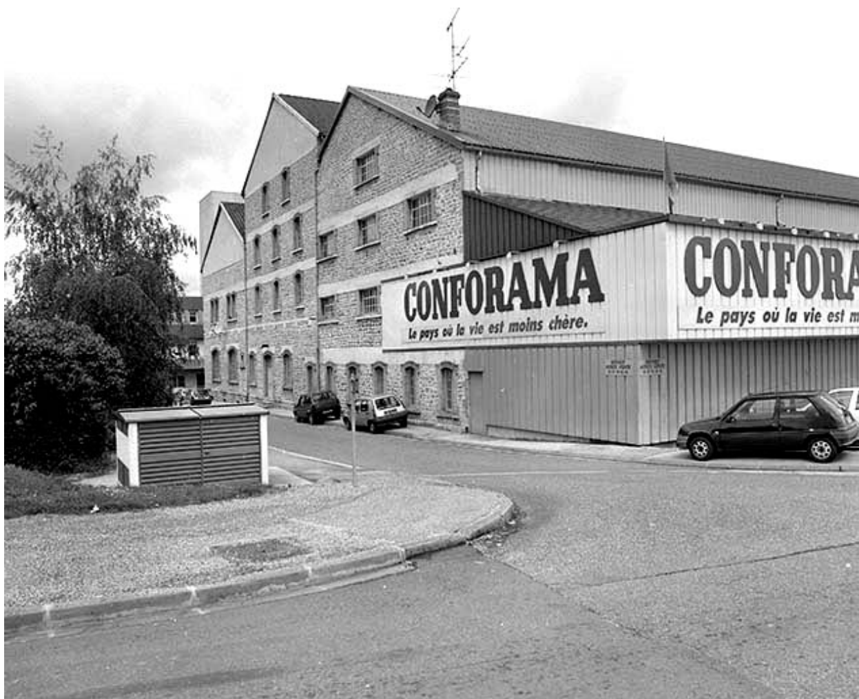
Murs-pignons de l'atelier de fabrication.
