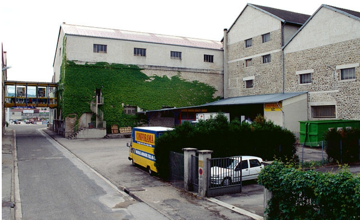
Atelier de fabrication depuis le nord-ouest.
