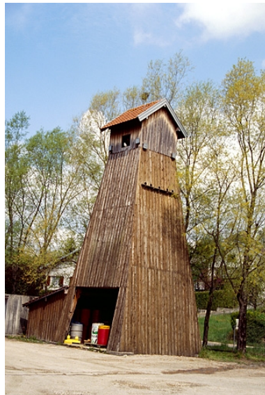
Chevalement du puits n° 7 en 1994. Phot. Laurent Poupard IVR43_19943900241ZA
