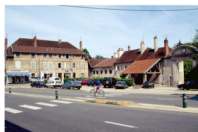
Logements d'ouvriers, bureau et portail.
