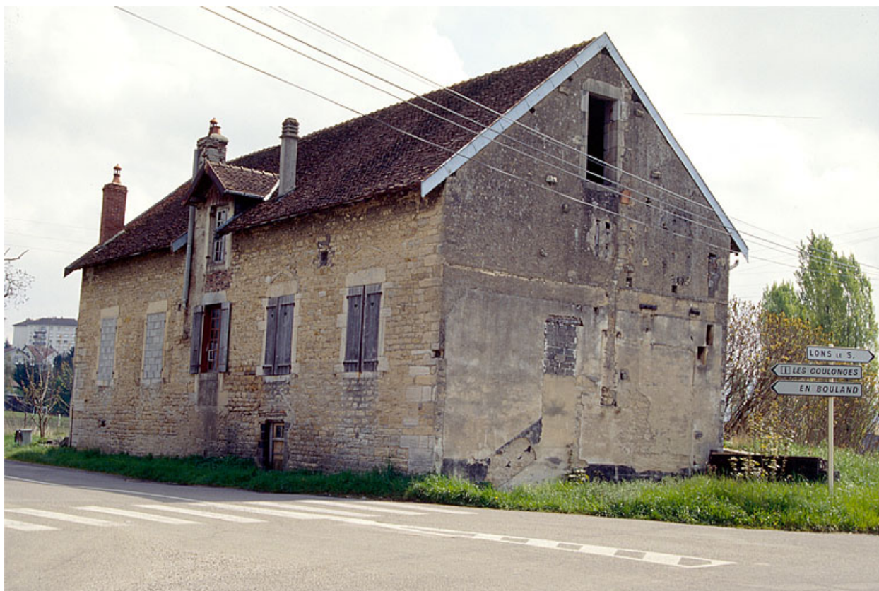
Bâtiment d'une turbine.
