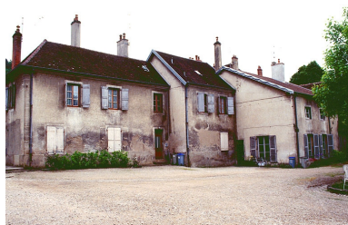
Logement et bureau depuis le nord-est. Phot. Jérôme Mongreville IVR43_19963900560ZA
