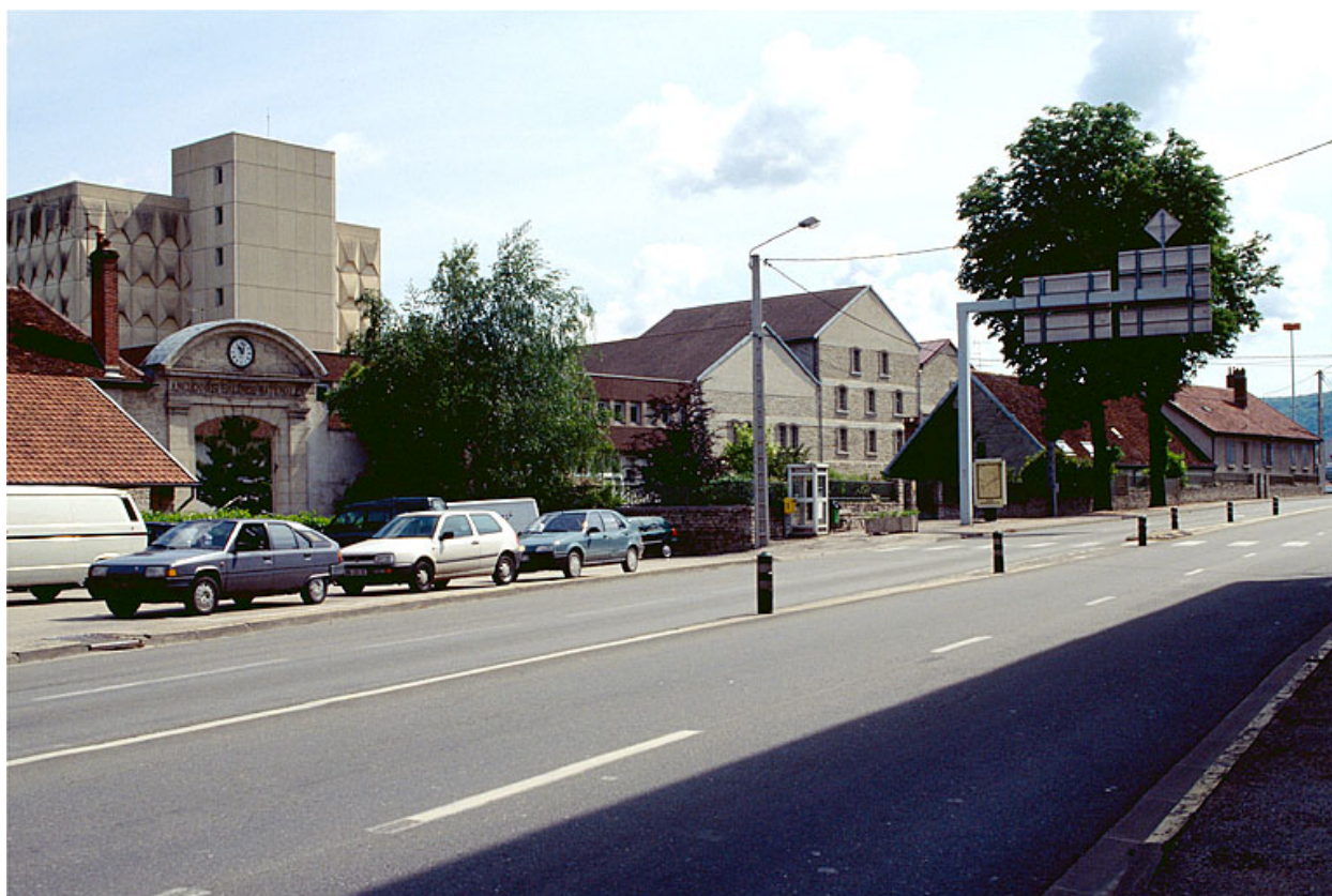
Vue d'ensemble depuis l'ouest en 1996.
