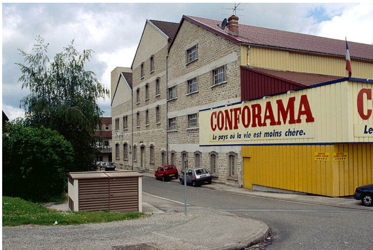
Vue d'ensemble de l'atelier de fabrication nord.
