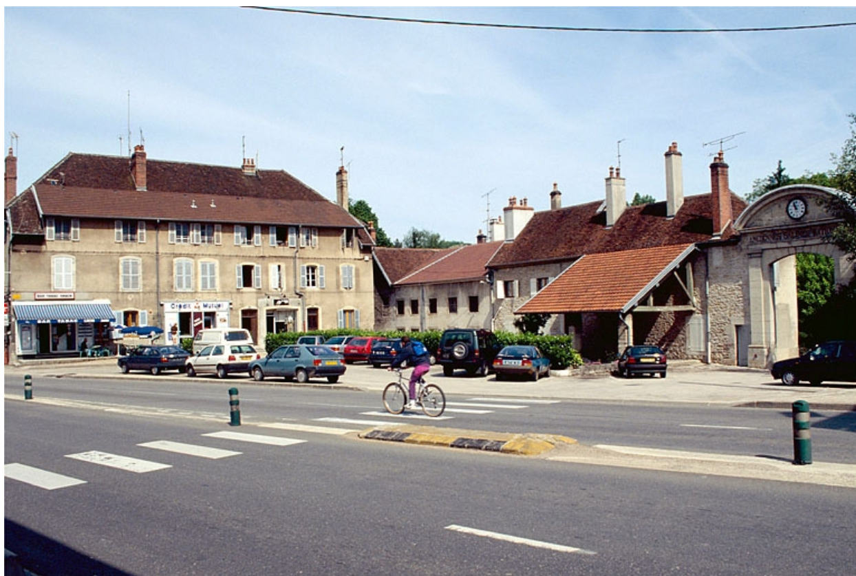
Logements d'ouvriers, bureau et portail.
