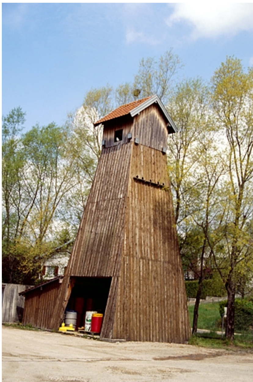
Chevalement du puits n° 7 en 1994.
