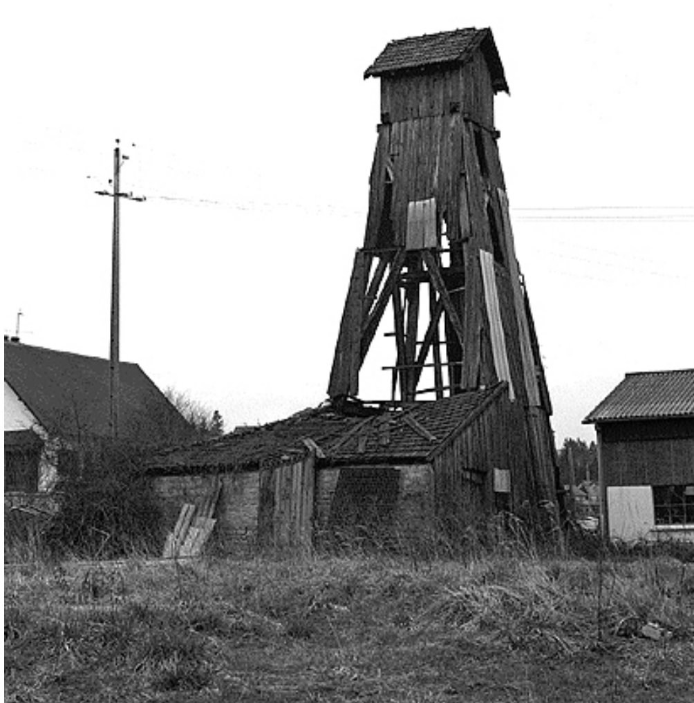
Chevalement du puits n° 10 en 1985.
