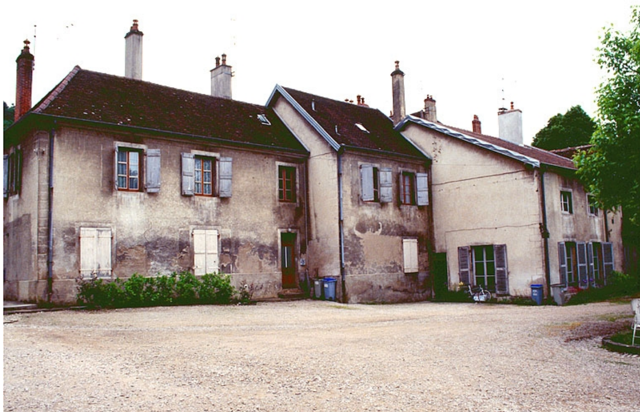
Logement et bureau depuis le nord-est.
