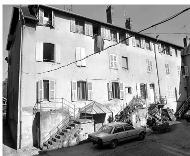
Façade postérieure du logement d'ouvriers. Phot. Jérôme Mongreville IVR43_19963900561X
