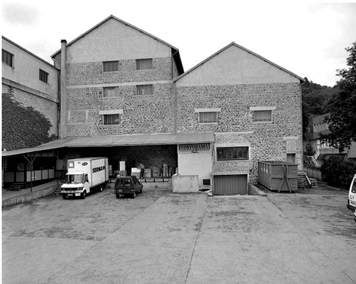
Murs-pignons postérieurs de l'atelier de fabrication.
