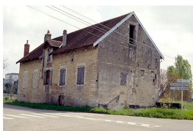
Bâtiment d'une turbine. Phot. Laurent Poupard IVR43_19943900242ZA
