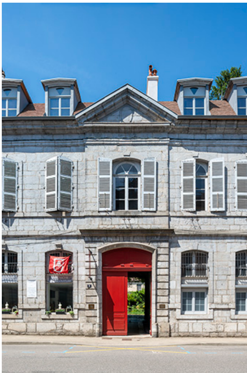
Façade antérieure. Travées centrales.
