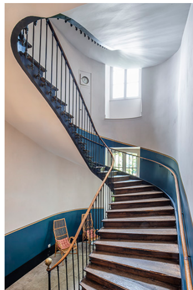
Cage d'escalier (aile nord). Phot. Jérôme Mongreville IVR43_20233900470NUC4A
