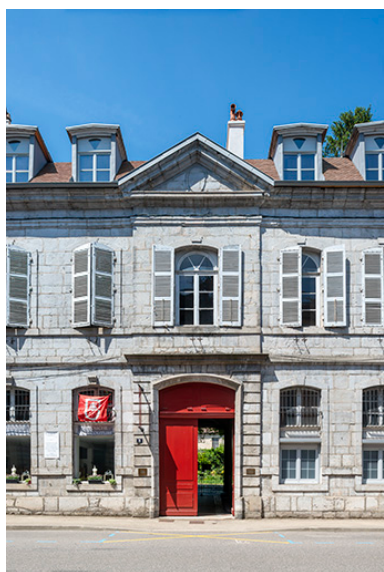
Façade antérieure. Travées centrales. Phot. Jérôme Mongreville IVR43_20233900853NUC4A
