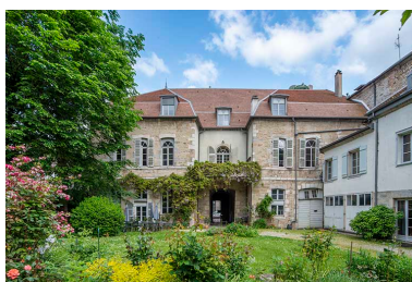
Façade postérieure vue depuis le jardin. Phot. Jérôme Mongreville IVR43_20233900463NUC4A
