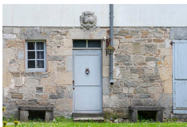
Détail du mur nord des communs. Phot. Jérôme Mongreville IVR43_20233900467NUC4A
