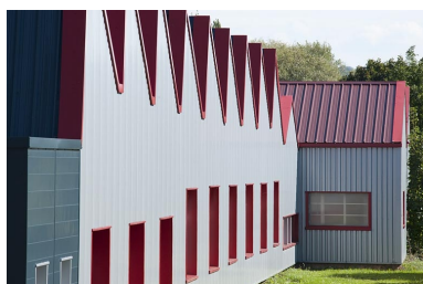
Détail du bardage de la façade sud.
