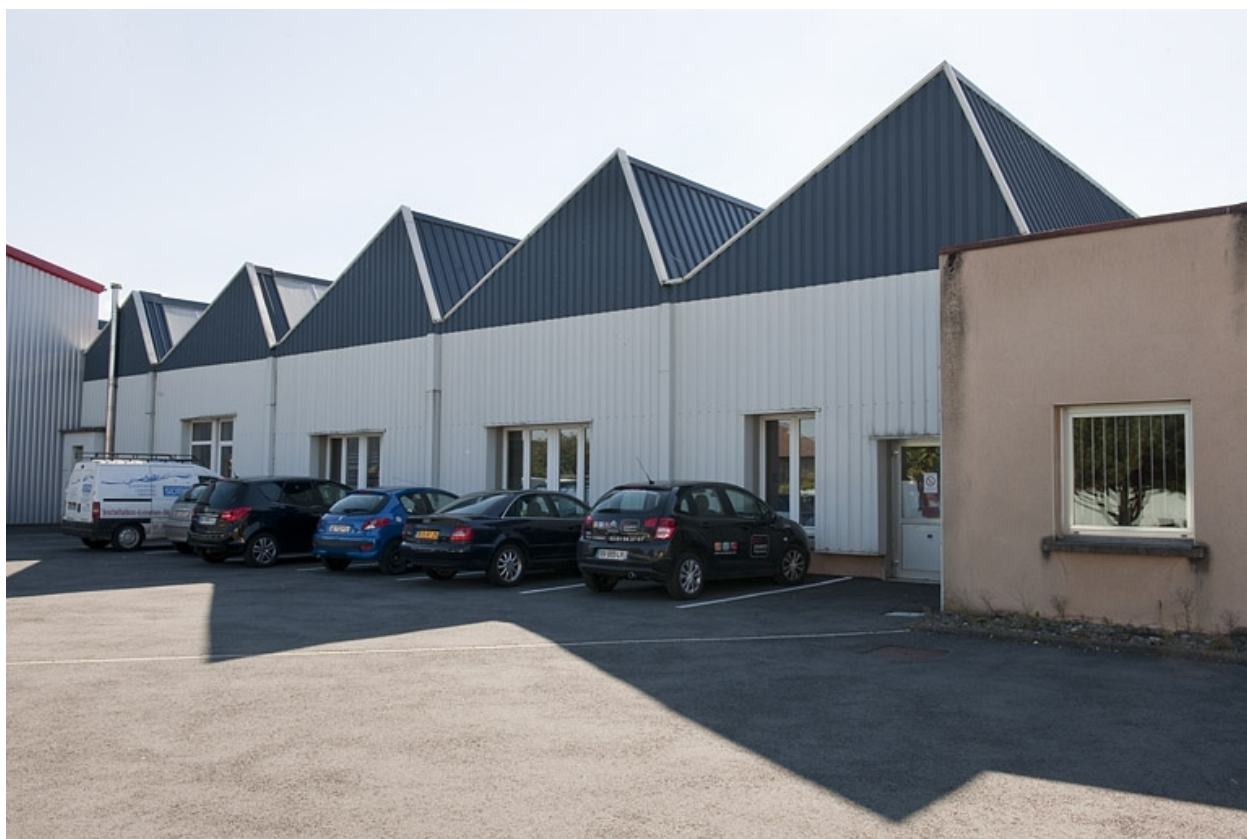
Bardage de la façade nord.
