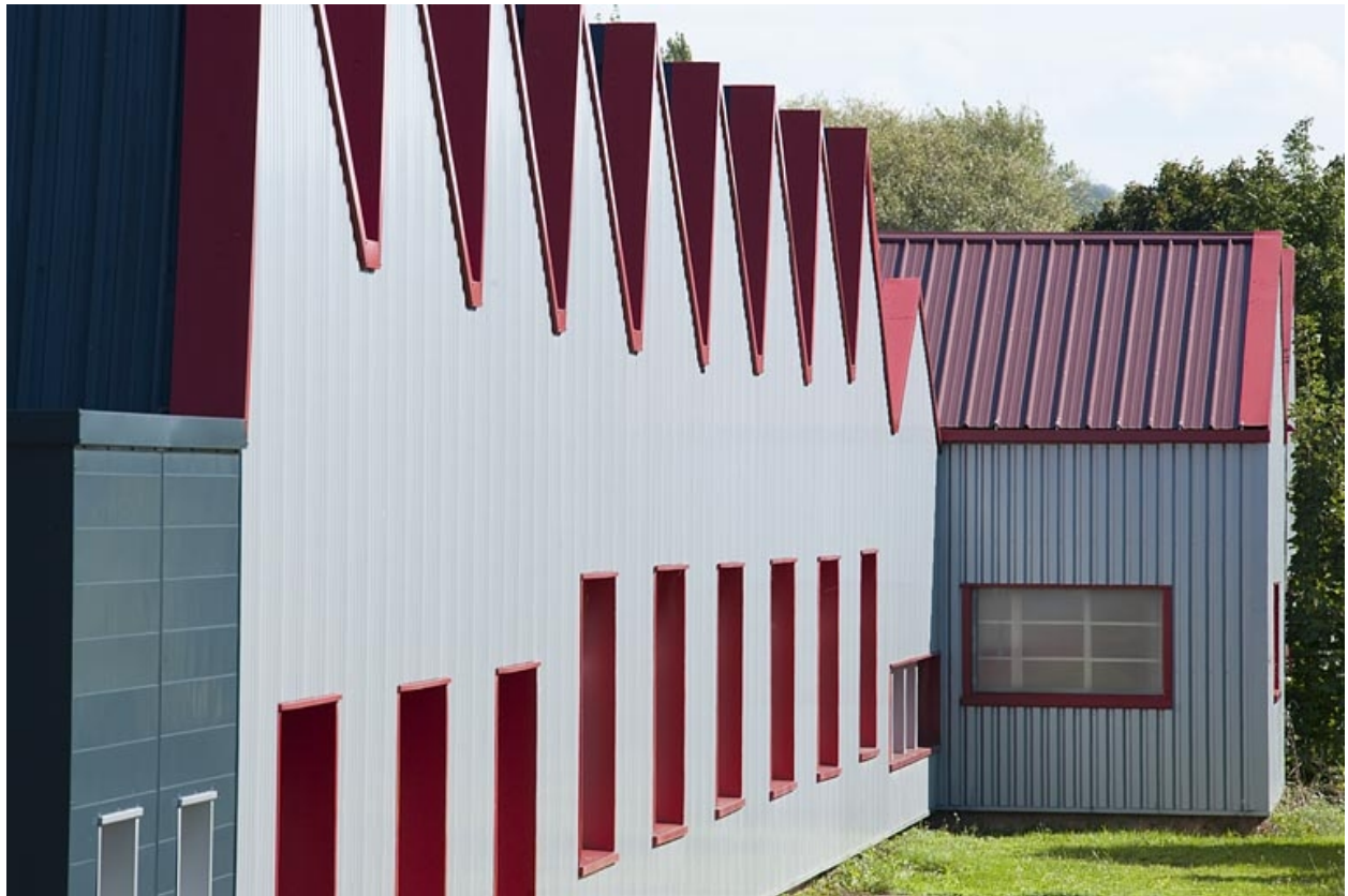
Détail du bardage de la façade sud.
