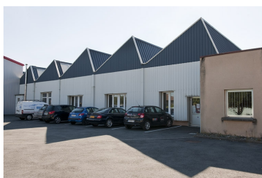
Bardage de la façade nord.
