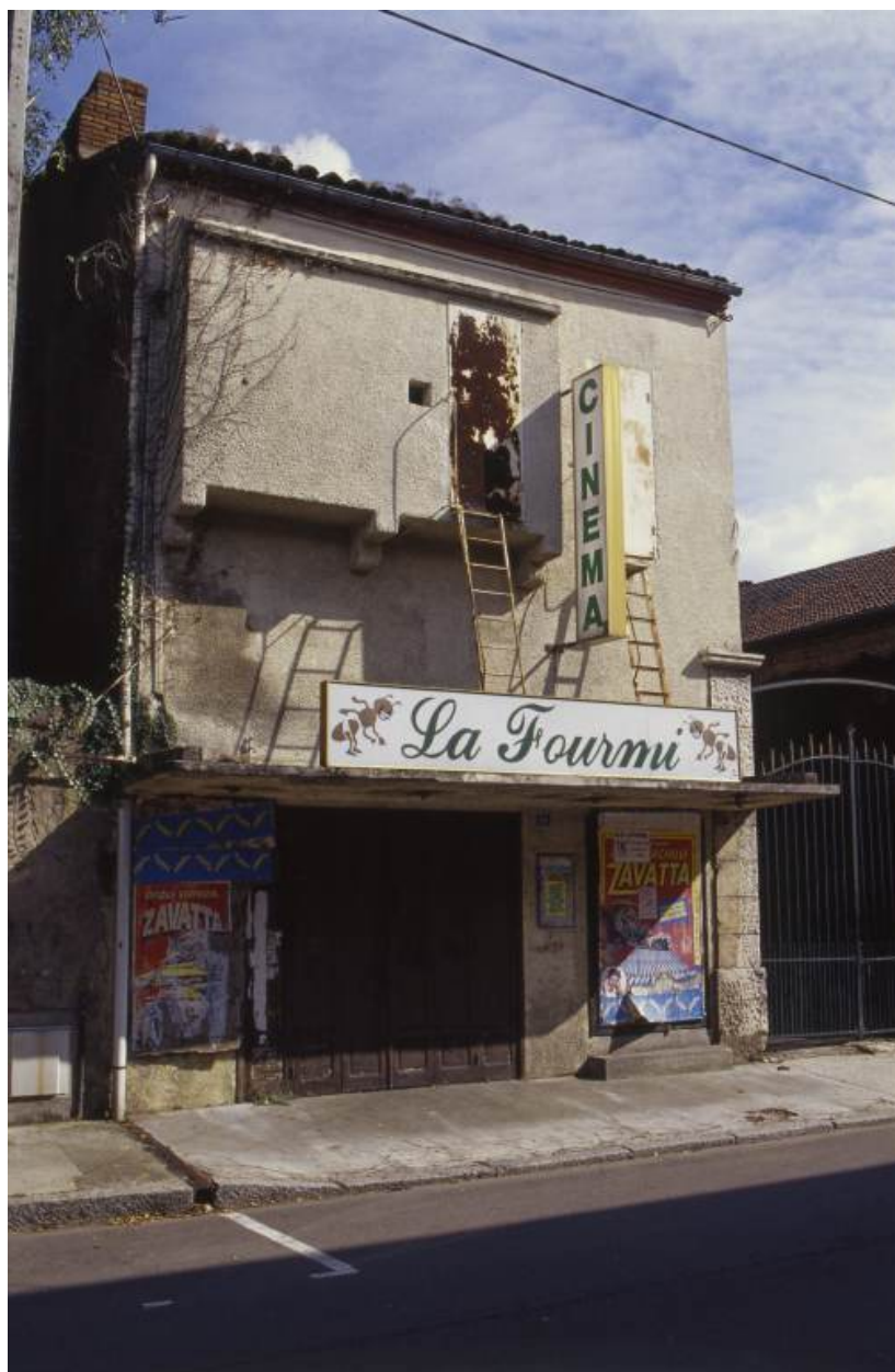
Vue d'ensemble de l'ancien cinéma La fourmi.
